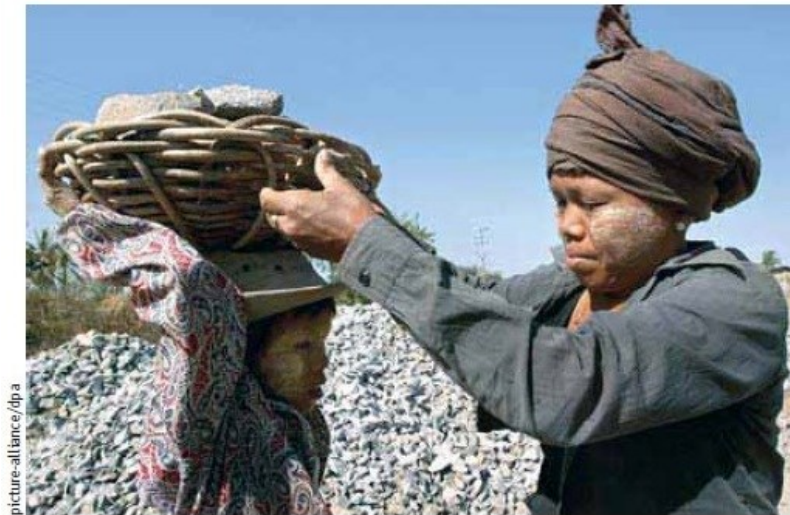
Der 13-jährige Daw Phyoung arbeitet zusammen mit seinem Vater im Straßenbau und muss Steine schleppen. Er arbeitet für weniger als einen US-Dollar am Tag. Weder er noch einer seiner zwei Brüder können zur Schule gehen.
