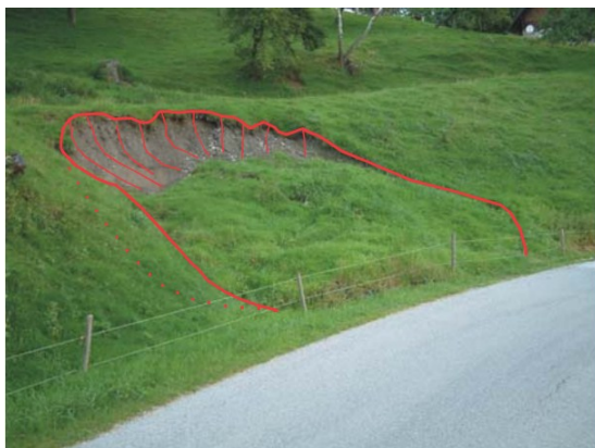
Abb. 3: Rotationsrutschung (links) und (flachgründige) Translationsrutschung (rechts). Quelle: GBA (o. J.) nach TILCH, N. (Fotoarchiv der GBA)
