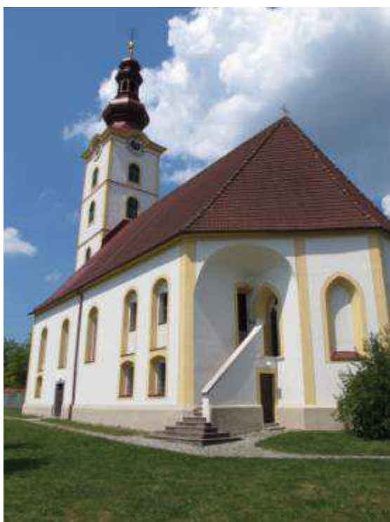
Abb. 439. Kirchbach in Stmk., Pfarrkirche, Außenansicht
