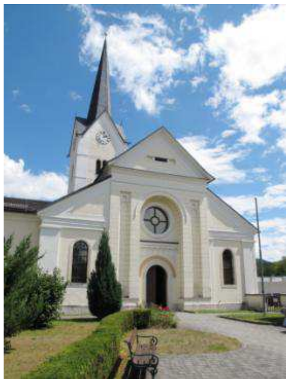
Abb. 603. St. Kanzian a. K., Pfarrkirche, Außenansicht
