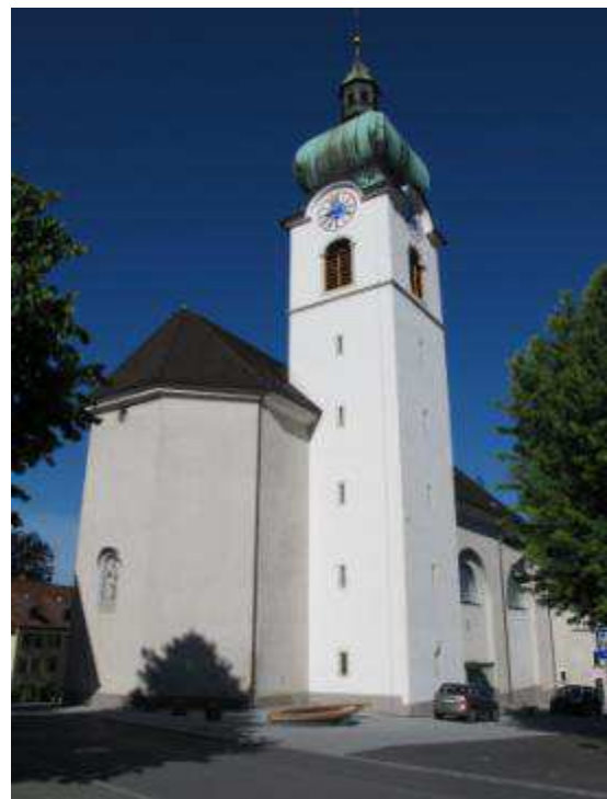
Abb. 524. Dornbirn-Oberdorf, Pfarrkirche, Außenansicht
