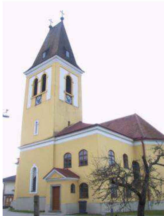
Abb. 310. Süßenbach, Pfarrkirche, Außenansicht
