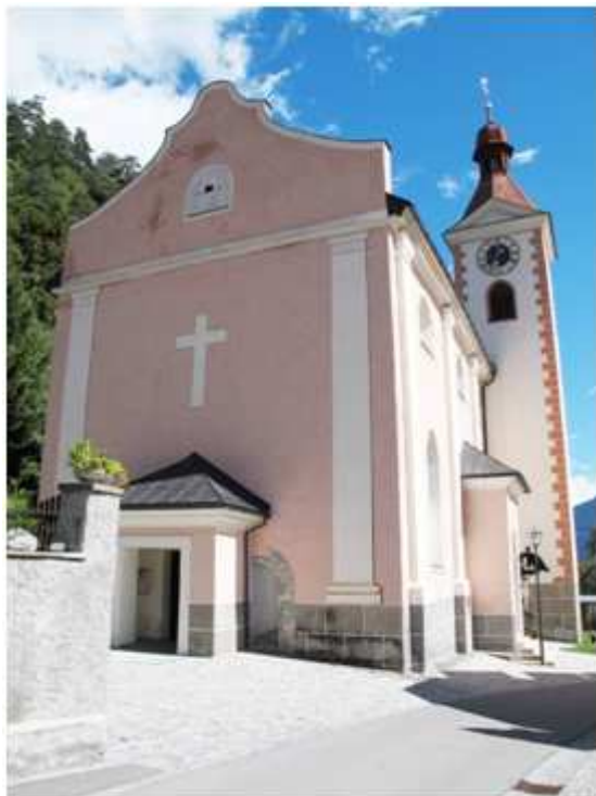
Abb. 29. Oberdrauburg, Pfarrkirche, Außenansicht
