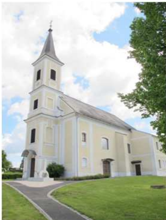
Abb. 15. Gerersdorf b. G., Pfarrkirche, Außenansicht
