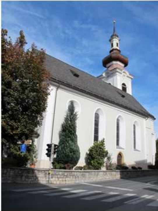
Abb. 145. Wattens, Alte Pfarrkirche, Außenansicht
