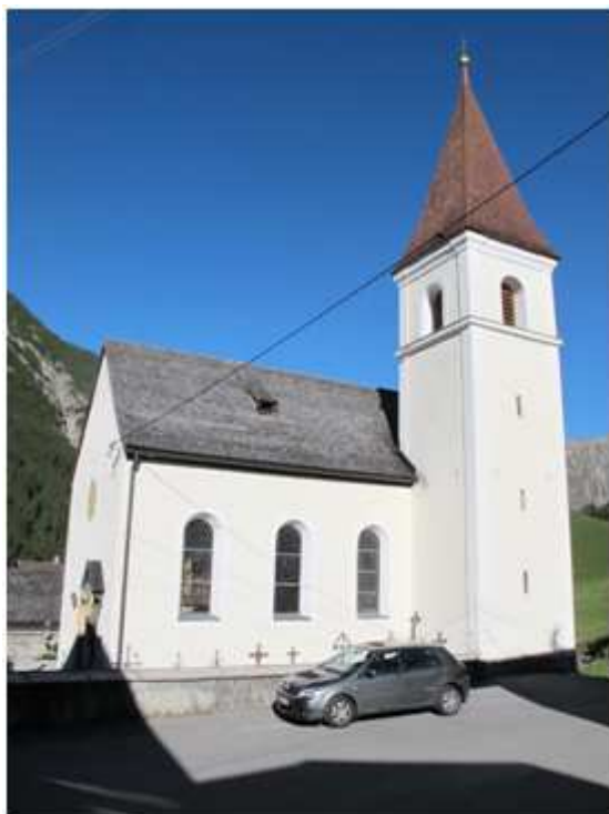
Abb. 469. Boden, Kaplaneikirche, Außenansicht
