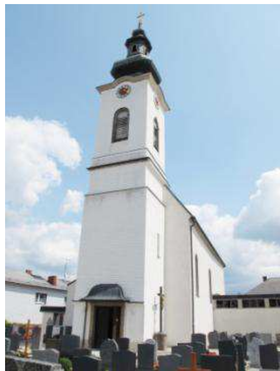
Abb. 384. St. Aegidi, Pfarrkirche, Kirchturm
