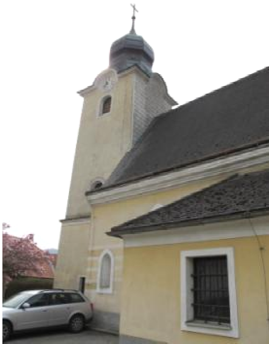
Abb. 293. Würnsdorf, Filialkirche, Außenansicht
