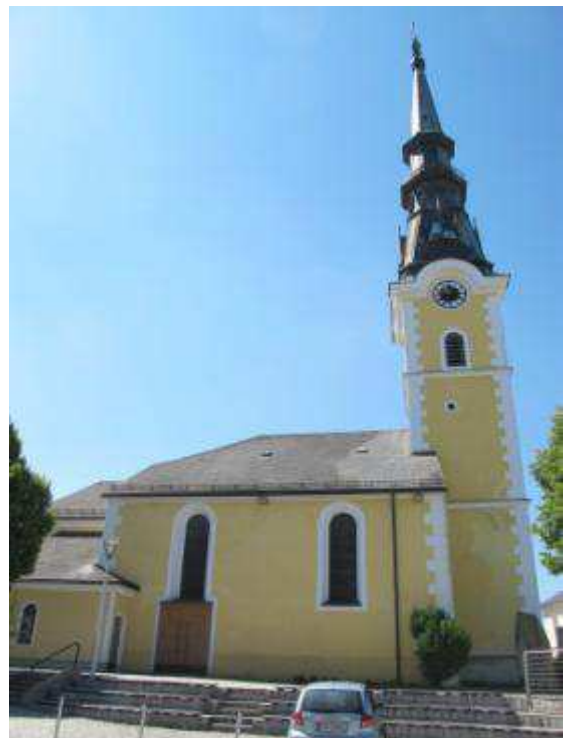
Abb. 356. Ulrichsberg, Pfarrkirche, Außenansicht
