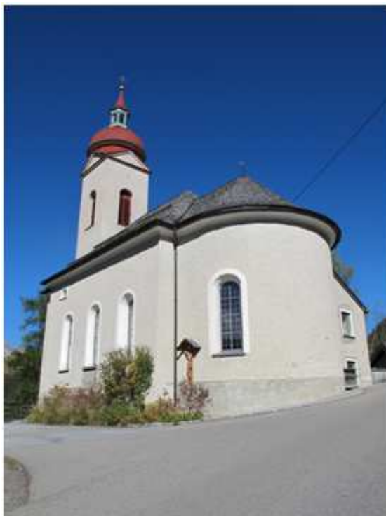
Abb. 475. Kaisers, Expositurkirche, Außenansicht
