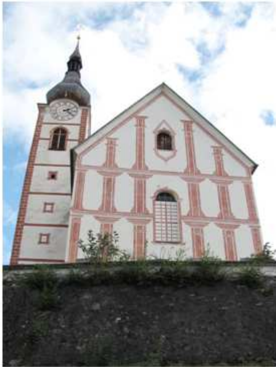
Abb. 21. St. Georgen im Katschtal, Filialkirche, Außenansicht
