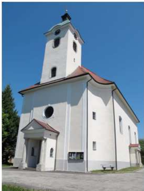
Abb. 79. Schiedlberg, Pfarrkirche, Außenansicht
