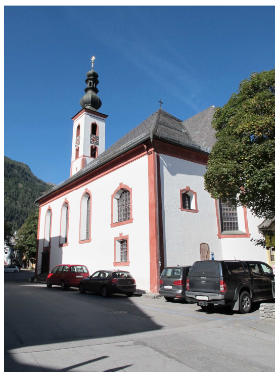
Abb. 92. Mauterndorf, Pfarrkirche, Außenansicht
