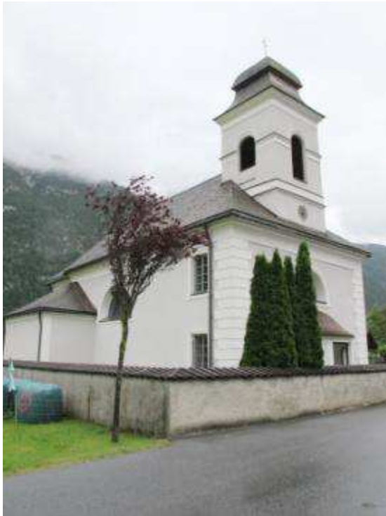
Abb. 453. Unterleutasch, Pfarrkirche, Außenansicht
