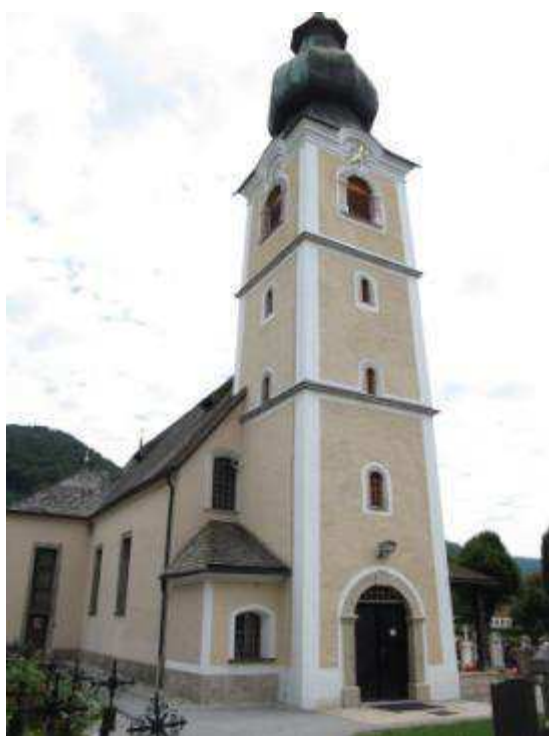
Abb. 91. Elsbethen, Pfarrkirche, Turm
