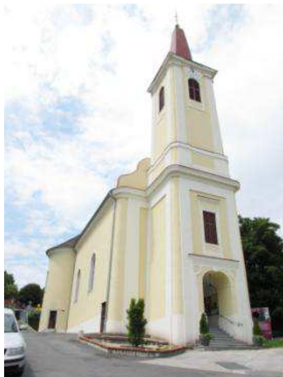
Abb. 212. Rotenturm an der Pinka, Pfarrkirche, Kirchturm
