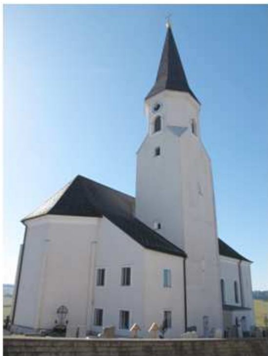
Abb. 89. Pöndorf, Pfarrkirche, Außenansicht
