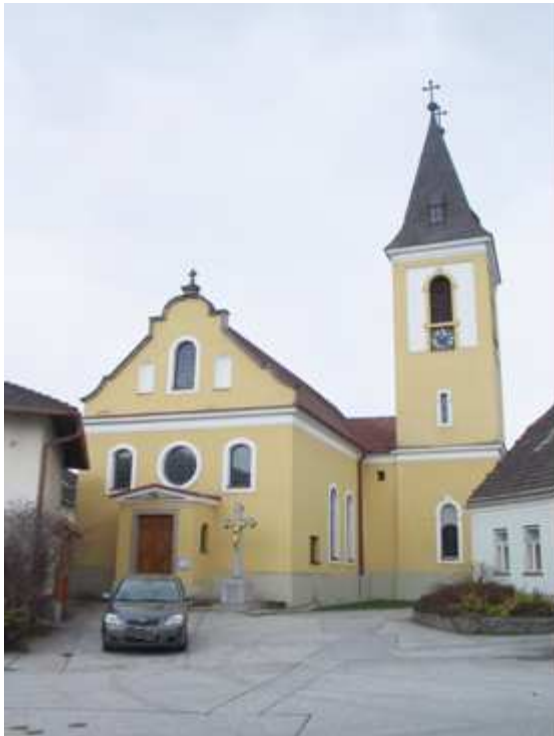
Abb. 309. Süßenbach, Pfarrkirche, Außenansicht
