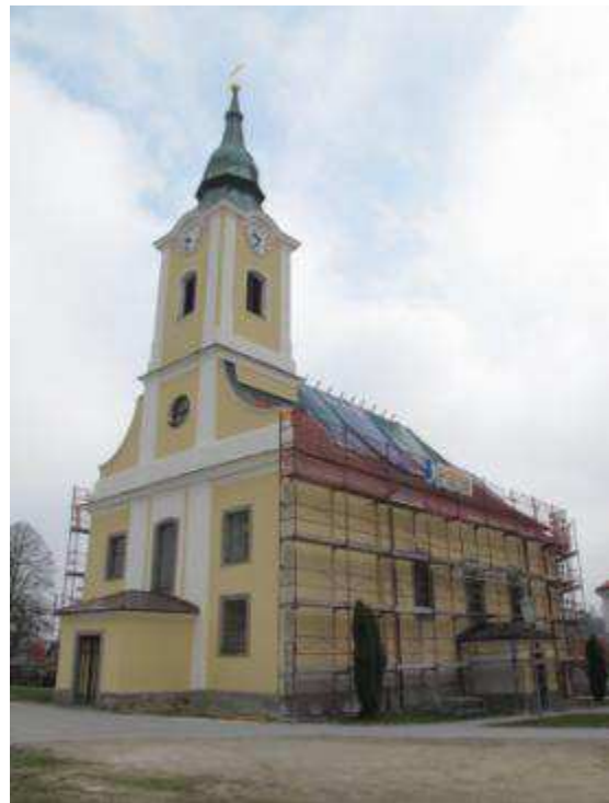
Abb. 50. Langeegg, Pfarrkirche, Außenansicht
