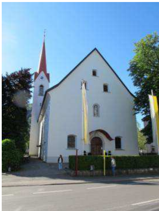
Abb. 151. Haselstauden, Pfarrkirche, Außenansicht
