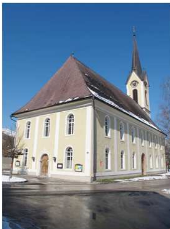
Abb. 90. Bad Goisern, Evang. Pfarrkirche, Außenansicht
