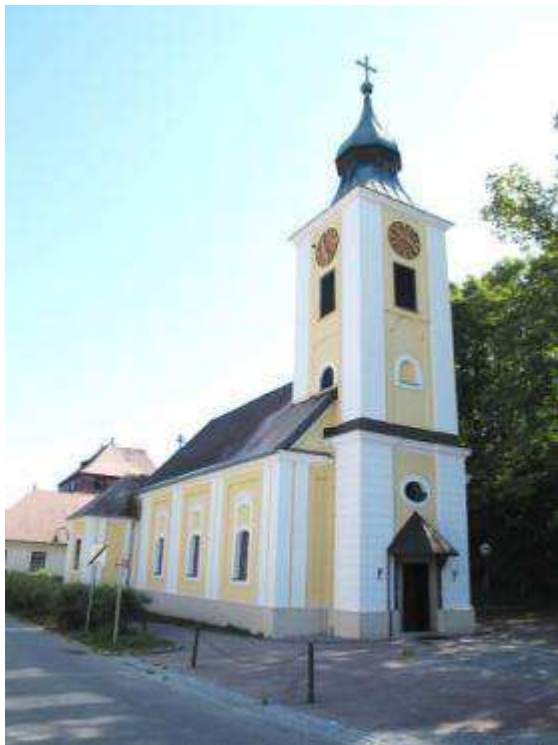
Abb. 63. Gutenbrunn, Pfarrkirche, Außenansicht
