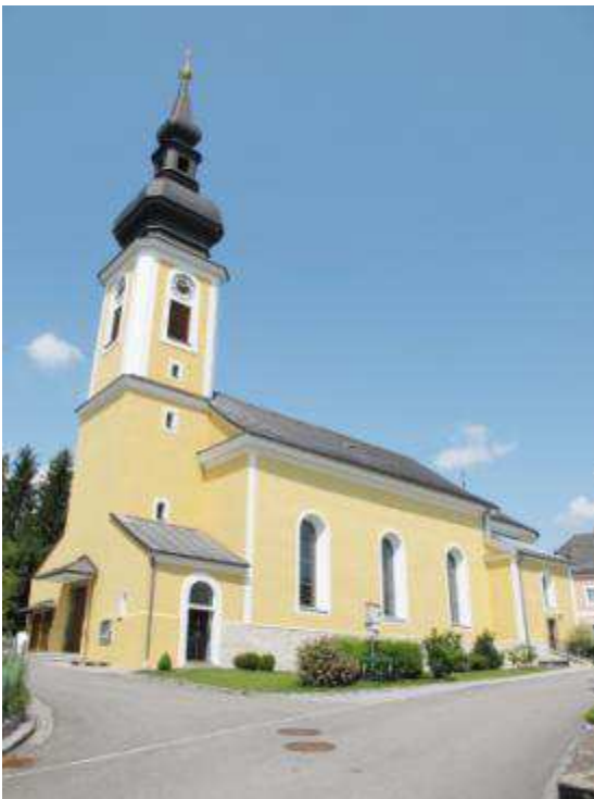
Abb. 347. Altschwendt, Pfarrkirche, Außenansicht
