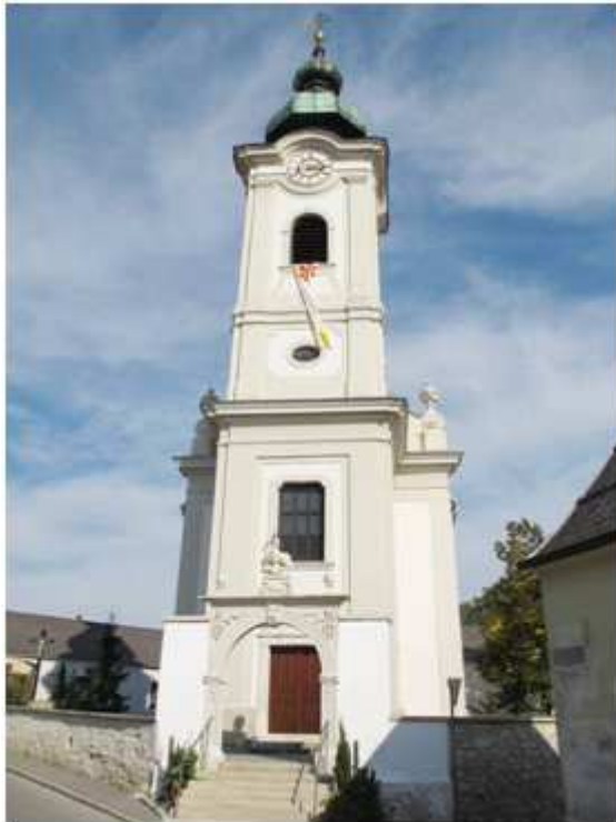
Abb. 1. St. Georgen a. Lgb., Pfarrkirche, Kirchturm
