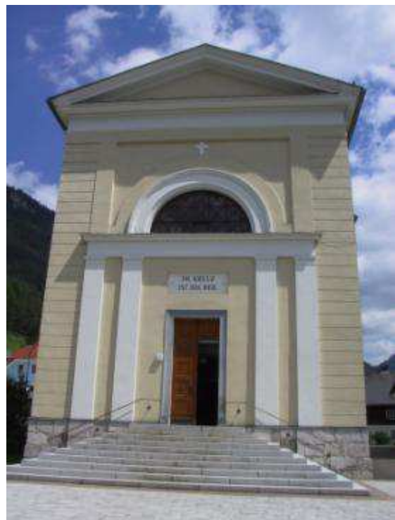
Abb. 436. Gußwerk, Pfarrkirche, Fassade
