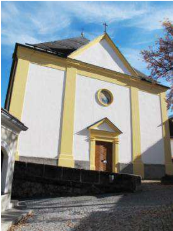
Abb. 517. Kufstein, Stadtpfarrkirche, Außenansicht
