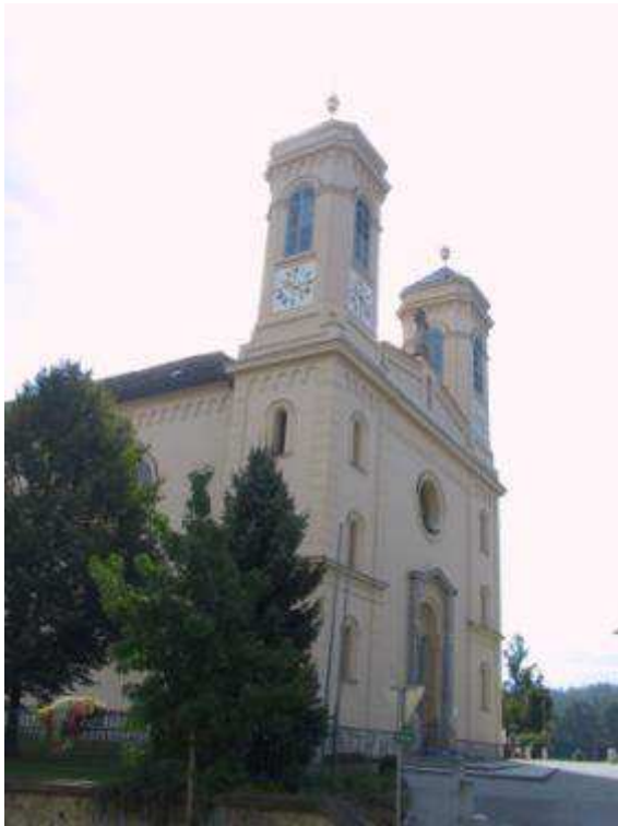
Abb. 661. Eggersdorf bei Graz, Pfarrkirche, Außenansicht
