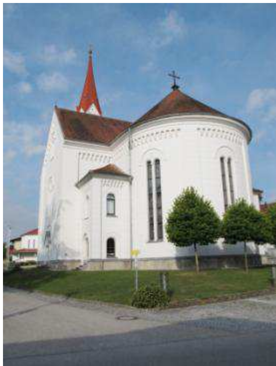
Abb. 631. Wallern a. d. Trattnach, Evang. Pfarrkirche, Außenansicht
