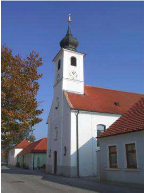
Abb. 41. Brunn im Felde, Pfarrkirche, Außenansicht
