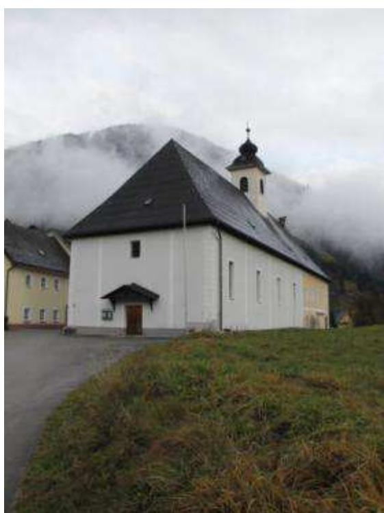
Abb. 123. Gams bei Hieflau, Pfarrkirche, Außenansicht
