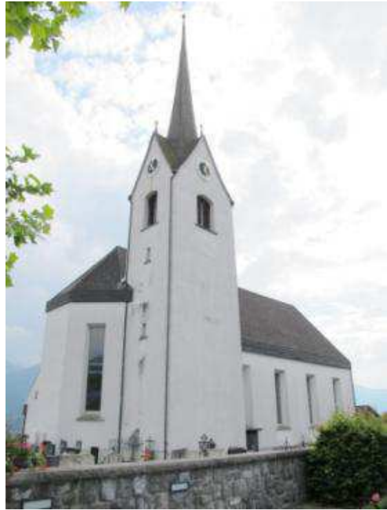
Abb. 586. Abb. 0. Schnifis, Pfarrkirche, Außenansicht
