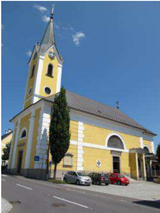
Abb. 345. Alberndorf i. d. R., Pfarrkirche, Außenansicht
