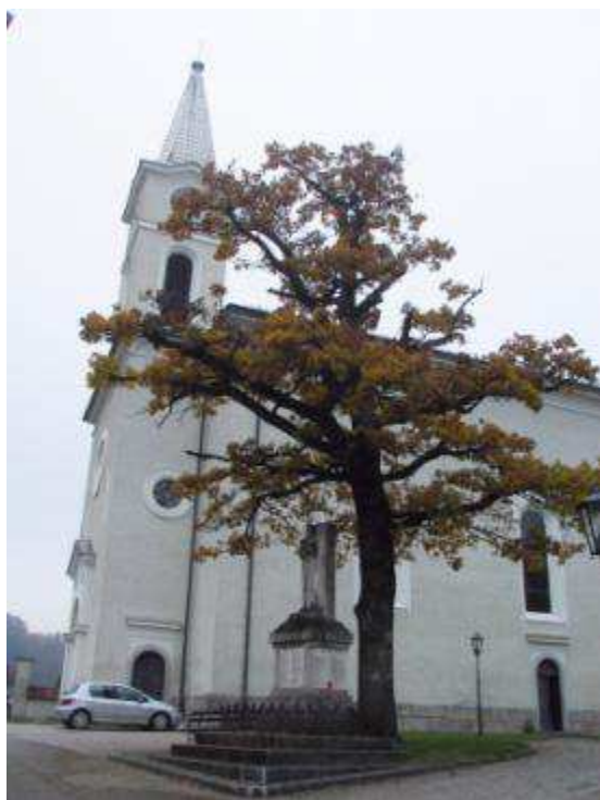
Abb. 615. Opponitz, Pfarrkirche, Außenansicht
