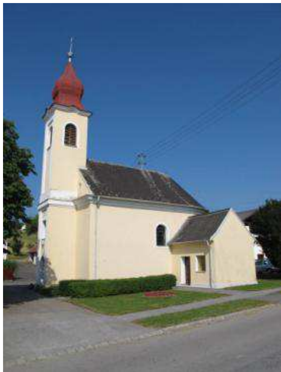
Abb. 167. Deutsch Ehrendorf, Filialkirche, Außenansicht
