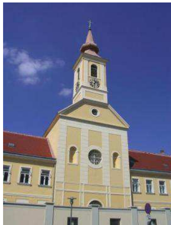
Abb. 292. Stein an der Donau, Ehem. Redemptoristinnenkirche, Außenansicht
