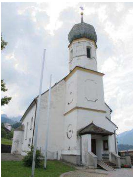
Abb. 135. Grän, Pfarrkirche, Außenansicht
