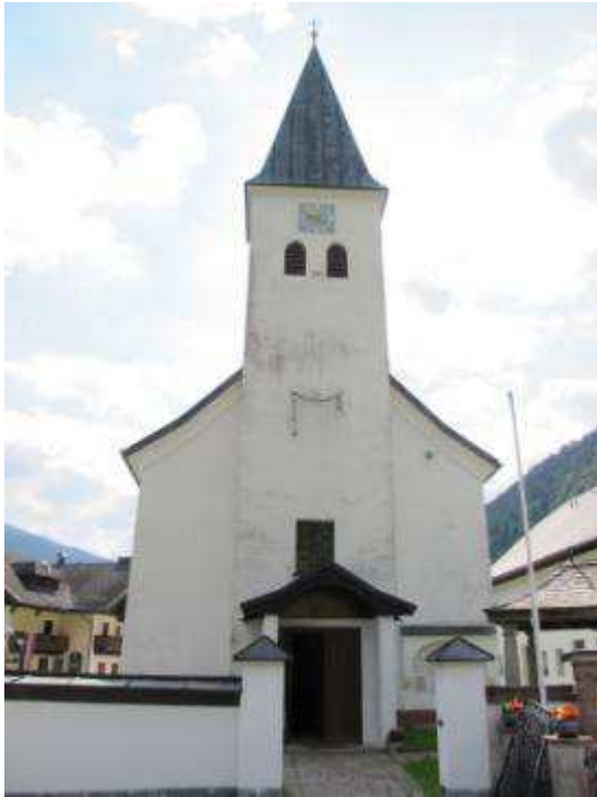
Abb. 97. Hintersee, Pfarrkirche, Außenansicht
