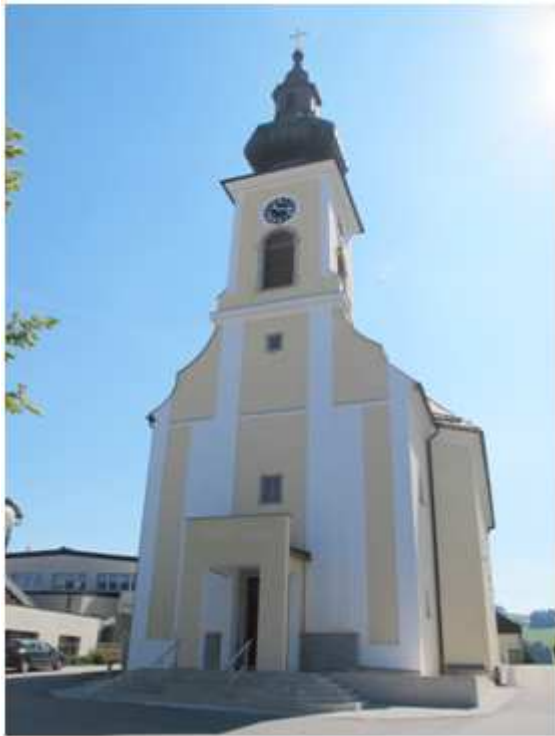
Abb. 77. Kollerschlag, Pfarrkirche, Außenansicht
