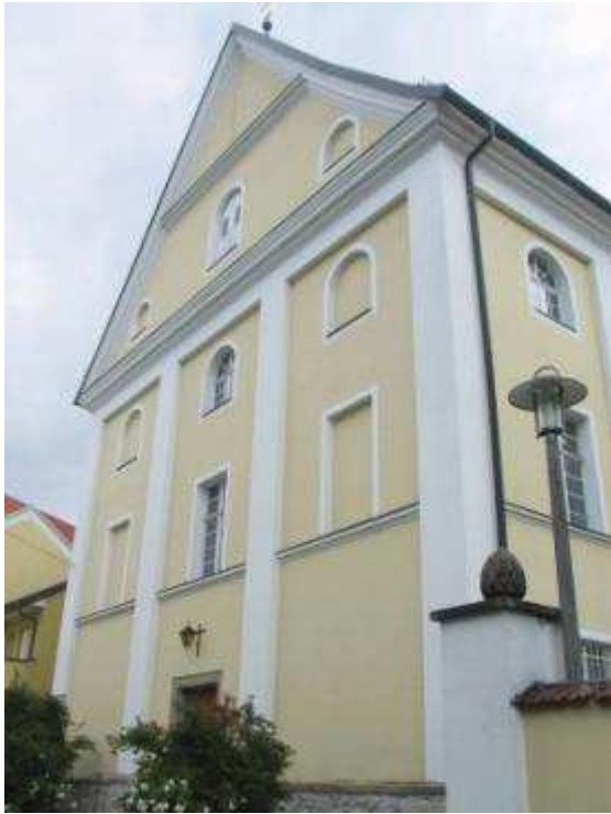
Abb. 321. Eferding, Evang. Pfarrkirche, Außenansicht
