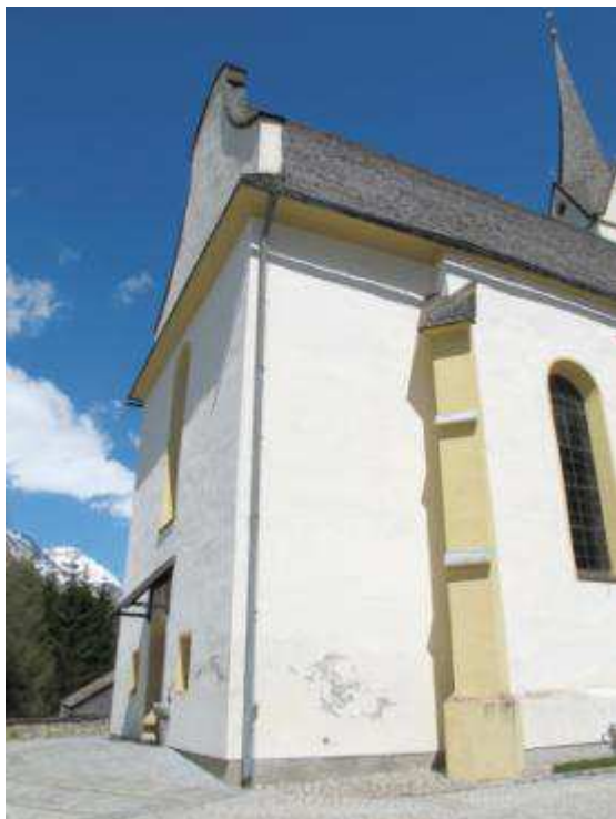
Abb. 495. Kals am Großglockner, Pfarrkirche, Außenansicht des Erweiterungs- joches
