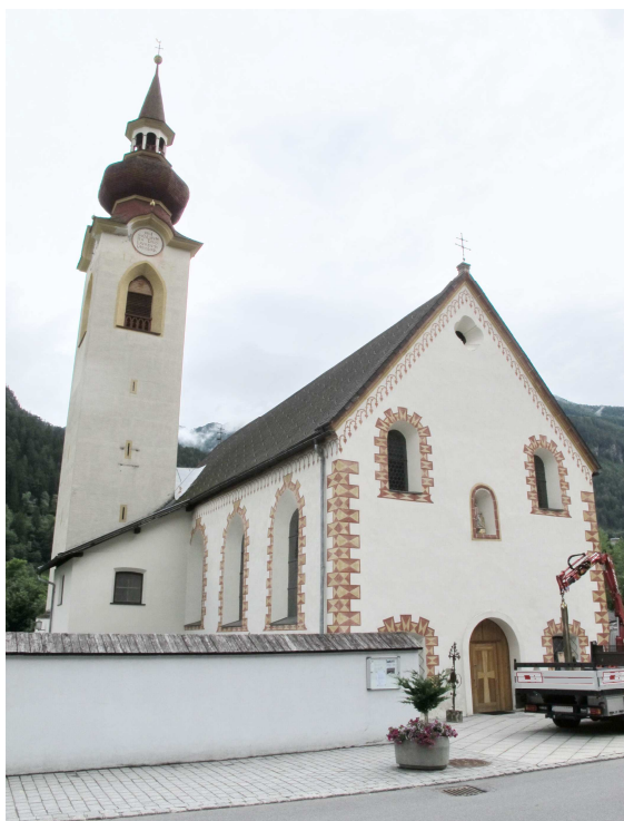
Abb. 669. Tösens, Pfarrkirche, Außenansicht
