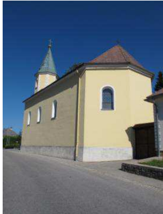
Abb. 618. Bärnkopf, Pfarrkirche, Außenansicht
