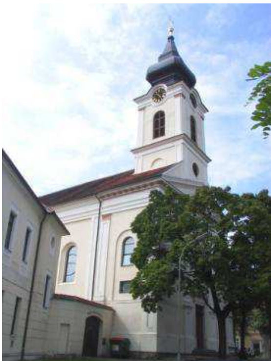
Abb. 595. Großpetersdorf, Pfarrkirche, Außenansicht
