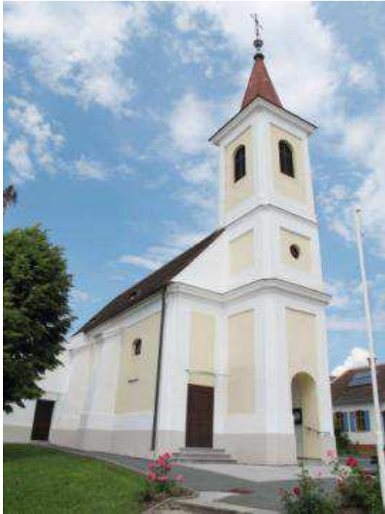
Abb. 181. Spitzzicken, Filialkirche, Außenansicht
