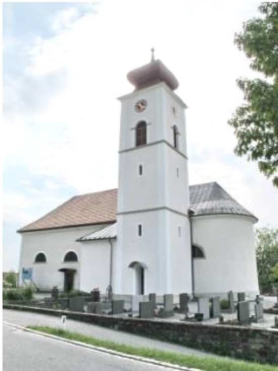
Abb. 545. Eichenberg, Pfarrkirche, Außenansicht
