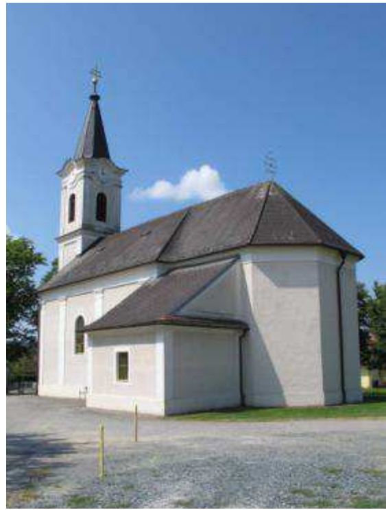
Abb. 602. Rauchwart, Pfarrkirche, Außenansicht
