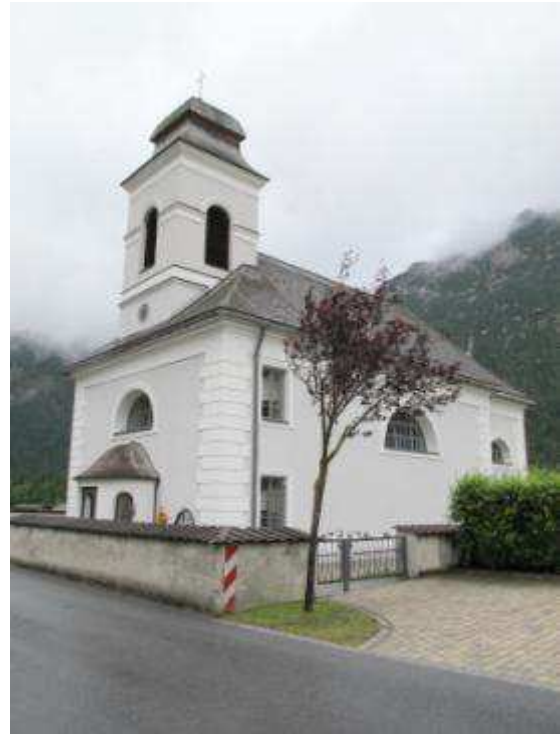
Abb. 454. Unterleutasch, Pfarrkirche, Außenansicht
