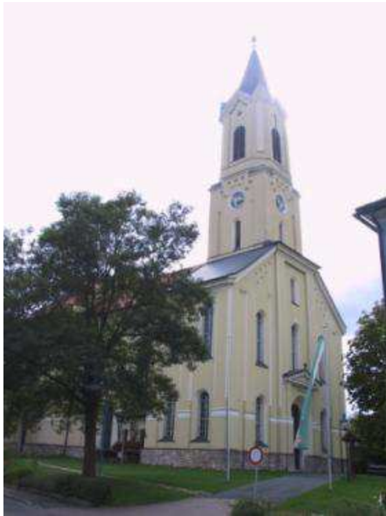
Abb. 653. St. Josef in Weststeiermark, Pfarrkirche, Außenansicht
