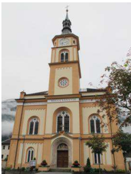
Abb. 483. Silz, Pfarrkirche, Außenansicht
