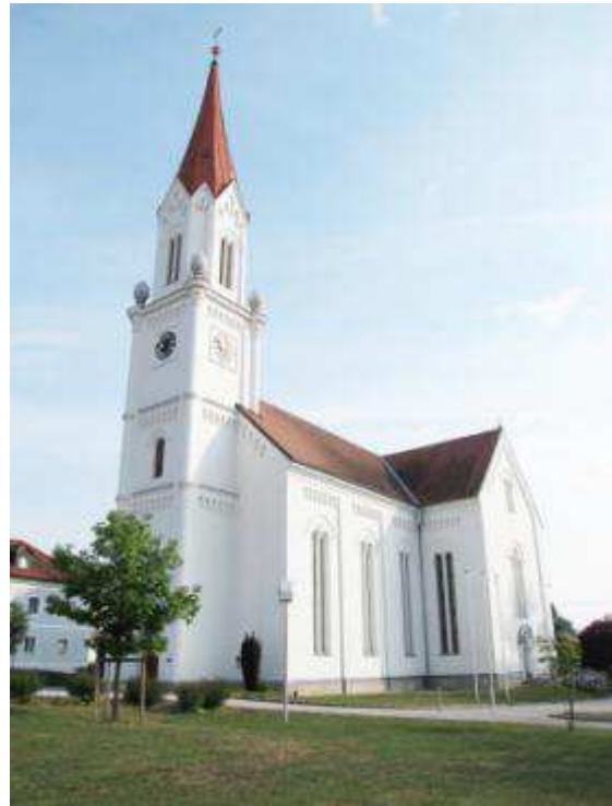
Abb. 630. Wallern a. d. Trattnach, Evang. Pfarrkirche, Außenansicht
