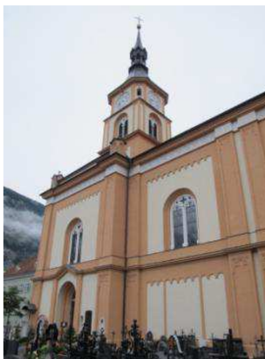
Abb. 484. Silz, Pfarrkirche, Außenansicht
