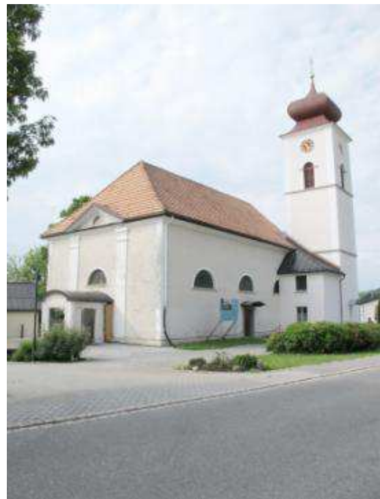
Abb. 544. Eichenberg, Pfarrkirche, Außenansicht
