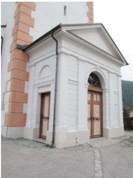
Abb. 295. Tünitz, Pfarrkirche, Vorbau am Hauptportal
