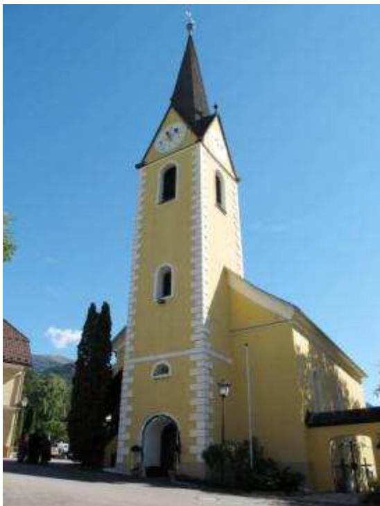
Abb. 227. Unterhaus, Evang. Kirche, Außenansicht
