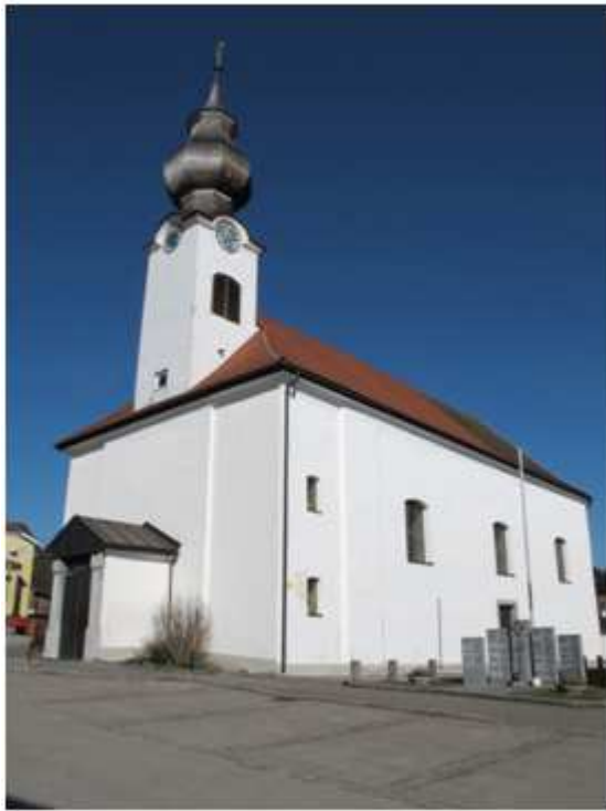
Abb. 81. Fornach, Pfarrkirche, Außenansicht
