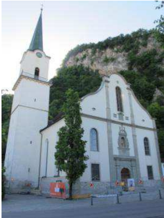
Abb. 153. Hohenems, Pfarrkirche, Außenansicht
