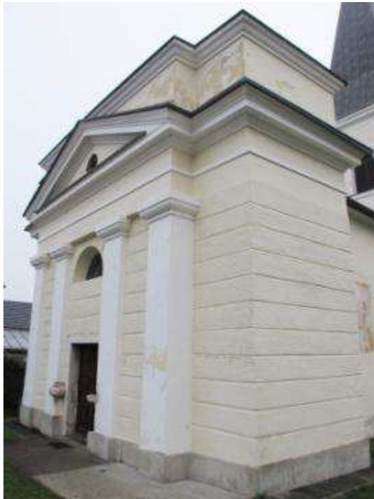
Abb. 609. Glanhofen, Pfarrkirche, Fassade
