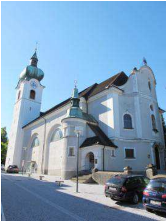
Abb. 525. Dornbirn-Oberdorf, Pfarrkirche, Außenansicht
