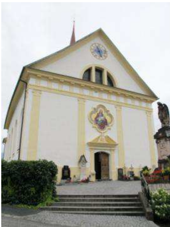
Abb. 507. Flurling, Pfarrkirche, Außenansicht
