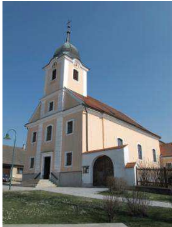
Abb. 54. Eggern, Pfarrkirche, Außenansicht
