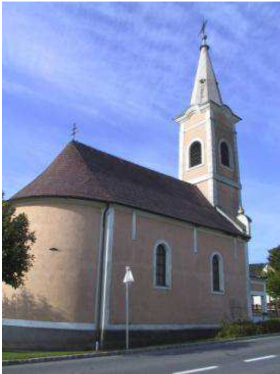
Abb. 169. Neudorf bei Landsee, Filialkirche, Außenansicht
