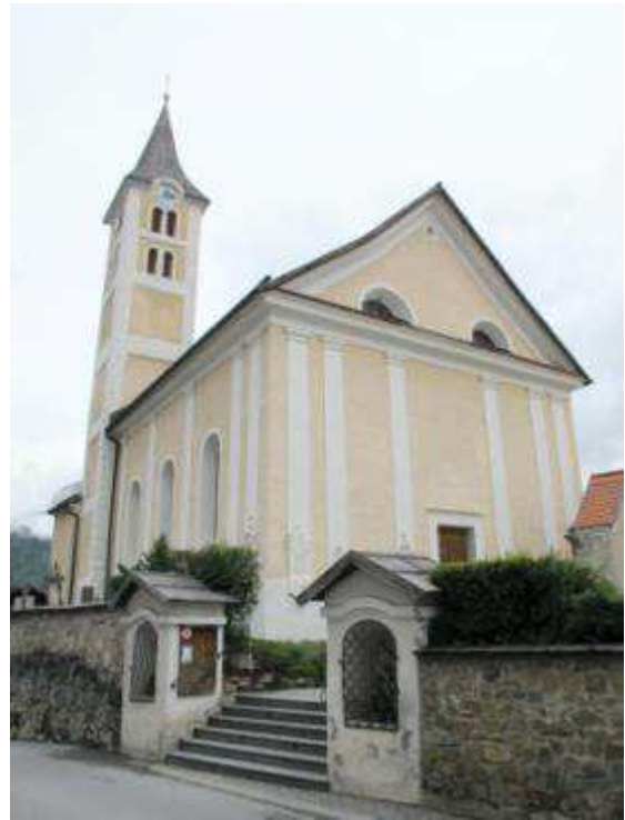
Abb. 462. Ladis, Pfarrkirche, Außenansicht
