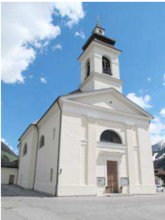
Abb. 455. St. Jakob in Defereggien, Pfarrkirche, Außenansicht
