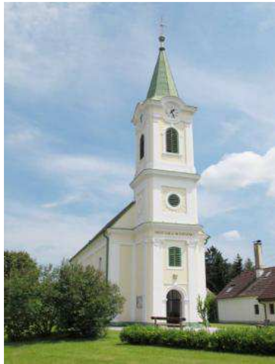
Abb. 214. Siget in der Wart, Evang. Pfarrkirche, Außenansicht
