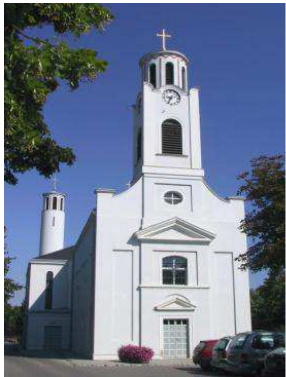
Abb. 216. Andau, Pfarrkirche, Außenansicht
