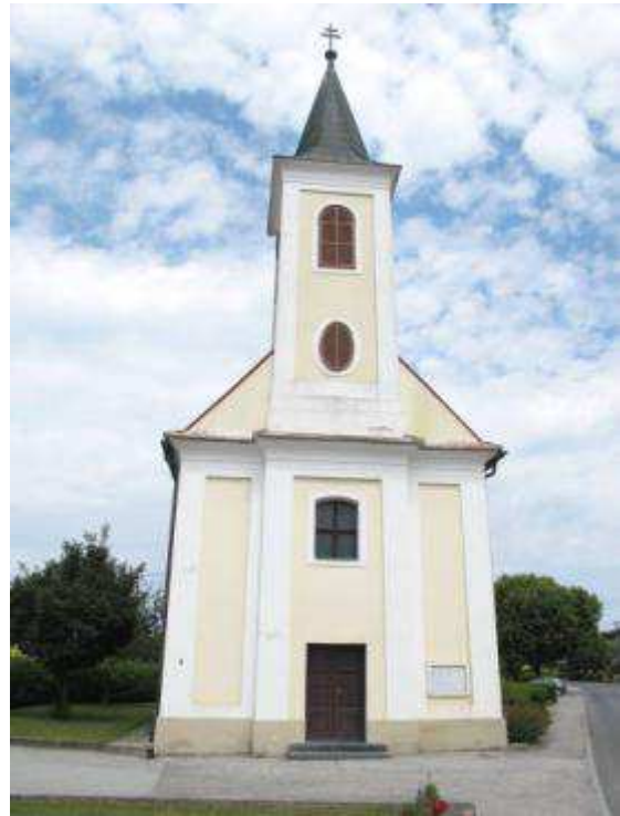
Abb. 190. Rohrbach a. d. T., Filialkirche, Außenansicht
