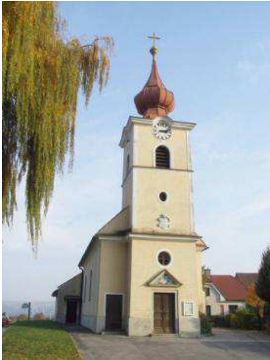
Abb. 273. Reichersdorf, Filialkirche, Außenansicht
