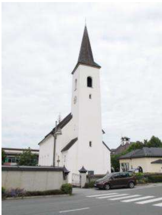
Abb. 399. Fuschl am See, Pfarrkirche, Außenansicht
