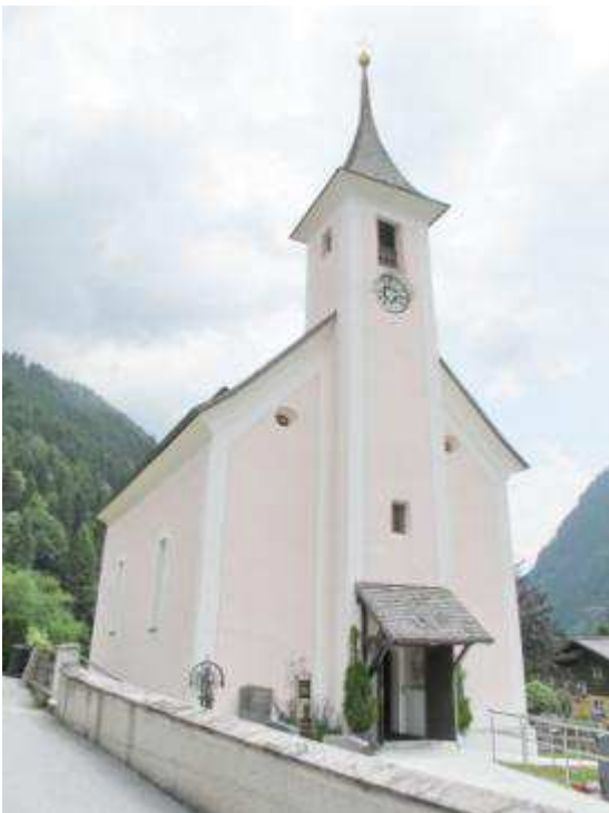
Abb. 99. Viehhofen, Pfarrkirche, Außenansicht
