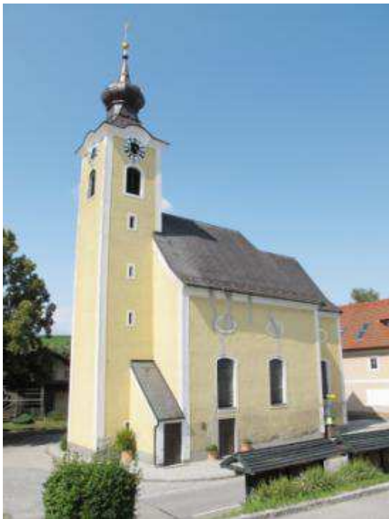
Abb. 359. Kematen am Innbach, Pfarrkirche, Außenansicht
