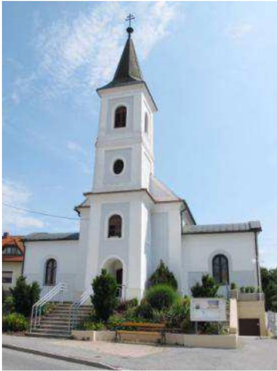
Abb. 193. Kleinpetersdorf, Filialkirche, Außenansicht
