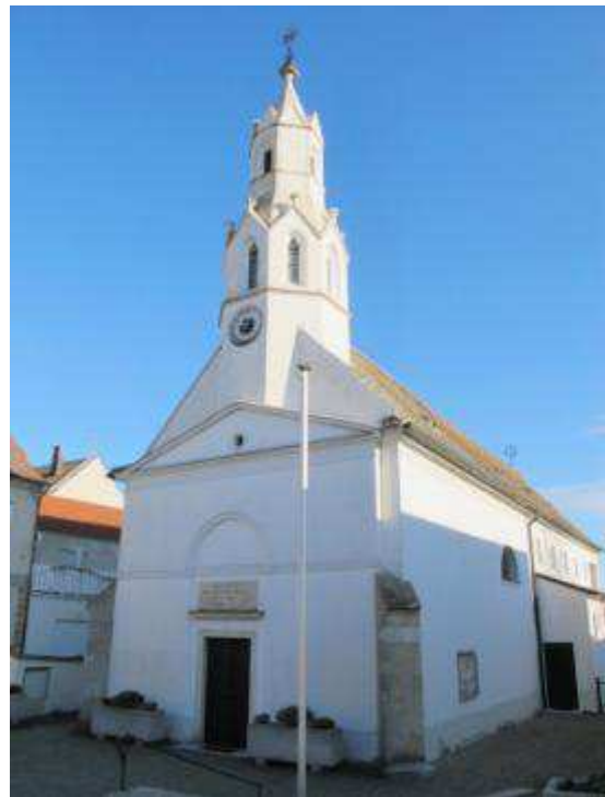
Abb. 218. Mörbisch, Pfarrkirche, Außenansicht
