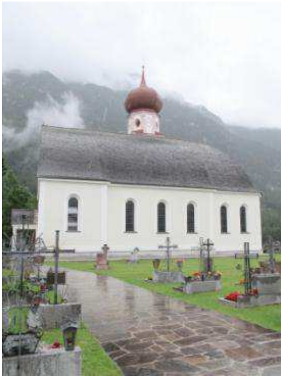
Abb. 445. Oberleutasch, Pfarrkirche, Außenansicht
