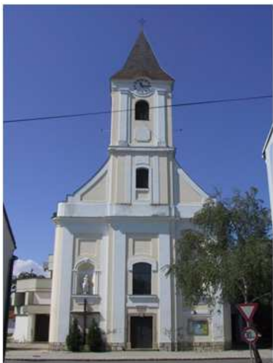
Abb. 11. Apetlon, Pfarrkirche, Außenansicht
