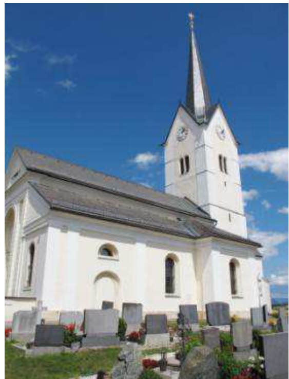
Abb. 604. St. Kanzian a. K., Pfarrkirche, Außenansicht
