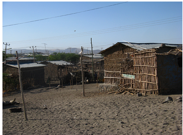
Abb. 24 chikka -Häuser aus Ästen, mit Lehmverputz und Wellblechdach in Logia
