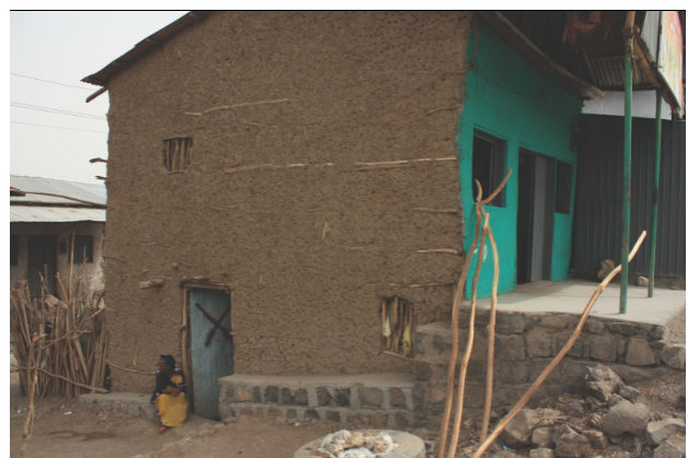
Abb. 54 chikka -Haus mit Kerben im Lehmverputz für den späteren Zementverputz; die Front ist bereits verputzt und bemalt; Markierung mit X an der Tür.
