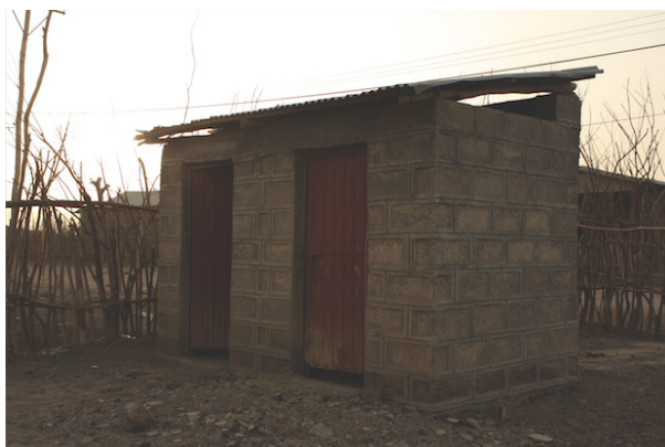
Abb. 65 Aus Betonziegeln gebautes WC und Waschplatz im Hof eines Grundstücks in Logia
