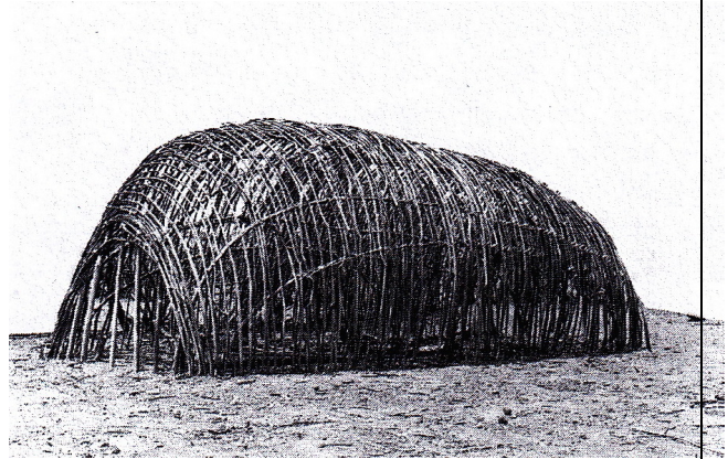
Abb. 16 Gerüst eines Afar-Langhauses
