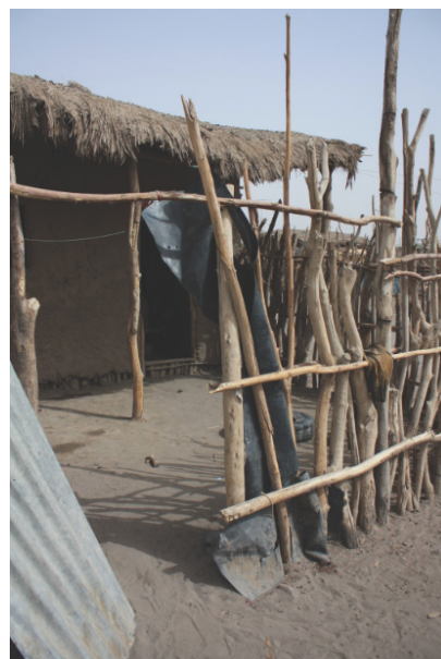
Abb. 52 Grundstückseinzäunung in Logia
