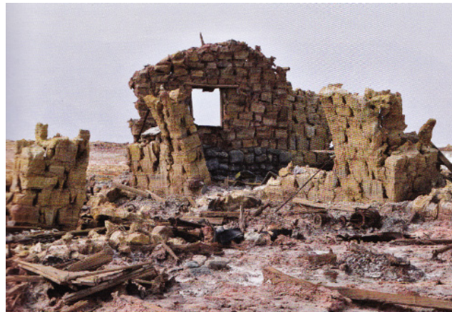
Abb. 20 Eingestürztes Haus aus Salzziegeln in der Danakil-Senke
