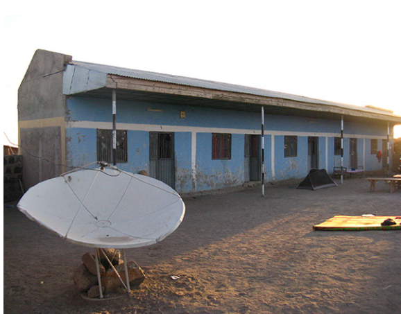
Abb. 25 Betonbau in Logia
