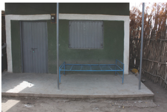
Abb. 55 Tür und Fenster aus Wellblech; das Bett steht in heißen Nächten im Freien
