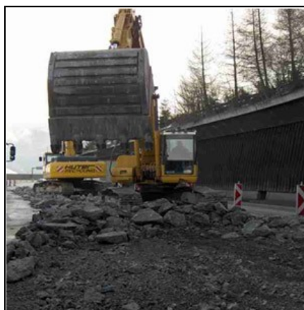
Abb. 4: Aufbrechen von Asphalt
