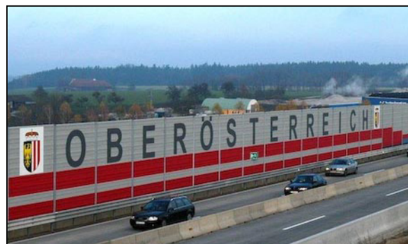
Abb. 7: Neu gestaltete Lärmschutzwand
