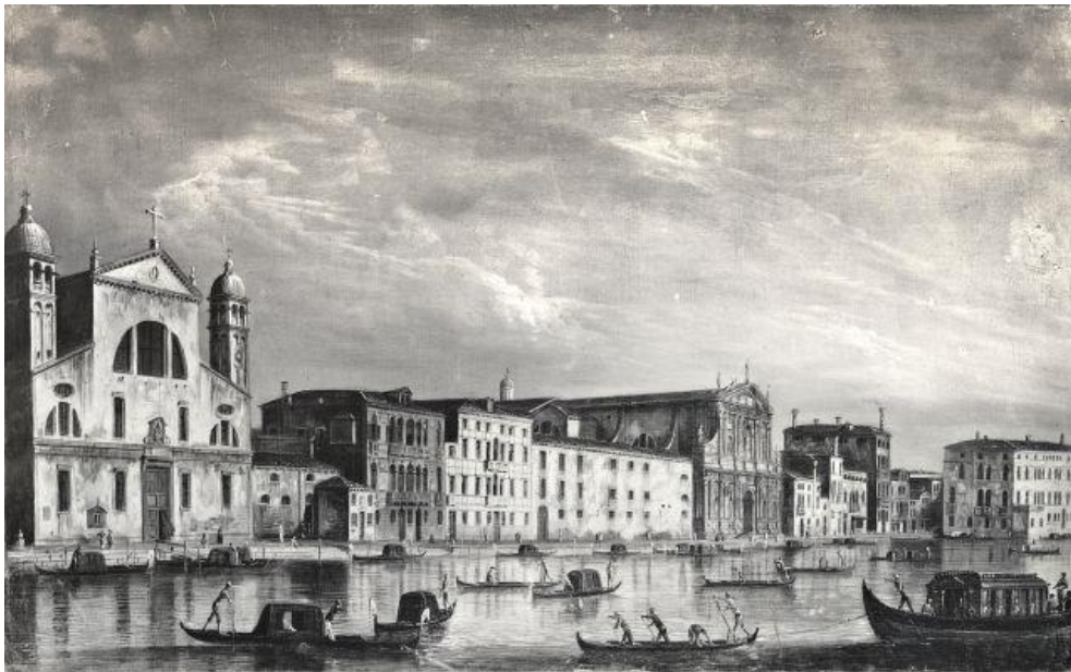
Abbildung 22: Die zerstörte Kirche Santa Lucia (linker Bildrand) gemeinsam mit der heute noch existenten Scalzi-Kirche nahe dem heutigen Bahnhofsgebäude.
