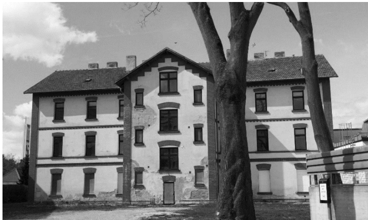
Abbildung 57: Das Beamtenwohnhaus in der ehemaligen Kolonie Von den Gebäuden des Fabrikgeländes existiert heute nur noch das Rohjutemagazin entlang der Eisenbahn.
