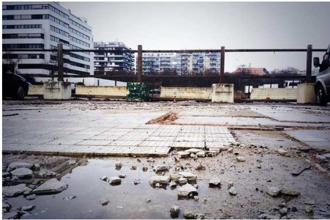
Abbildung 14: Parkplatz in Wien Landstraße (Foto: Simon Rosner) 510
