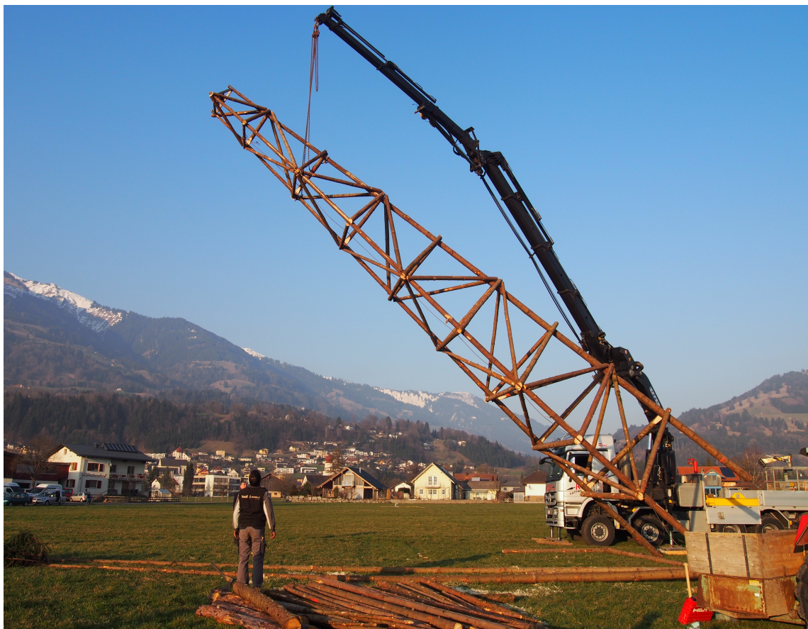
Abb. 2: Der Kran hebt das am Boden zusammengebaute Gerüst
