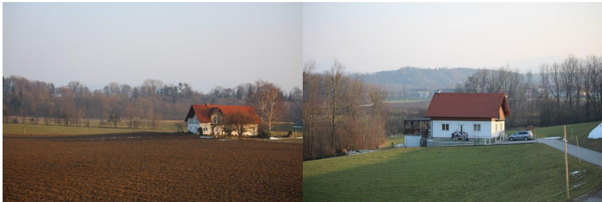
Abb.13: Bauten im Grünland in der Eisenstraße (Quelle: eigene Aufnahme)
