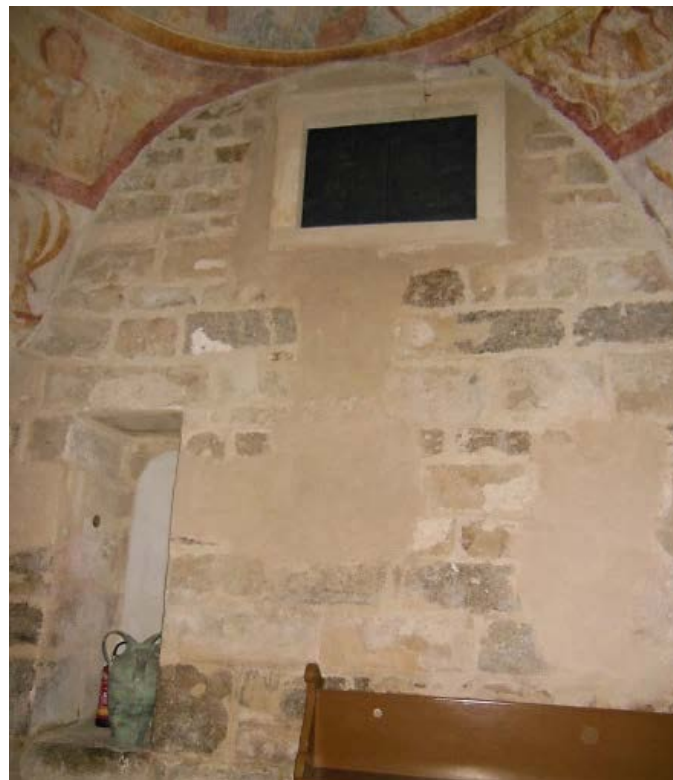
Abb. 8: Nordwand der Burgkapelle mit nachträglicher Maueröffnung, Burg Ottenstein, vor 1177, Österreich, Rastendorf (NÖ).
