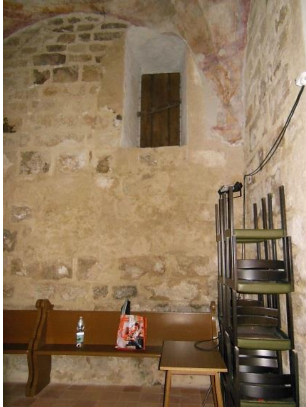
Abb. 9: Südwand der Burgkapelle mit nachträglicher Maueröffnung, Burg Ottenstein, vor 1177, Österreich, Rastendorf (NÖ).
