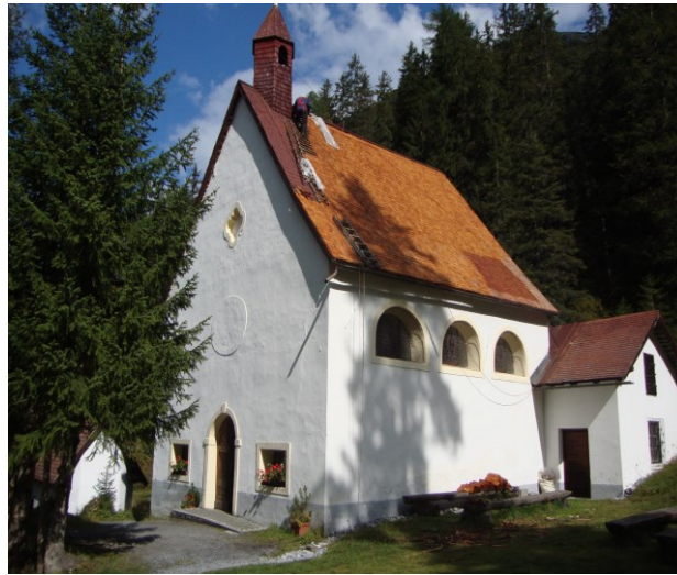
Abbildung 32: Wallfahrtskirche. Sakristei rechts hinten. Pfarrer Vigil Klammsteiner auf dem Dach, bei der Restaurierung der Schindeln. © Melanie Angerer 07.2009
