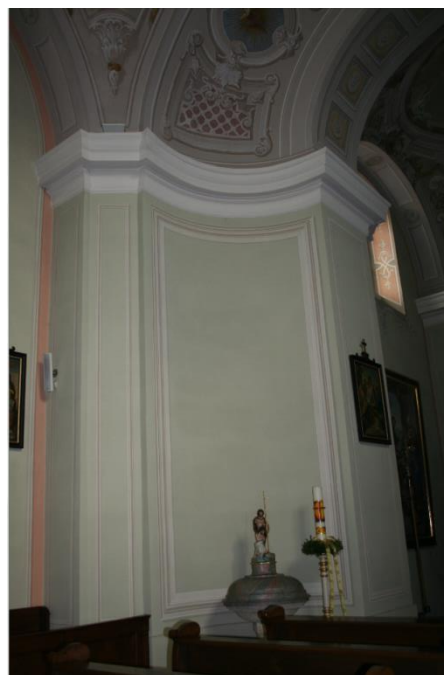
Mittelbaldachin mit abgeschrägten Pfeilern
