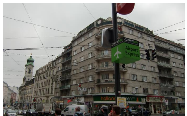
Demolierung um 1930 und heute
