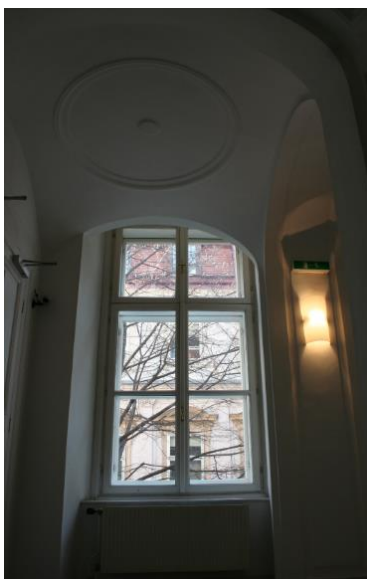
Fenster im Stiegenhaus
