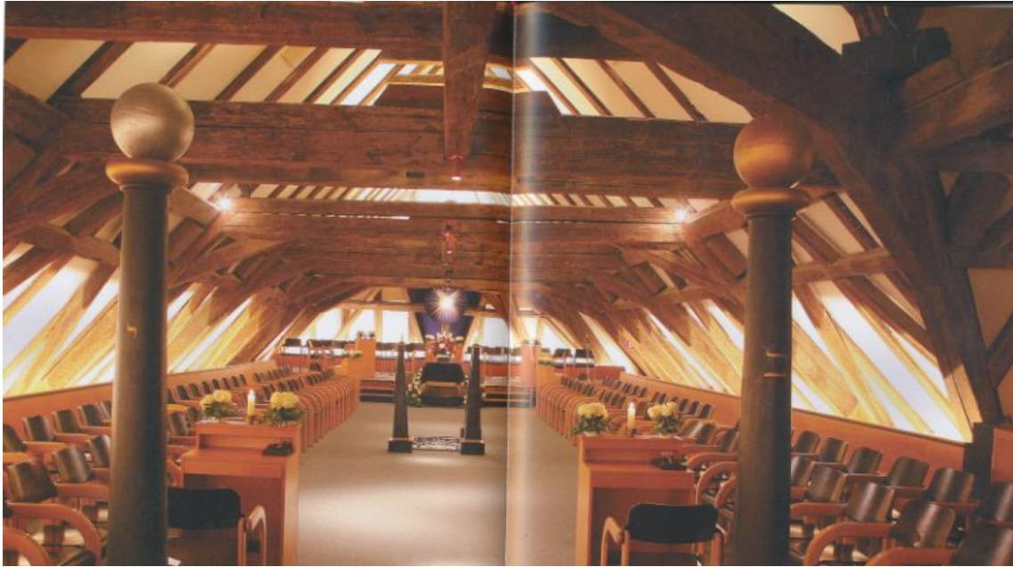
Hölzene Dachkonstruktion Dachgeschoss
