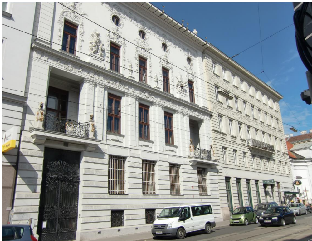
Rennweg 3 – 5, Verbauung heute
