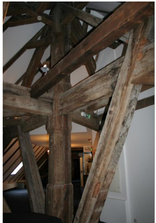
Hölzene Dachkonstruktion Dritter Stock
