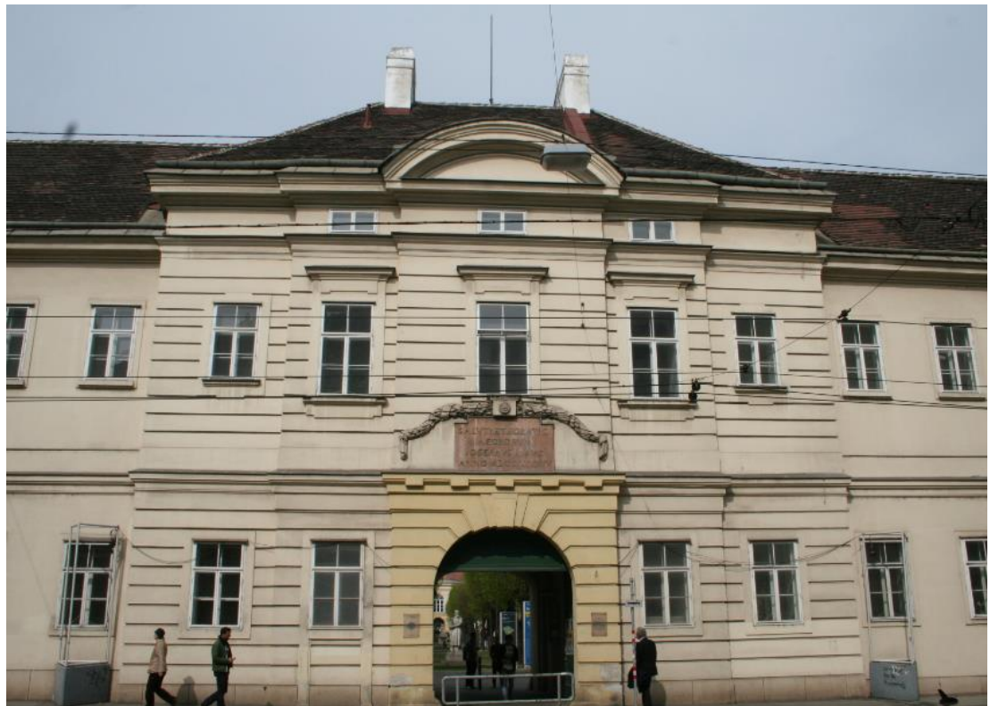
Alserstrasse Portal mit Mittelrisalit
