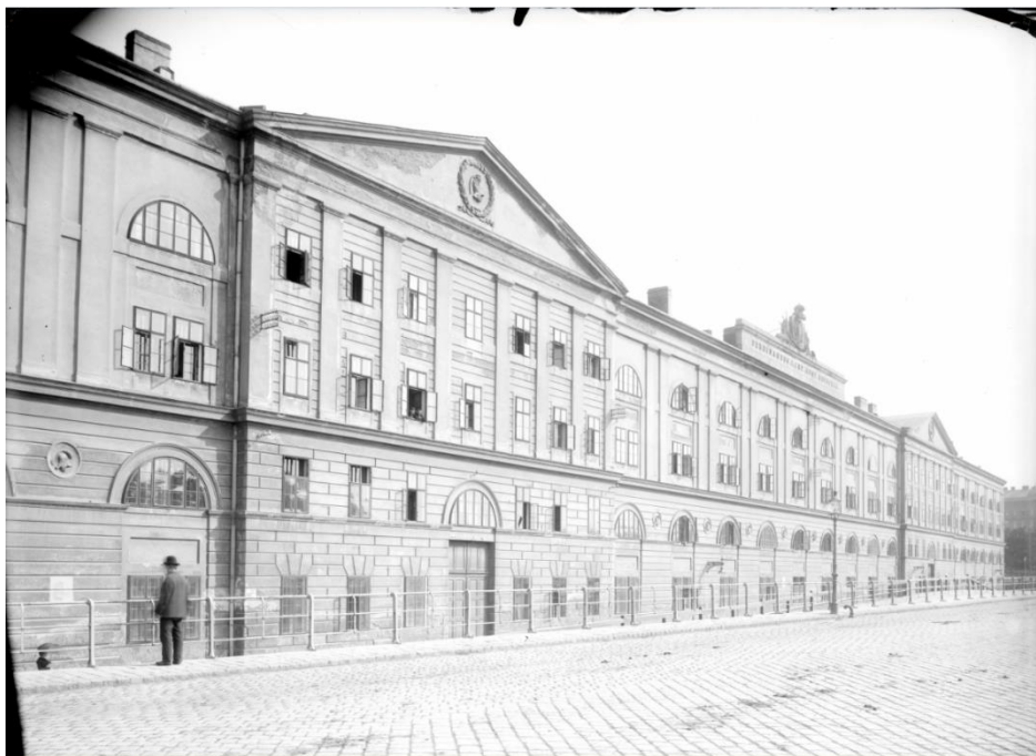
Heumarktkaserne 1901 vor dem Abbruch
