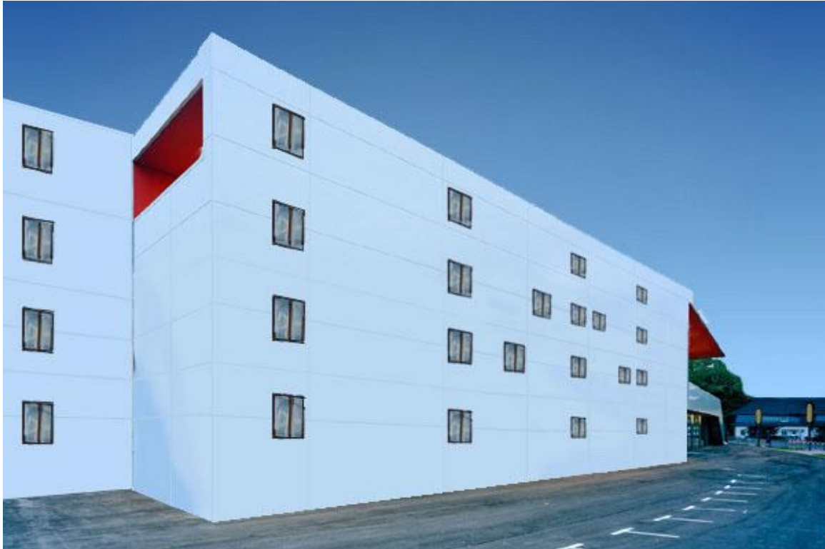
Abbildung A-7: Fassade B, Bedingung: wenig Fenster & geschlossen
