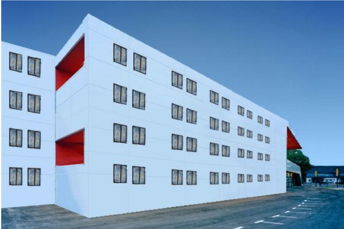
Abbildung A-5: Fassade B, Bedingung: viele Fenster & geschlossen
