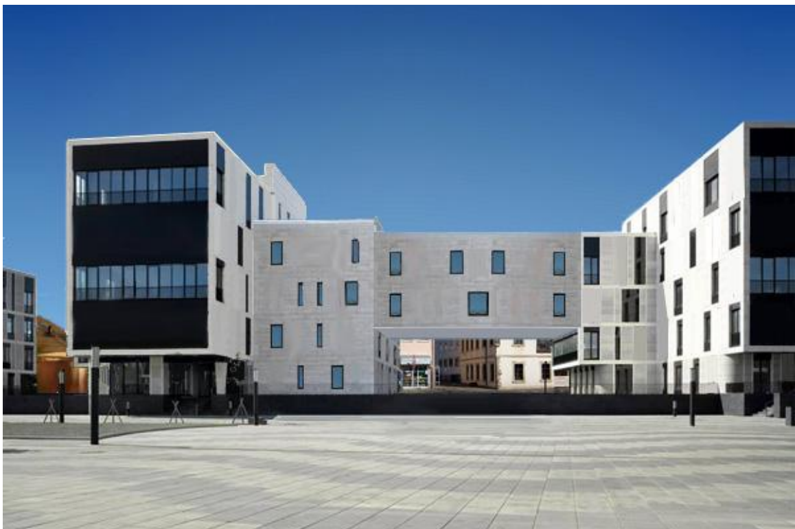
Abbildung A-12: Fassade A, Bedingung: wenig Fenster & offen
