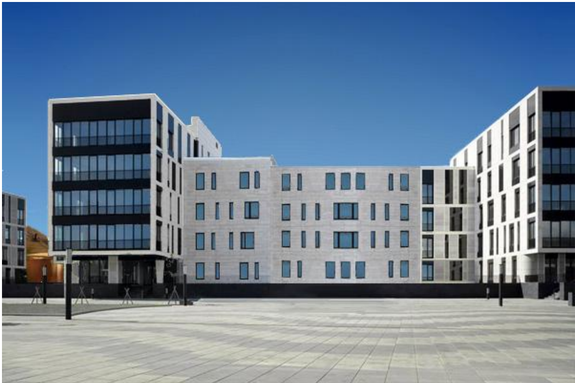
Abbildung A-9: Fassade C, Bedingung: viele Fenster & geschlossen
