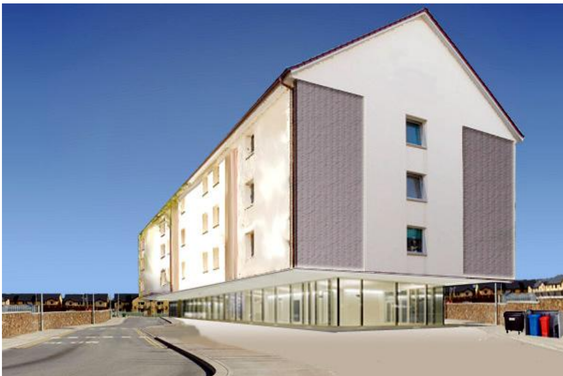
Abbildung A-4: Fassade A, Bedingung: wenig Fenster & offen
