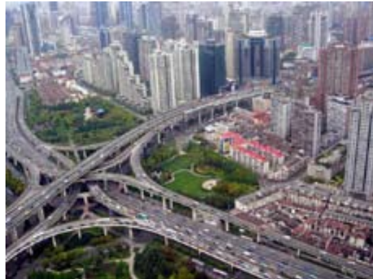
Abb. 9: Luftaufnahme einer Planfreien Kreuzung
