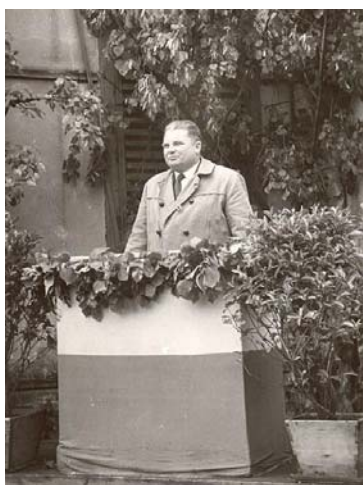
Abb. 96: Ansprache des Bürgermeisters anlässlich der Spatenstichfeier–Hauptschule, 1955 1038
