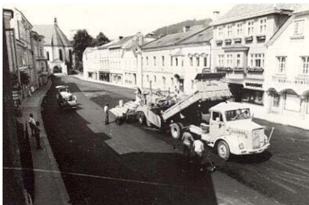
Abb. 83: Belagsarbeiten Oberer Stadtplatz 833
