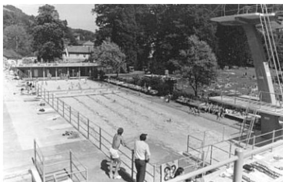
Abb. 61: Parkbad nach der Sanierung 1960 641
