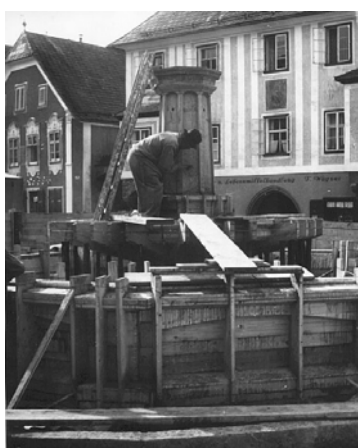
Abb. 20: Bau des Forellenbrunnens 186
