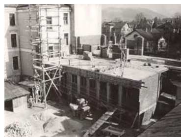
Abb. 98: Rohbauarbeiten bei der Hauptschule 1040
