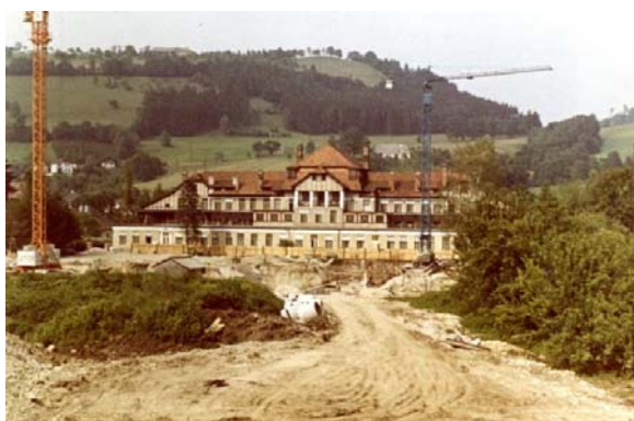
Abb. 58: Das im Jahre 1917 erbaute „Offizierserholungsheim“, welches später unter dem Namen „Buchenbergheim“ von der Bundeskrankenkasse weitergeführt wurde, vor dem Umbau 619
