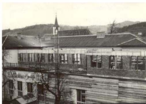
Abb. 103: Aufstockung der HAK/HAS 1967 1080
