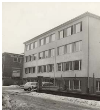
Abb. 63: Ansicht Volksschule mit Stadtsaal 1969 650
