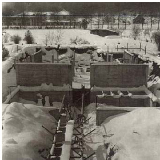
Abb. 85: Krankenhauszubau 1965, im Hintergrund HTL 900
