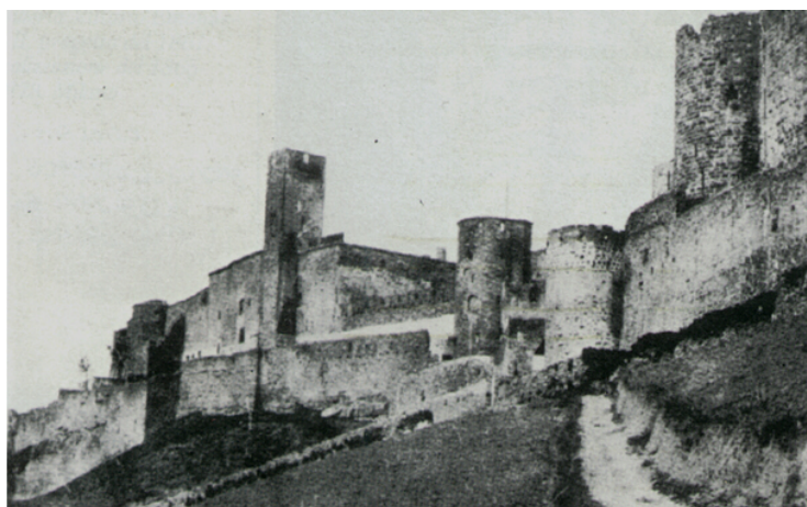
Die Ruinen der Festung von Carcassonne vor der Restaurierung (Quelle: CARCAS1_041208)
