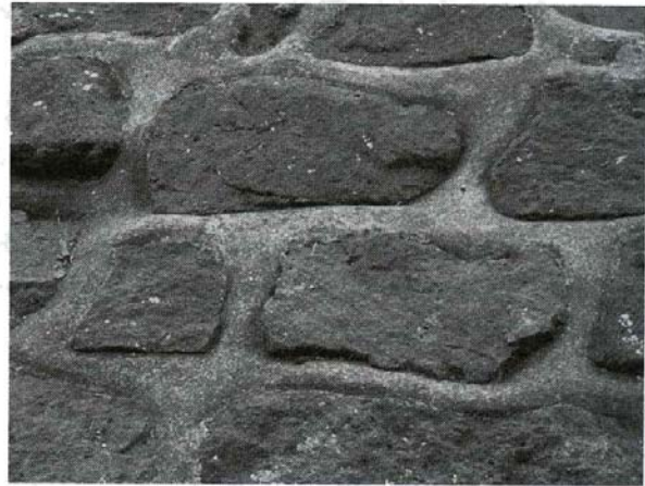
Bruchsteinmauerwerk (Quelle: DEHN:456)
