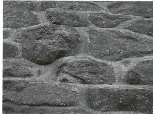
Zyklopenmauerwerk (Quelle: DEHN:456)
