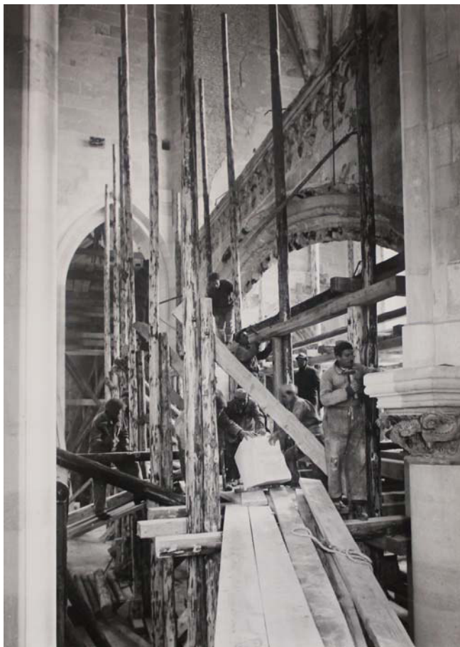
Abbildung 75: St. Stephan, Westempore, Gerüstaufstellung, November 1948.
