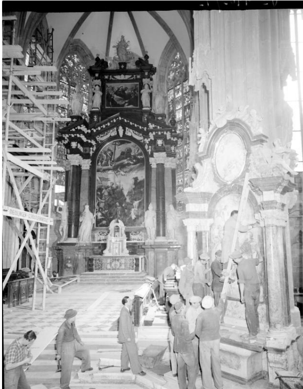
Abbildung 114: St. Stephan, Chor, Restaurierungsarbeiten am Karl-Borromäus-Altar.
