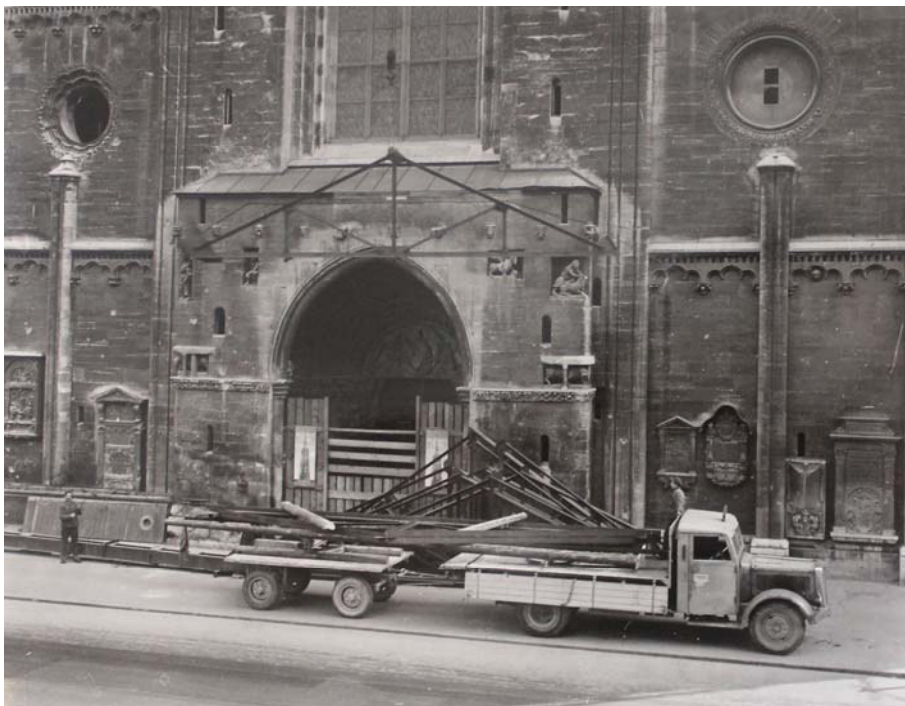
Abbildung 55: St. Stephan, Aufziehen der Binder für den Dachstuhl.
