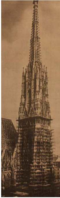
Abbildung 110: St. Stephan, Südturm, Gerüst im unteren Bereich 1961.
