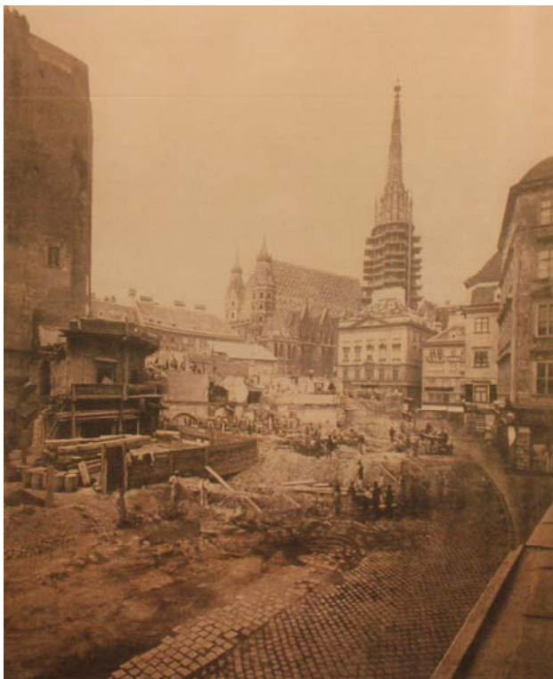
Abbildung 151: Demolierung der Häusergruppe zwischen Graben und Stock-im-Eisen-Platz, 1866.
