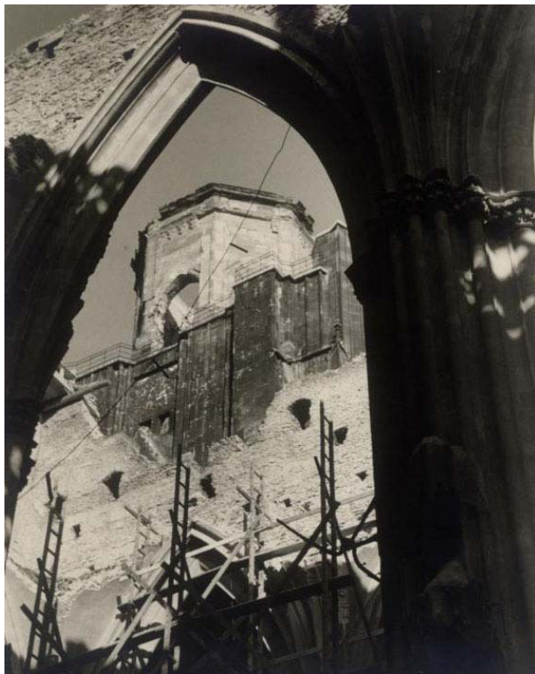
Abbildung 17: St. Stephan, Blick vom Inneren des Domes auf den Nordturm 1946.
