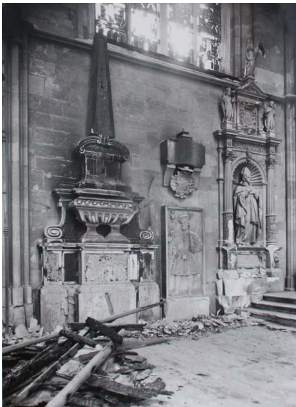
Abbildung 39: St. Stephan, Frauenchor, Schäden an der nördlichen Wand.
