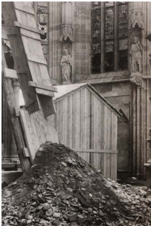
Abbildung 113: St. Stephan, Chor, Schuttrutsche und Schutzhütte über Friedrichsgrab.
