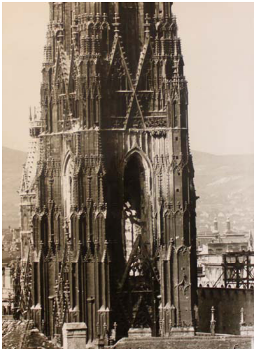
Abbildung 19: St. Stephan, Schäden am Südturm 1945.
