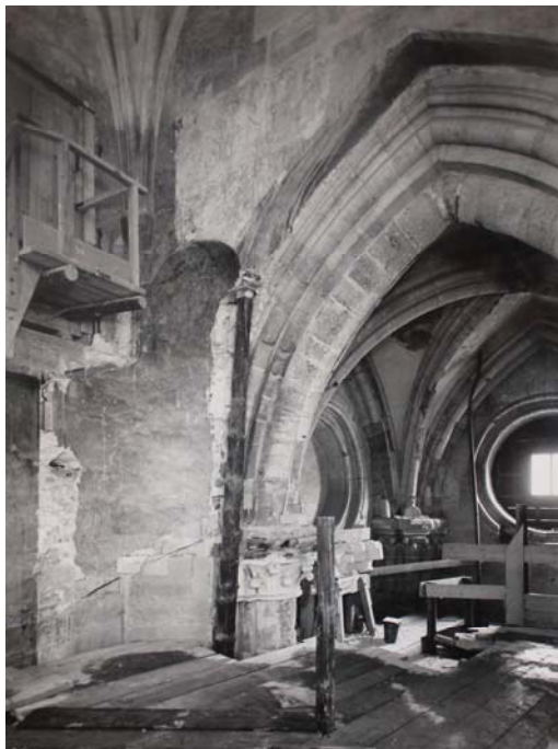
Abbildung 87: St. Stephan, Westempore, nach Abtragen des Treppenturmes Juni 1949.
