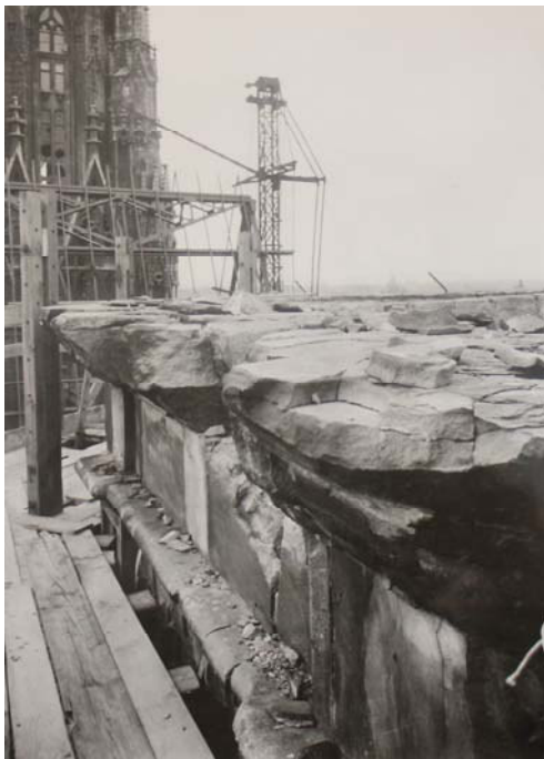
Abbildung 103: St. Stephan, Schäden im Nordturm, 1948.
