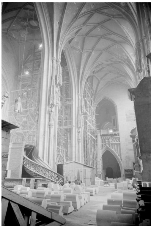
Abbildung 89: St. Stephan, Langhaus während der Restaurierung 1948.
