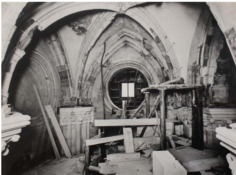
Abbildung 77: St. Stephan, Restaurierung der Westempore.
