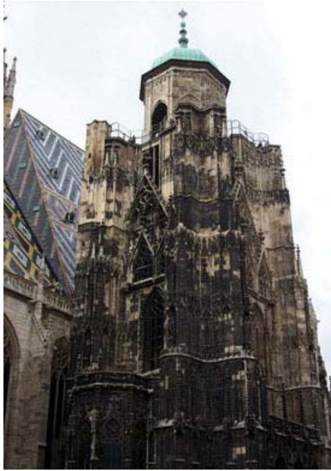
Abbildung 108: St. Stephan, Ansicht auf den Nordturm, 2012.
