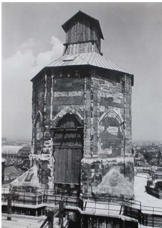
Abbildung 105: St. Stephan, Nordturm mit provisorischer Holzabdeckung 1949.
