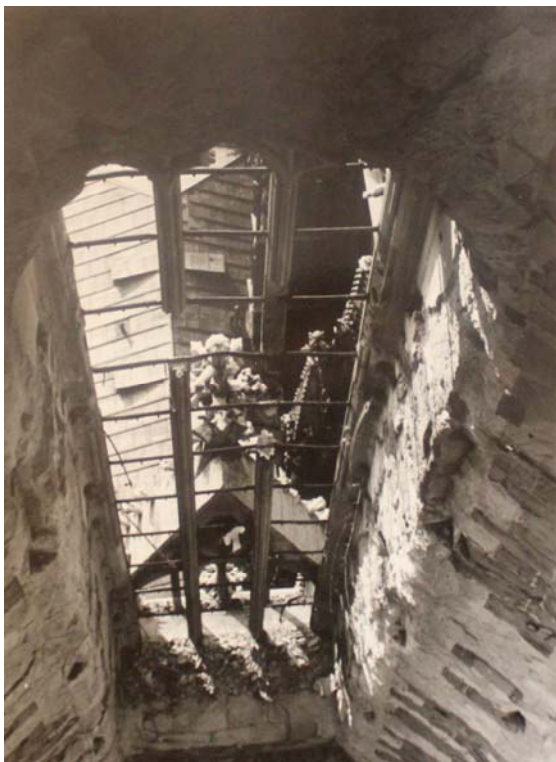
Abbildung 23: St. Stephan, Südturm, Westfenster von Innen 1945.
