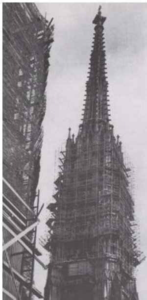
Abbildung 109: St. Stephan, Südturm, Gerüst im oberen Bereich 1954.
