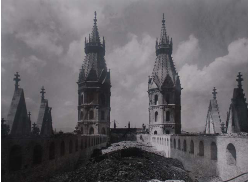
Abbildung 42: St. Stephan, Blick in Richtung Heidentürme 1945.
