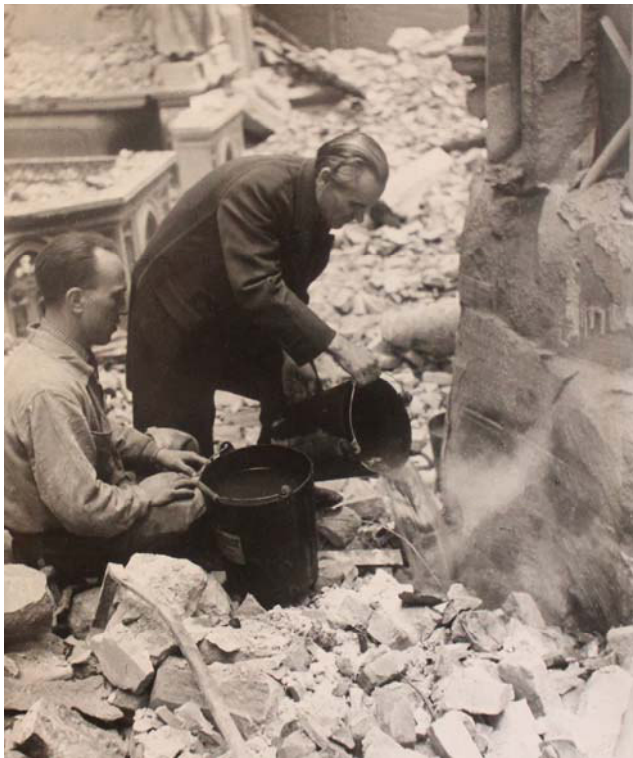
Abbildung 117: St. Stephan, Restaurierung eines Chorpfeilers.
