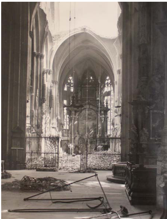
Abbildung 31: St. Stephan, Chor Mittelschiff mit eingebrochenem Gewölbe 1945.
