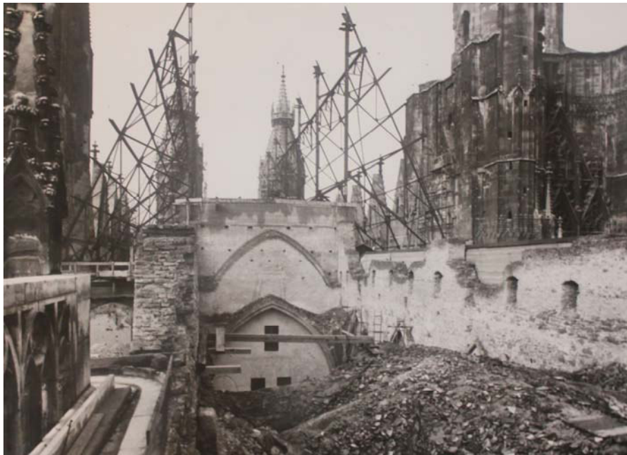
Abbildung 57: St. Stephan, Der neue Dachstuhl am 17. September 1948.
