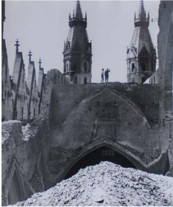
Abbildung 44: St. Stephan, Blick über dem Chor in Richtung Heidentürme 1945.
