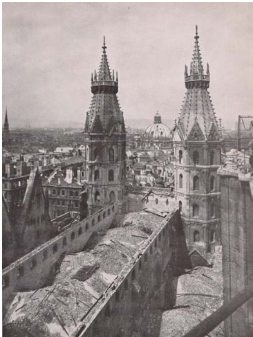
Abbildung 167: Lucca Chmel, Blick auf das zerstörte Dach, 1945.
