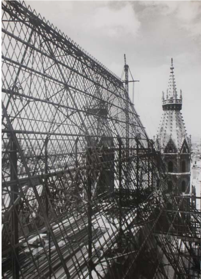
Abbildung 60: St. Stephan, Der neue Dachstuhl
