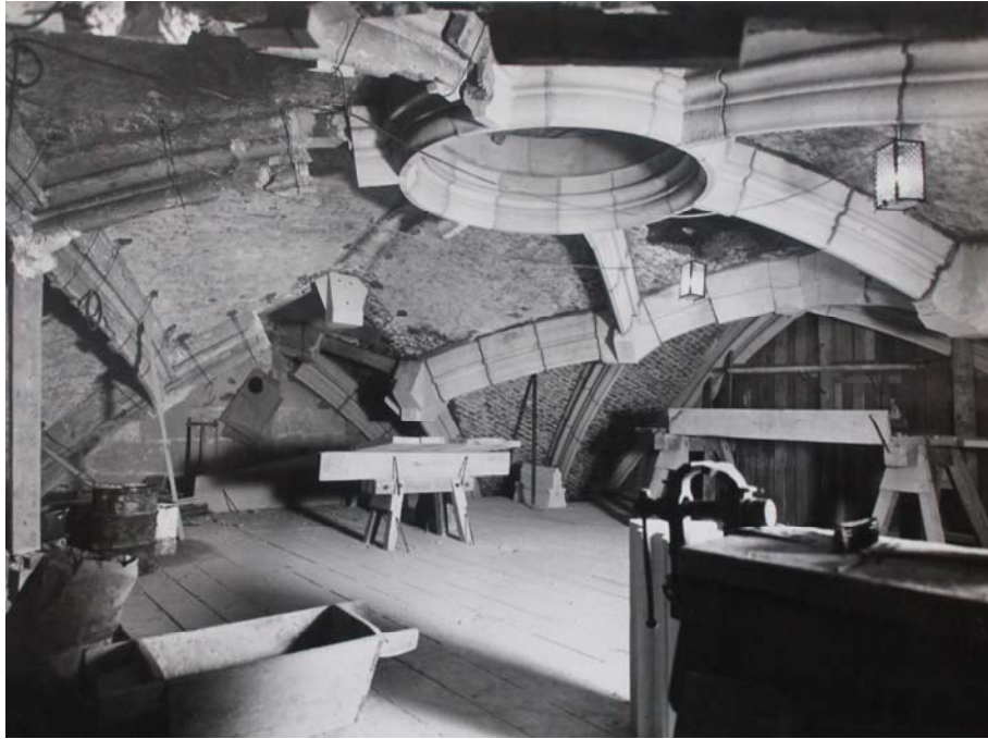
Abbildung 76: St. Stephan, Westempore, Restaurierung Gewölberippen, Februar 1949.
