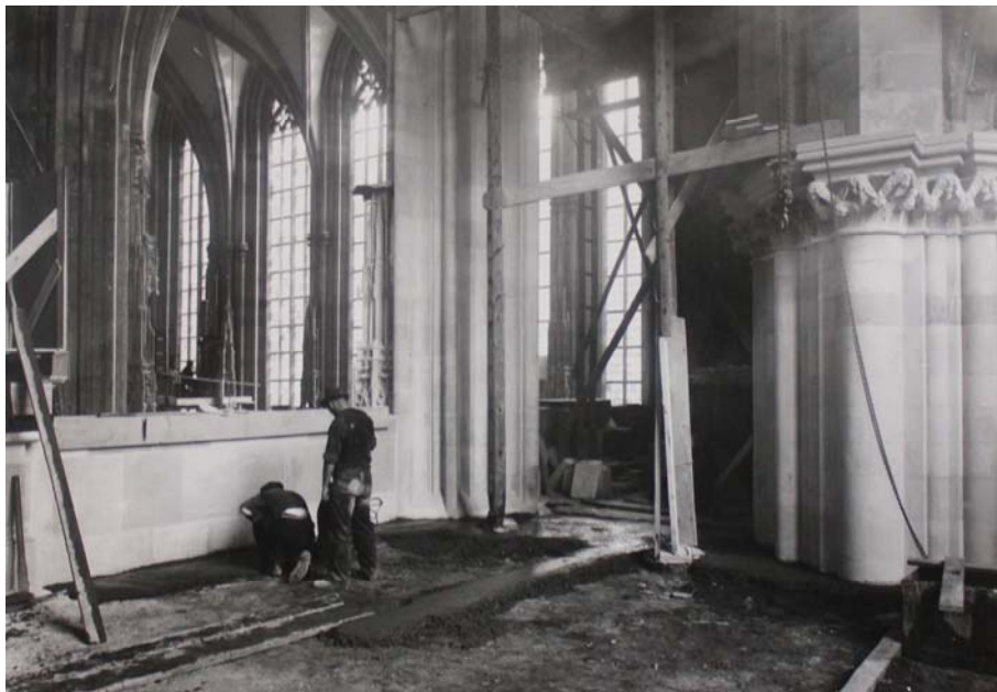
Abbildung 73: St. Stephan, Westempore, Unterlagsbeton wird gegossen, Oktober 1948.
