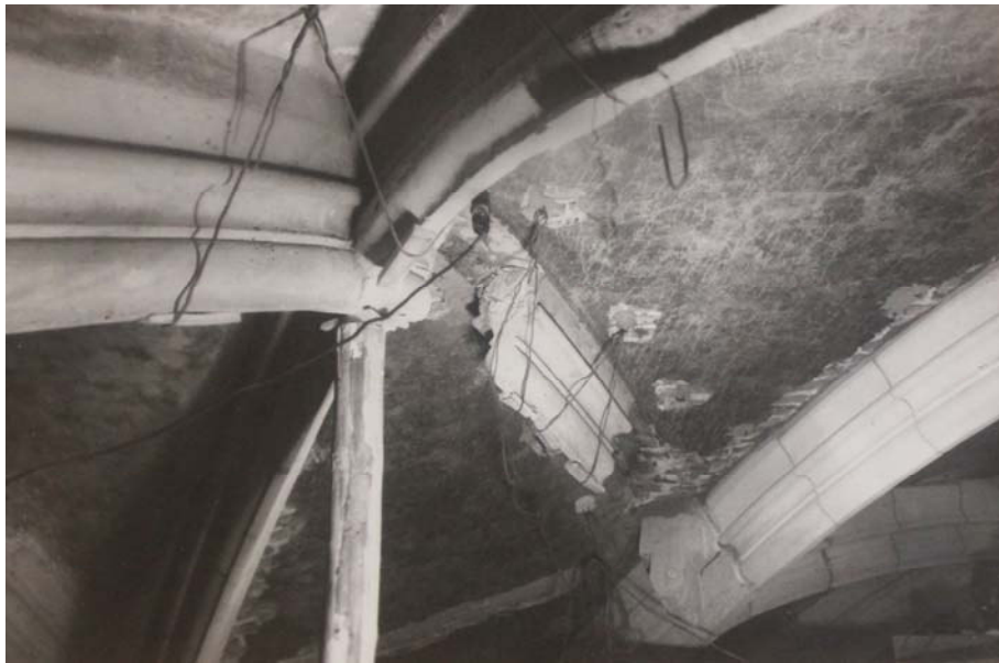
Abbildung 93: St. Stephan, Sicherung der Gewölberippen.
