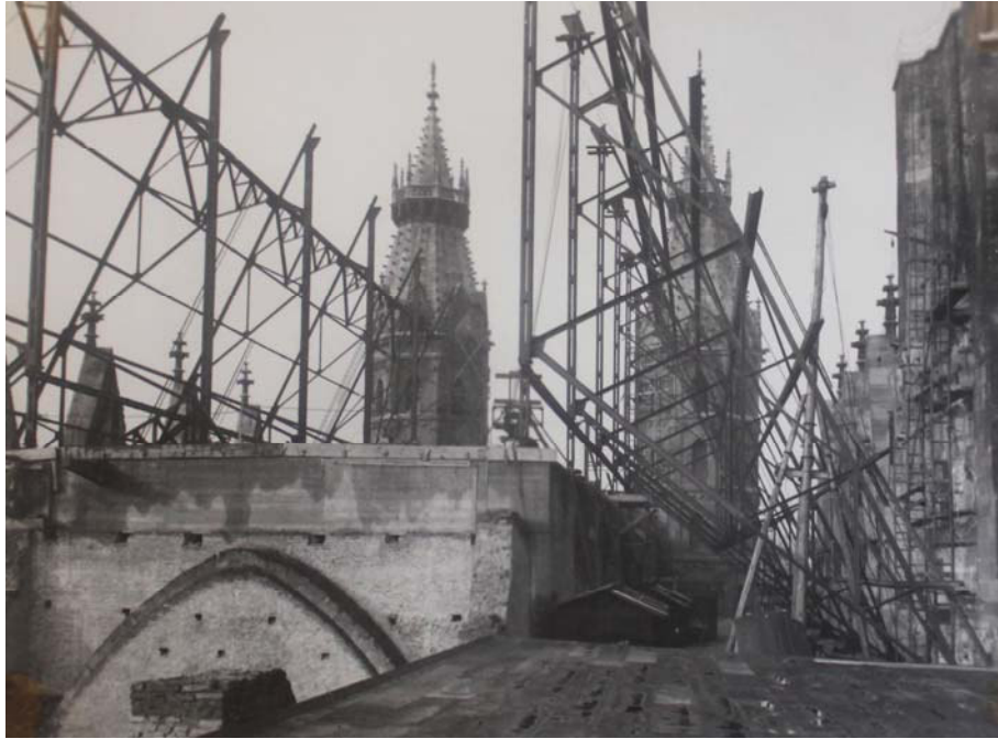
Abbildung 56: St. Stephan, Der neue Dachstuhl am 5. Februar 1947.
