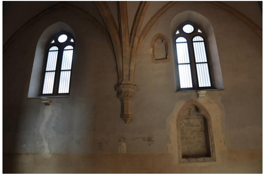
Abb. 33: Prag, ehemaliges Agneskloster, Marienkapelle, Nordwand
