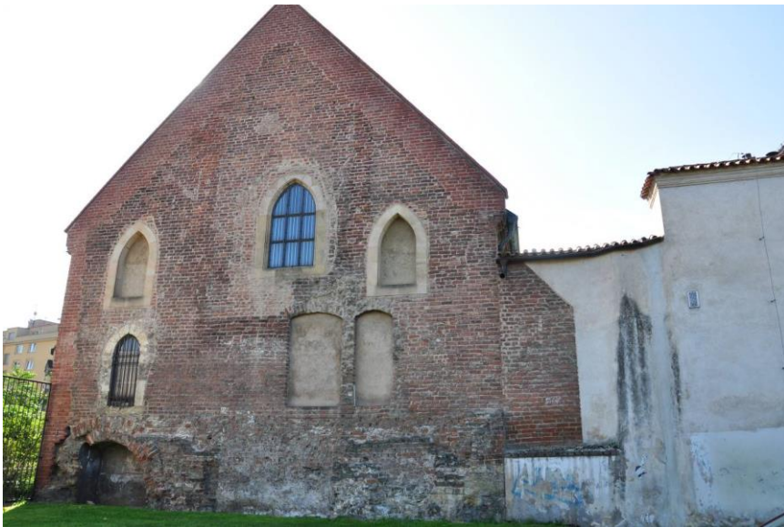
Abb. 18: Prag, ehemaliges Agneskloster, Wohnhaus der Nonnen, Nordwand
