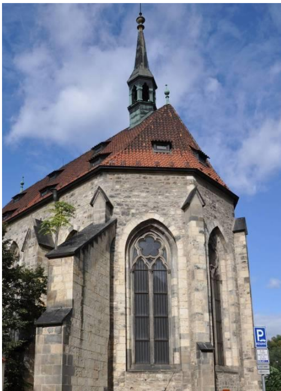
Abb. 42: Prag, ehemaliges Agneskloster, Salvatorkirche, Außenansicht südöstlich, Chorpolygon
