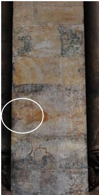
Abb. 54: Prag, ehemaliges Agneskloster Salvatorkirche, Nordwand, Detail Reste der Polychromierung, Zeigegestus
