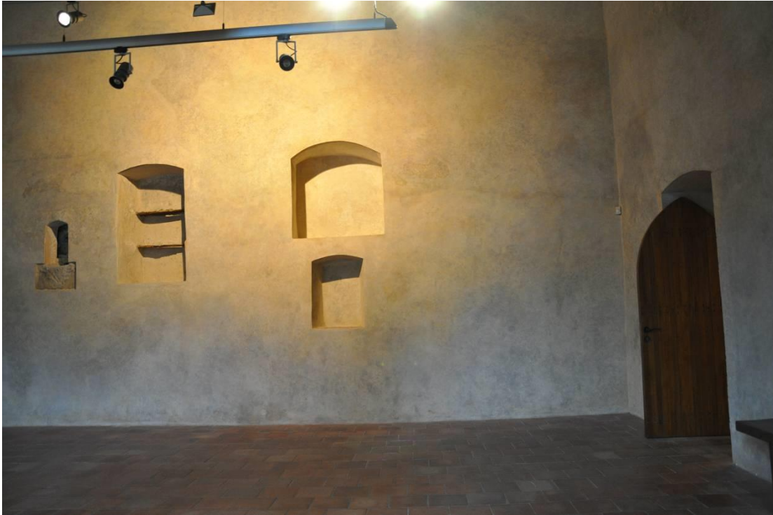
Abb. 21: Prag, ehemaliges Agneskloster, mögliches späteres Refektorium, Blick auf die Ostwand
