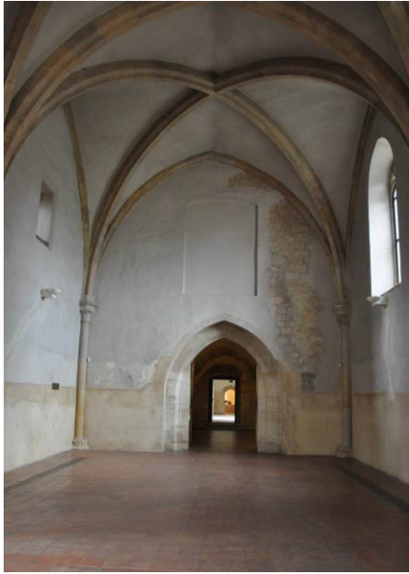
Abb. 32: Prag, ehemaliges Agneskloster, Marienkapelle, Westwand, Durchgang zum Kreuzgang, Obergeschoßhöhe Nische, ehemaliger Zugang
