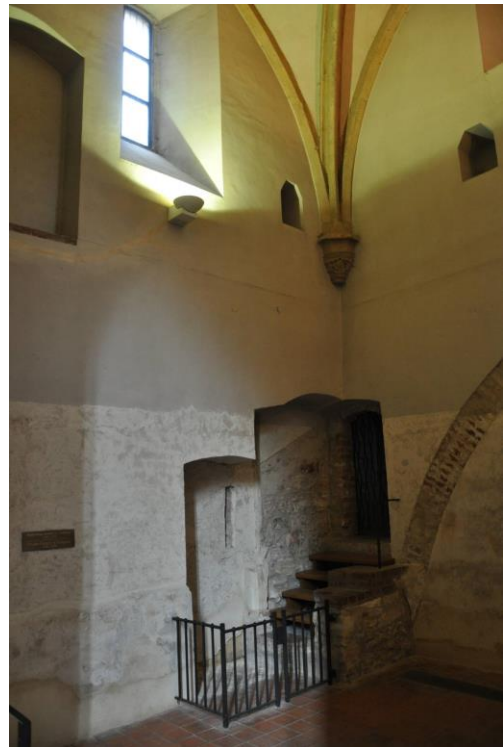
Abb. 37: Prag, ehemaliges Agneskloster, Agnesatorium, West-/Nordwand, Zugang zum Garten und im Obergeschoß große Nische an der Westwand, ehemaliger Durchgang zur Holzbrücke
