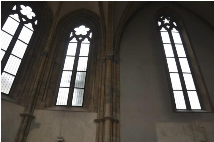
Abb. 46: Prag, ehemaliges Agneskloster, Salvatorkirche Südwand, Teil des Chorpolygons, differenzierte Aus-Arbeitung der Maßwerkfenster
