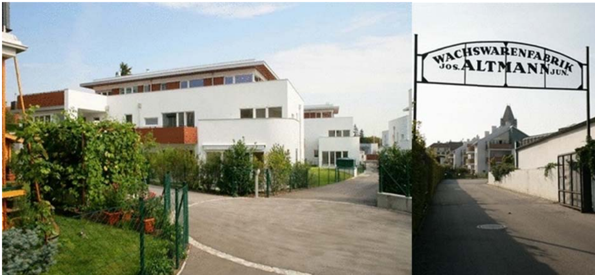
Abb. 47 & 48: Wohnhausanlagen Essigfabrik (links) und Kerzenfabrik (rechts). 398
