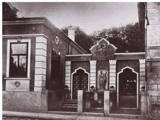
Abb. 5: Eingang zum Bad Eisenböck-Hof 124
