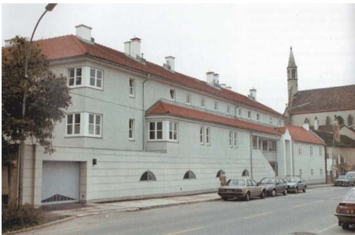
Abb. 45: Wohnhausanlage in der Donauwörther Straße, 1989. 387
