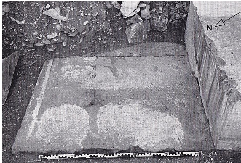
Abbildung 9: Kernbau, Westseite: Fundamentstein mit Mörtelspuren
