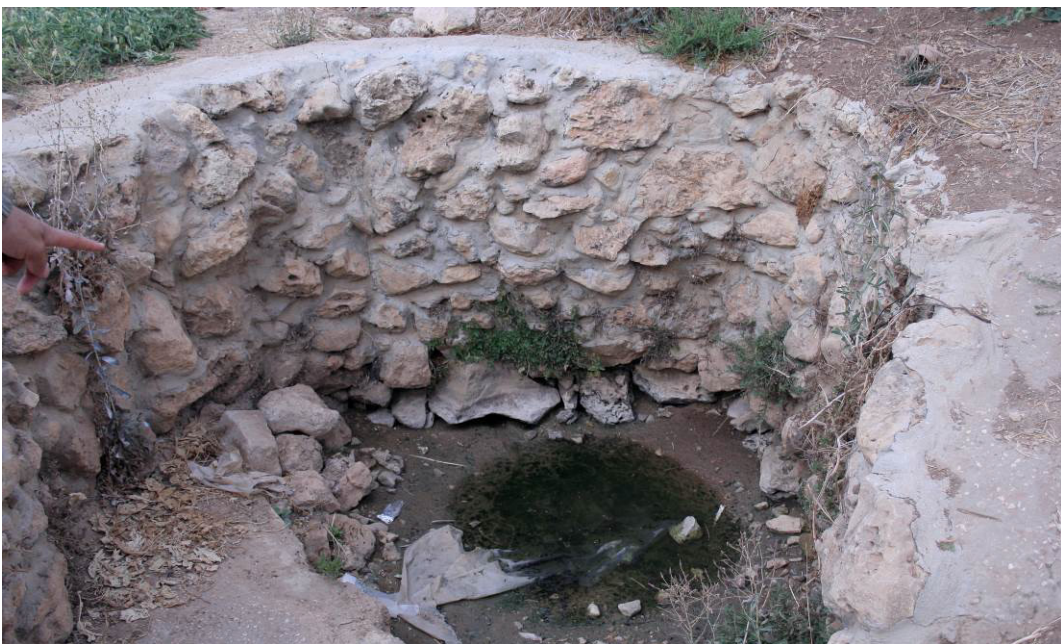
Abbildung 14&15 - Bewässerungsanlage in Wadi Fukin & Ausgetrocknete Quelle in Wadi Fukin.
