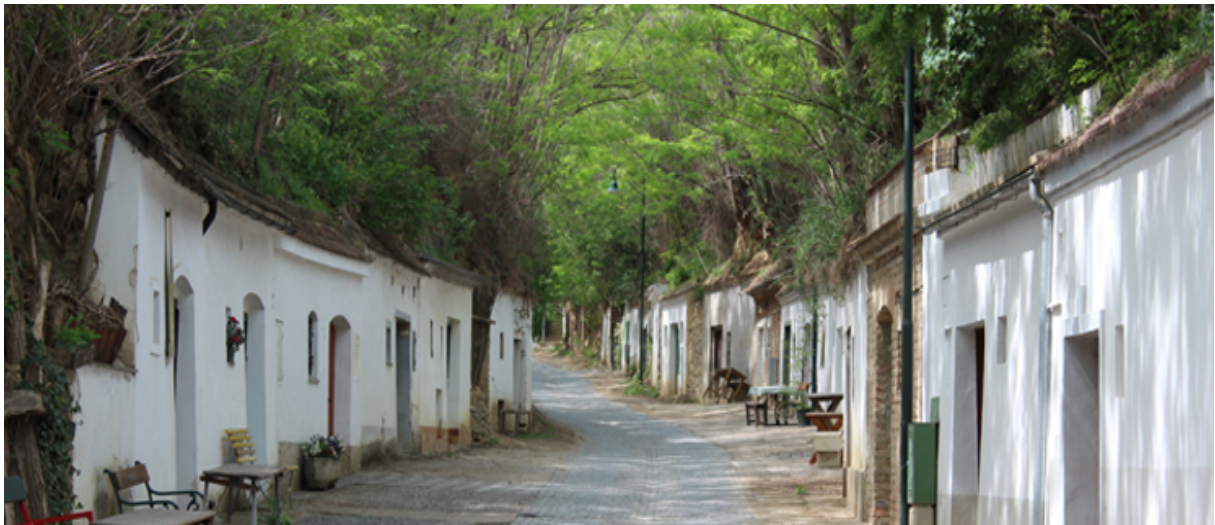
Abbildung 11: Eine typische Kellergasse im Weinviertel. Quelle: Weinviertel Tourismus.
