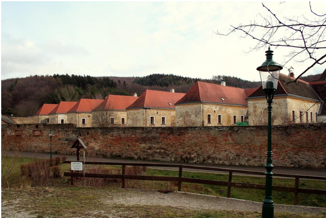
Abbildung 3: Außenansicht der Kartause Mauerbach
