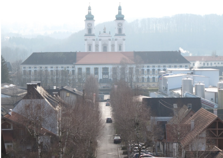
Abb. 2: Ehemaliges Kloster Garsten Blick Richtung Osten.
