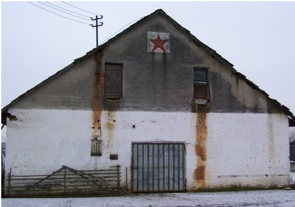
Abbildung 6: Eines der Gebäude der ehemaligen LPG. (Quelle: Mónika Karácsony:2006)
