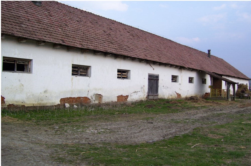
Abbildung 8: Ein Stall der ehemaligen LPG, das heute als Getreidespeicher genutzt wird. (Quelle: Mónika Karácsony: 2006)
