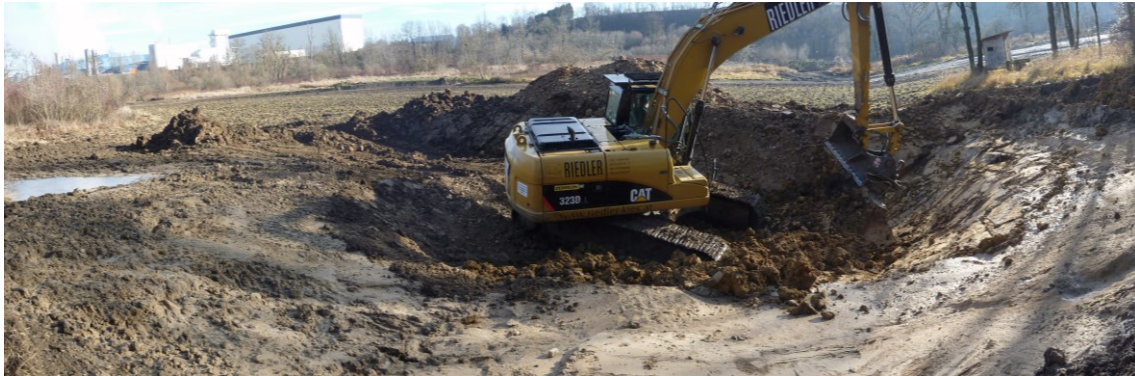
Abbildung 26: Bauarbeiten am Gewässer T3, Dezember 2011.
