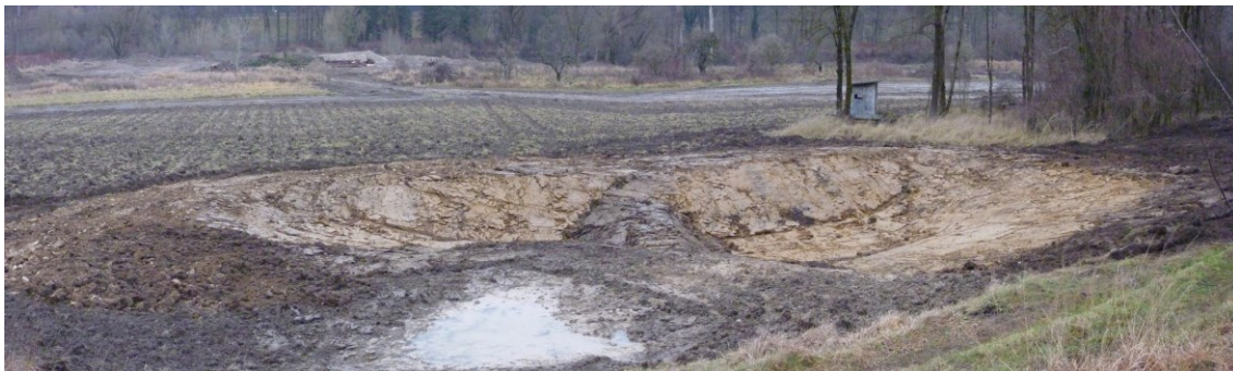
Abbildung 27: Bauarbeiten am Gewässer T3, Dezember 2011.
