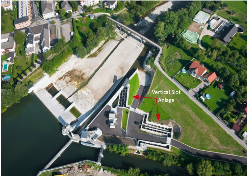
Abbildung 7: Fischeaufstiegshilfe am Flusskraftwerk Greinsfurth ( www.life-mostviertel-wachau.at ).
