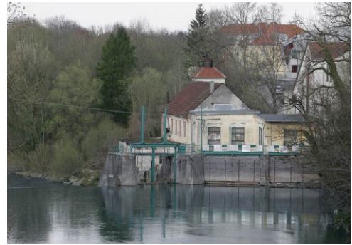
Abbildung 16: Ehemaliges Kraftwerk Hofmühle ( www.ybbs-aesche.at ).
