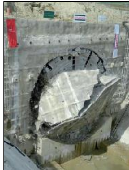
Foto 3: Schneidrad der Tunnelvortriebsmaschine Foto 4: Tunneldurchschlag Perschlingtal (Quellen: links: ÖBB-Infrastruktur Aktiengesellschaft 2006a; rechts: ÖBB-Infrastruktur Aktiengesellschaft 2010d)
