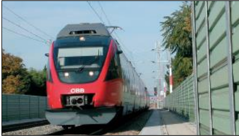
Foto 8: Lärmschutzwände für Anrainer (Quelle: ÖBB-Infrastruktur Aktiengesellschaft 2012g)
