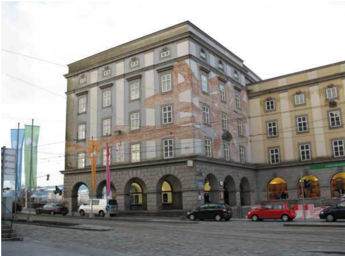
Abbildung 34: Linz, Fassadenabschlagung, Brückenkopfgebäude, 2009
