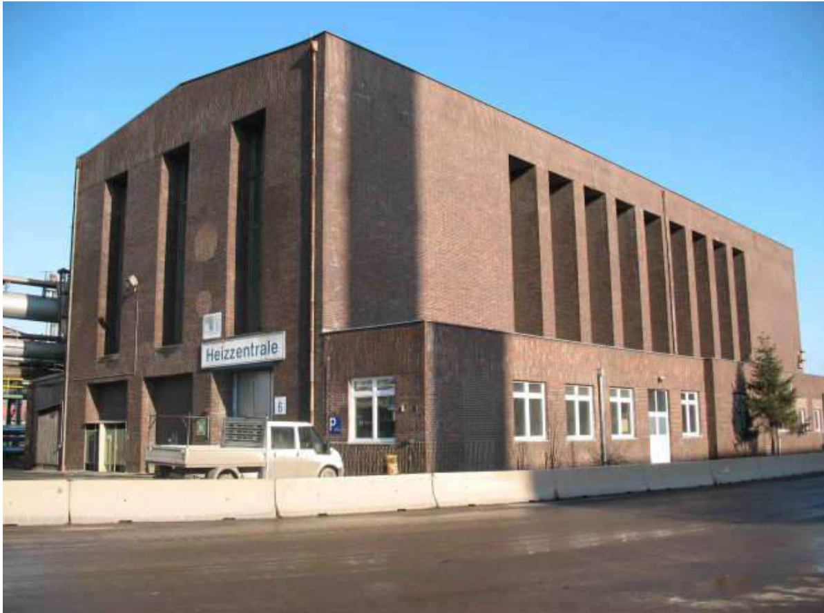
Abbildung 23: Linz, voestalpine, Heizzentrale, 2007
