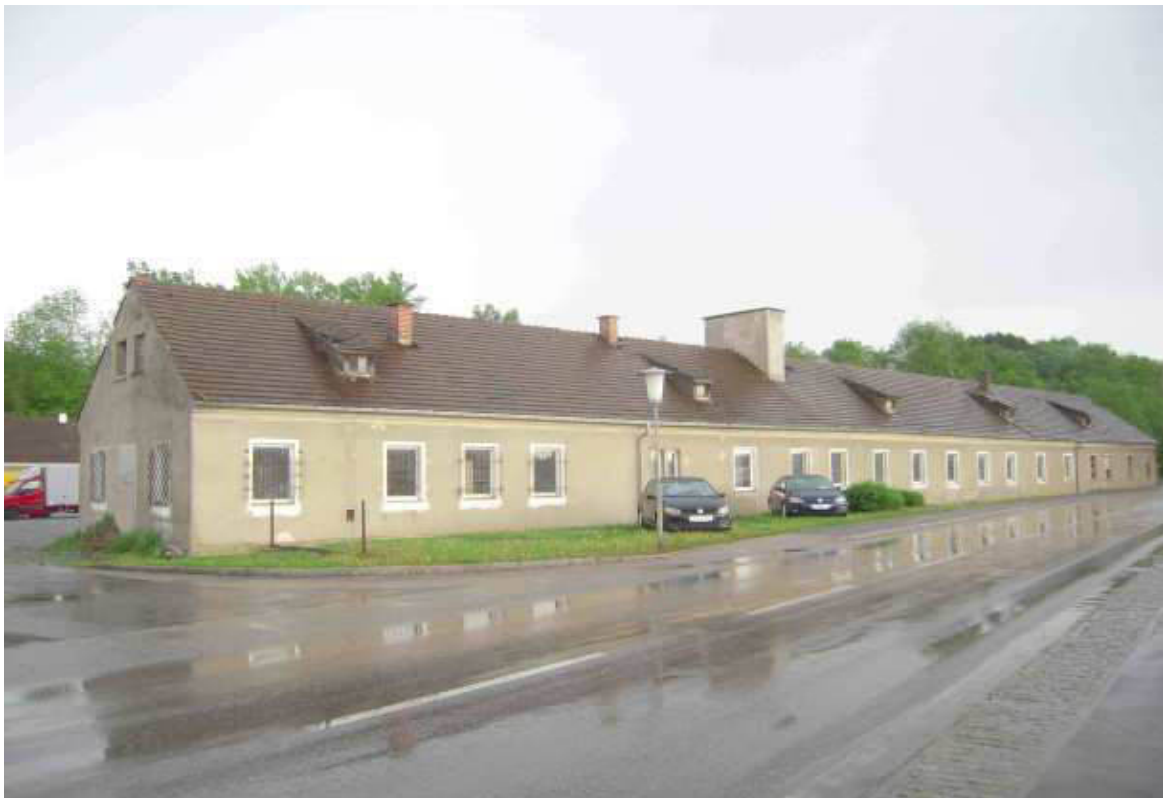
Abbildung 133: Langenstein, ehemalige SS-Baracken, 2011
