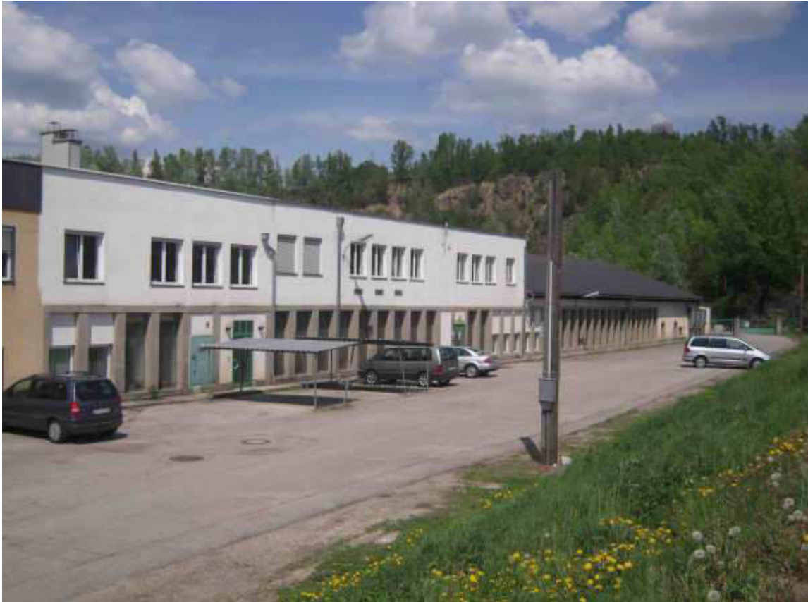
Abbildung 132: Langenstein, ehemalige Lehrlingswerkstätte, 2011
