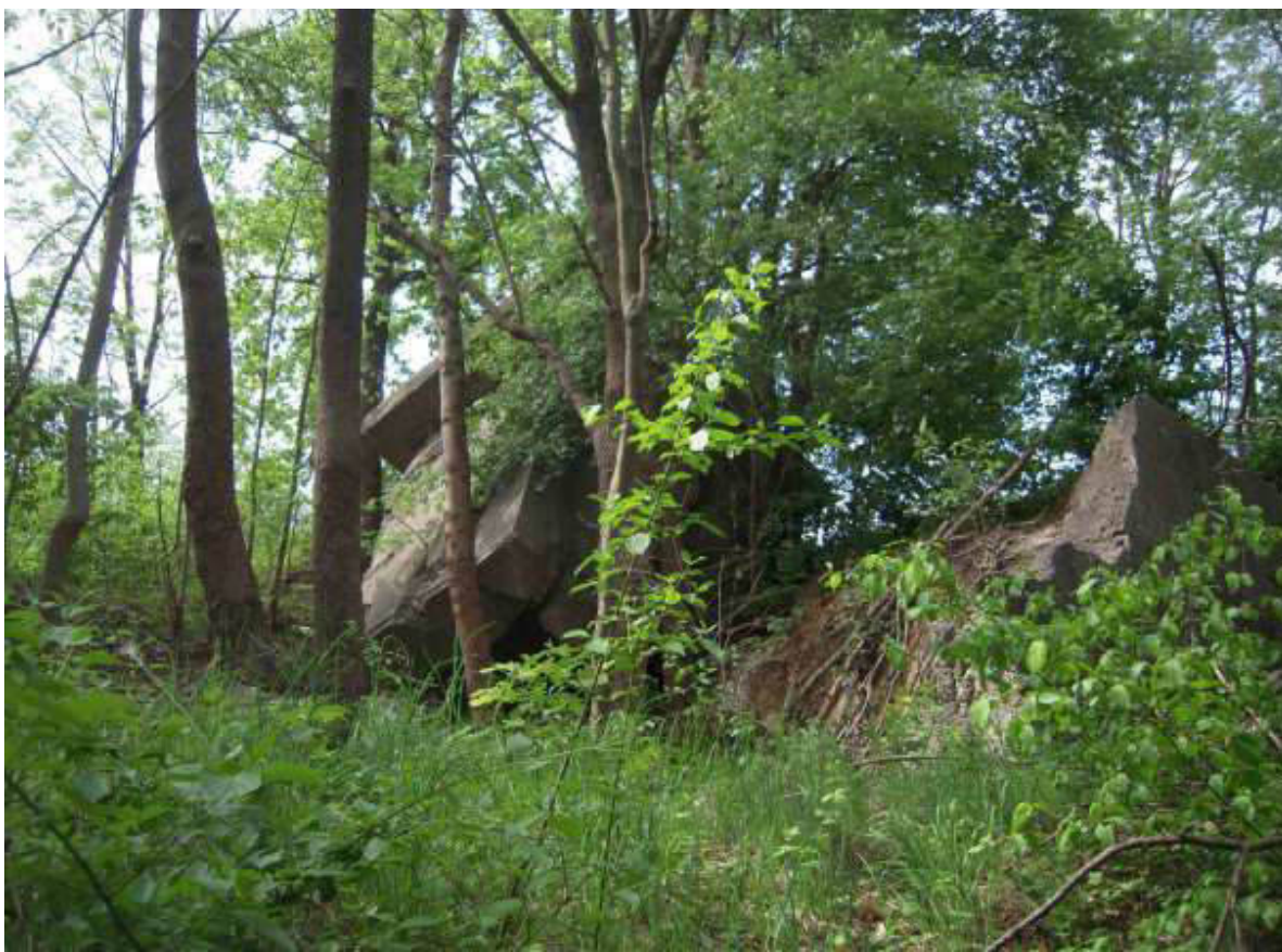
Abbildung 122: St. Georgen, Lüftungsschacht, 2011
