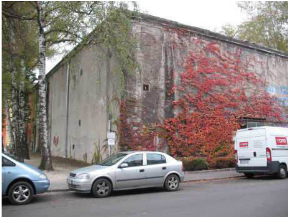
Abbildung 32: Linz, Bunker auf dem Andreas Hofer-Platz, 2008
