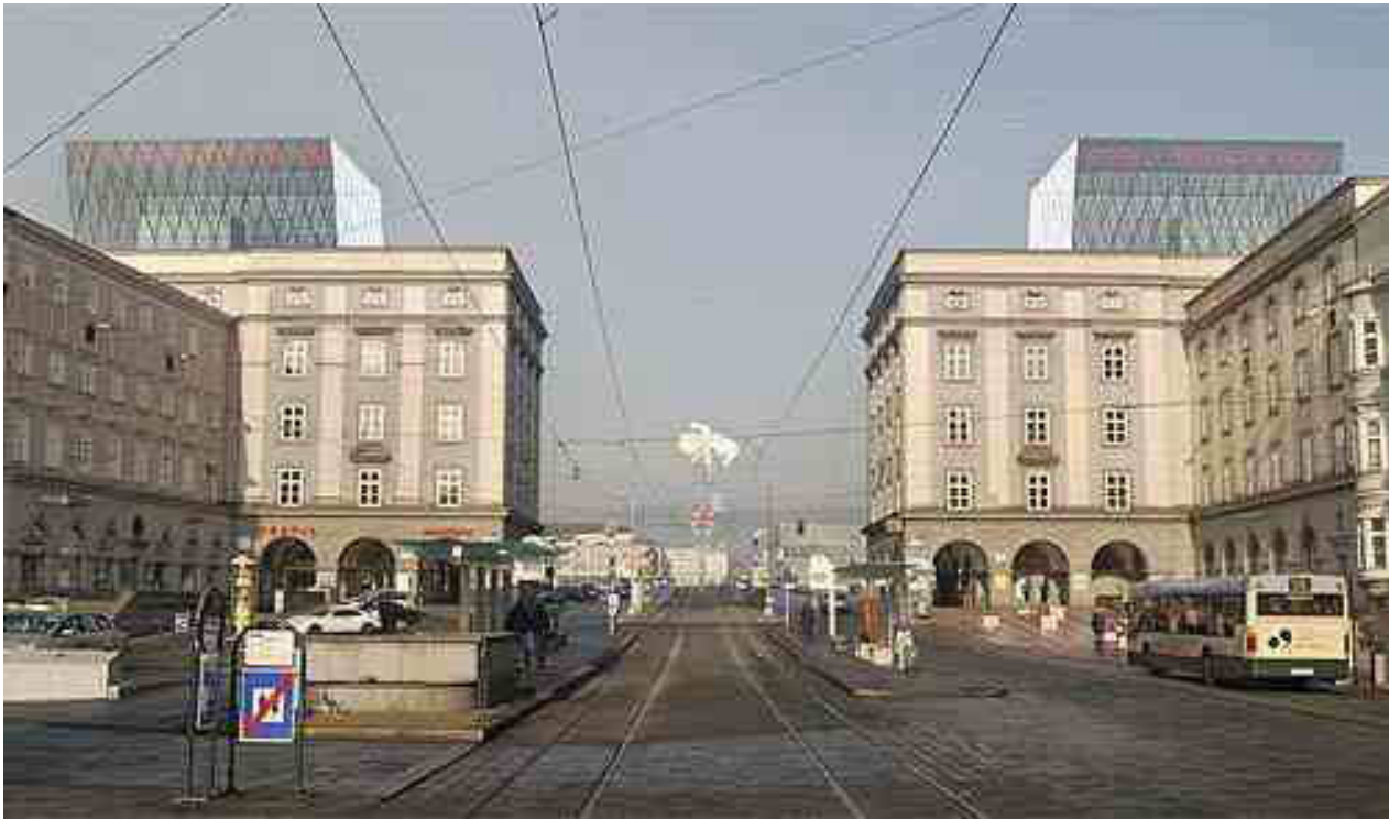
Abbildung 36: Brückenkopfgebäude, Glasaufbau, Animation
