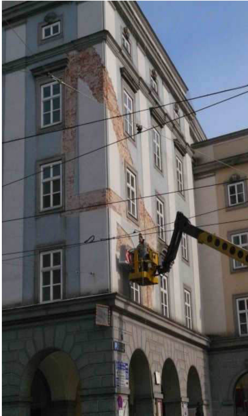
Abbildung 35: Linz, Fassadenabschlagung, Brückenkopfgebäude, 2009
