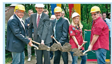
Nationalrat Johann Heil, Bürgermeister Mag. Matthias Stadler, Landesrat Mag. Karl Wilfing, Kerstin Altenburger (Fa. Porr und Pfadfinder) und Ing. Jörg Günthör nahmen den Spatenstich für den Zubau vor.
