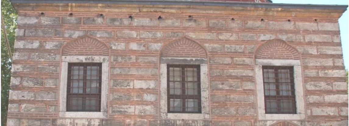
Abb. 20: Die Fenster und Bausteine von Sultān Maḥmūd I. Şıbyān Mektebi
