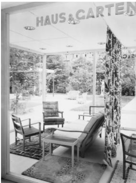
Abb. 70: Fotografie Julius Scherb, Pavillon von Haus & Garten auf der Werkbundaustellung 1930, Negativ ÖNB
