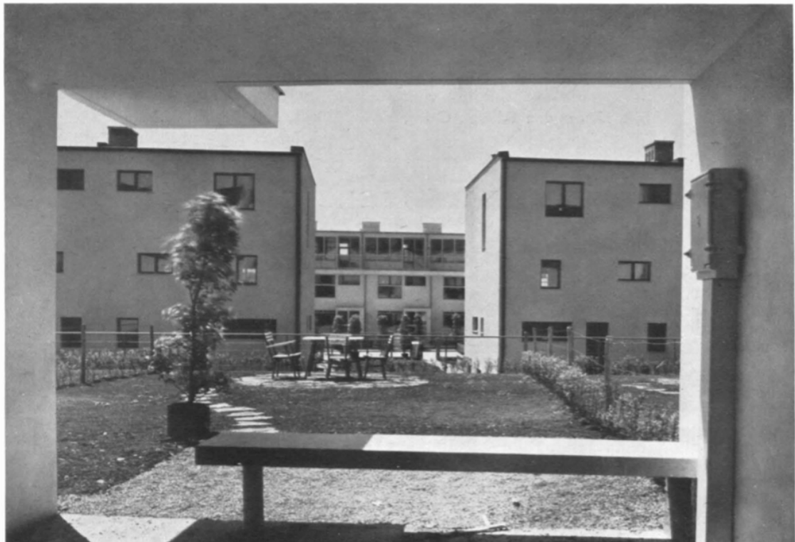
Abb. 59: Fotografie Julius Scherb, Durchblick Werkbundsiedlung Wien, (Abbildung aus: Josef Frank (Hg.), Werkbundsiedlung Wien 1932.)
