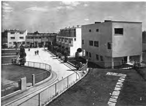
Von rechts nach links: Doppelhaus Arch. G. Gropius' (Paris); Haus Arch. L. Mies van der Rohe; Umland, Kleinhaus.
