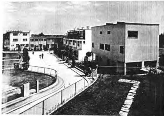
Von rechts nach links: Doppelhaus Arch. G. Gropius' (Paris); Haus Arch. L. Mies van der Rohe; Umland, Kleinhaus.
