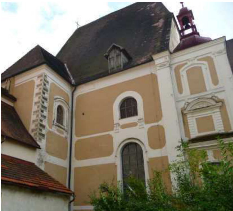
Abb. 29: Baumgartenberg, Stiftskirche, Nördl. Fassade.
