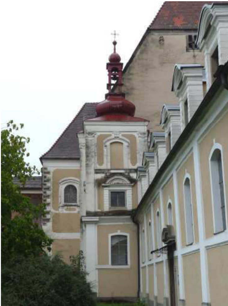
Abb. 28: Baumgartenberg, Stiftskirche, Treppenturm.
