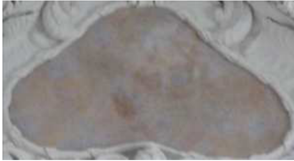
Abb. 183: Südl. Querschiffgewölbe, 61 leer.
