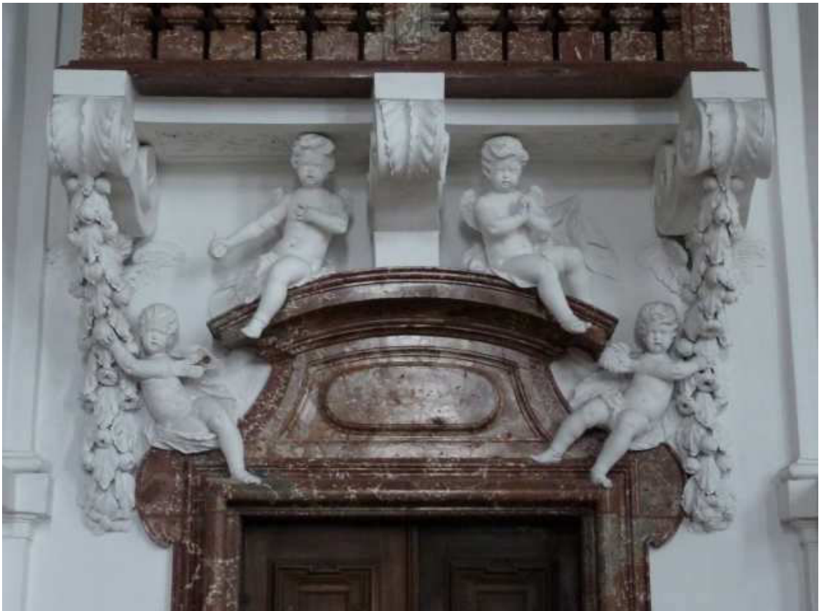
Abb. 88: Chorumgang, 2. Joch im Norden, Portal mit Stuckputti.
