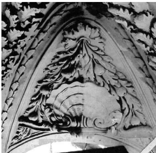
Abb. 73: Chor, Stichkappenlunette, während Restaurierung.
