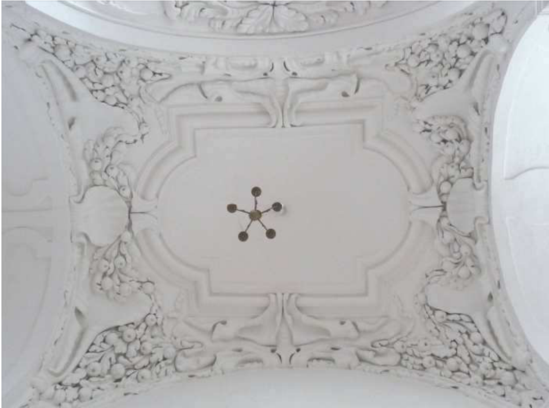
Abb. 66: Südl. Seitenschiff, 4. Joch, Platzlgewölbe.
