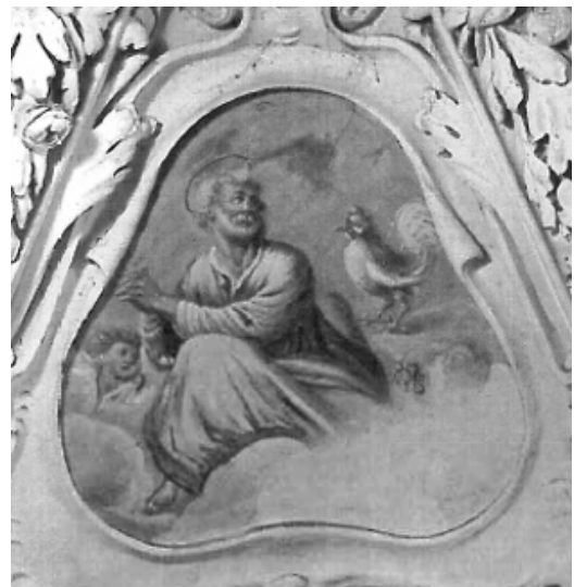
Abb. 175: 54 Zustand vor Restaurierung.
