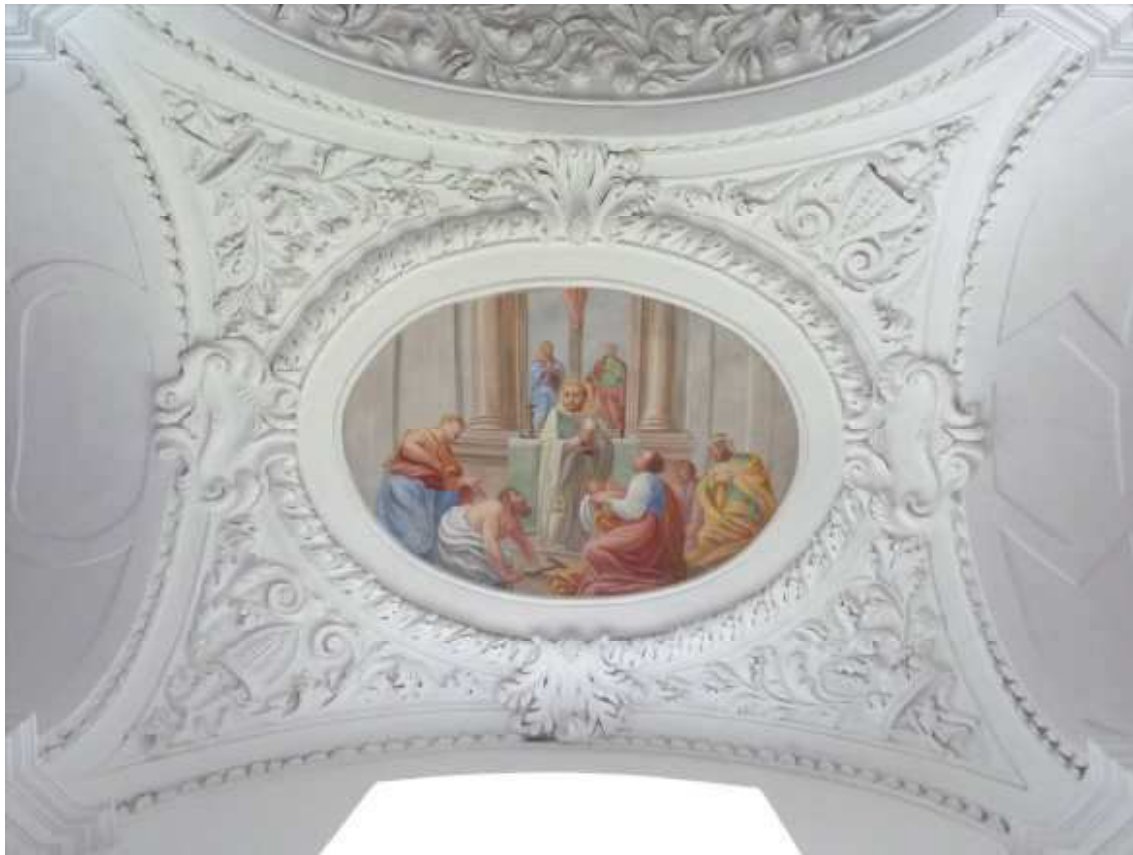
Abb. 68: Südl. Seitenschiff, 6. Joch, Platzlgewölbe mit Deckenbild 19 .
