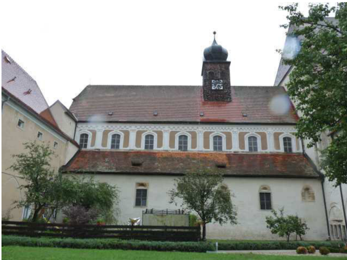
Abb. 31: Baumgartenberg, Stiftskirche, Südl. Fassade.
