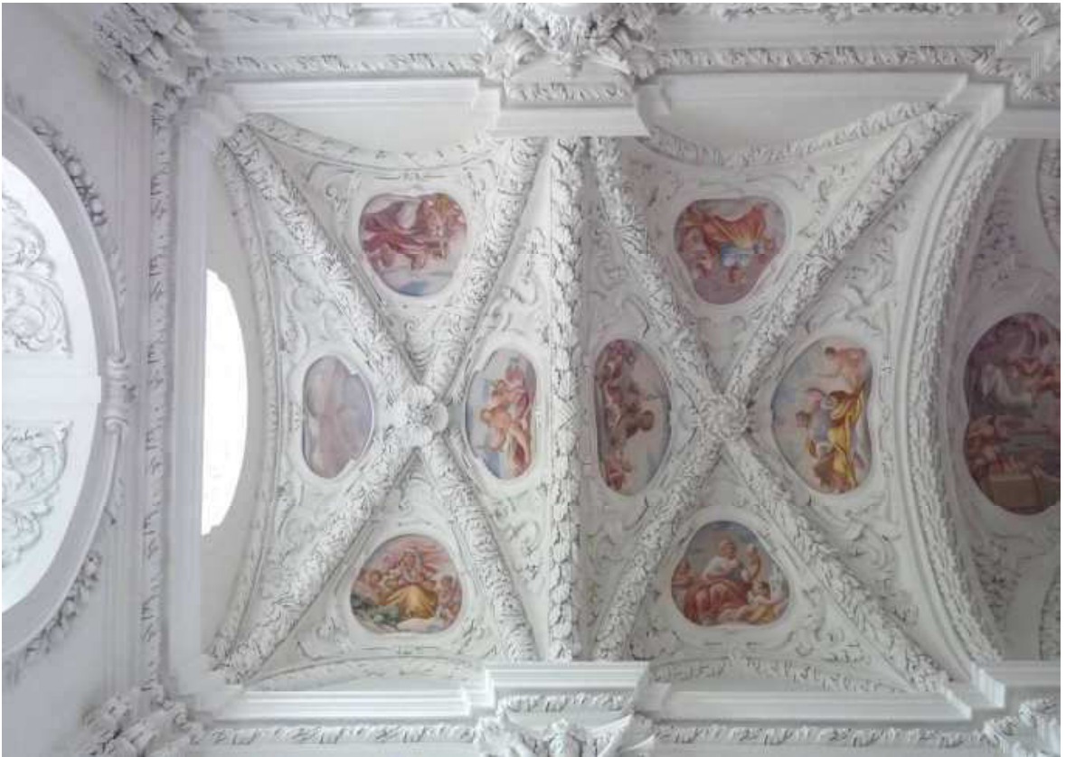
Abb. 46: Nördl. Querschiff, Gewölbe.
