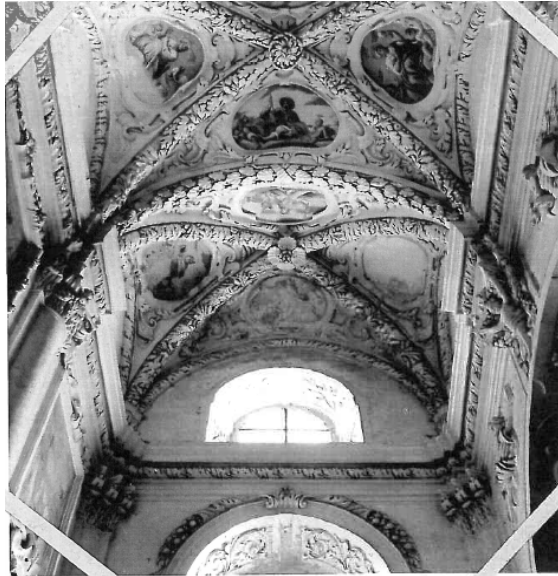
Abb. 89: Nördl. Querschiff vor Restaurierung.
