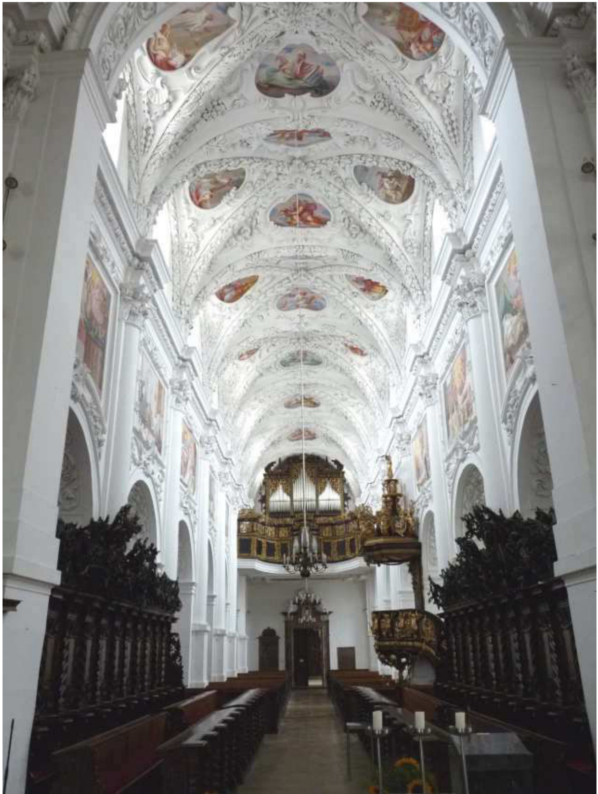
Abb. 38: Langhaus, Blick zur Orgelempore.
