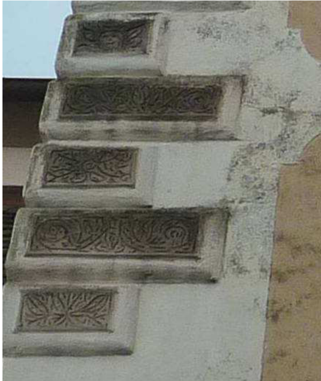
Abb. 30: Baumgartenberg, Stiftskirche, Nördl. Fassade.
