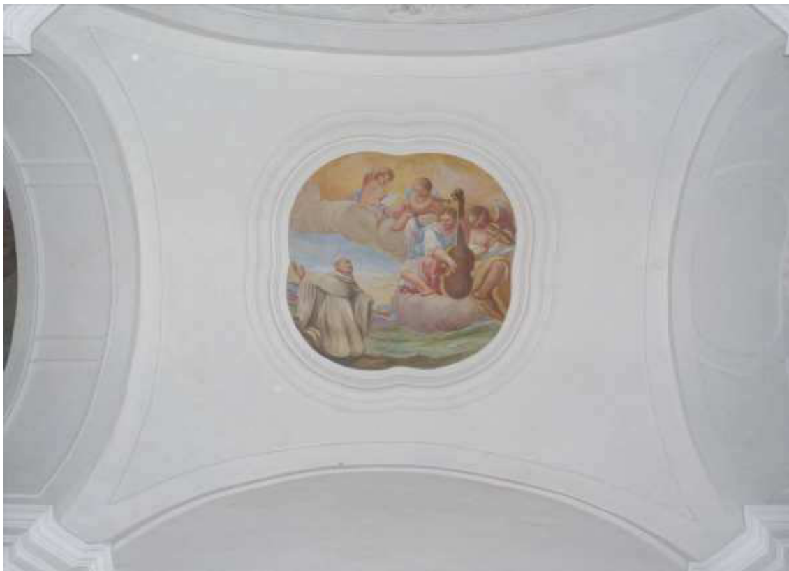
Abb. 69: Südl. Seitenschiff, 7. Joch, Platzlgewölbe mit Deckenbild 18 .
