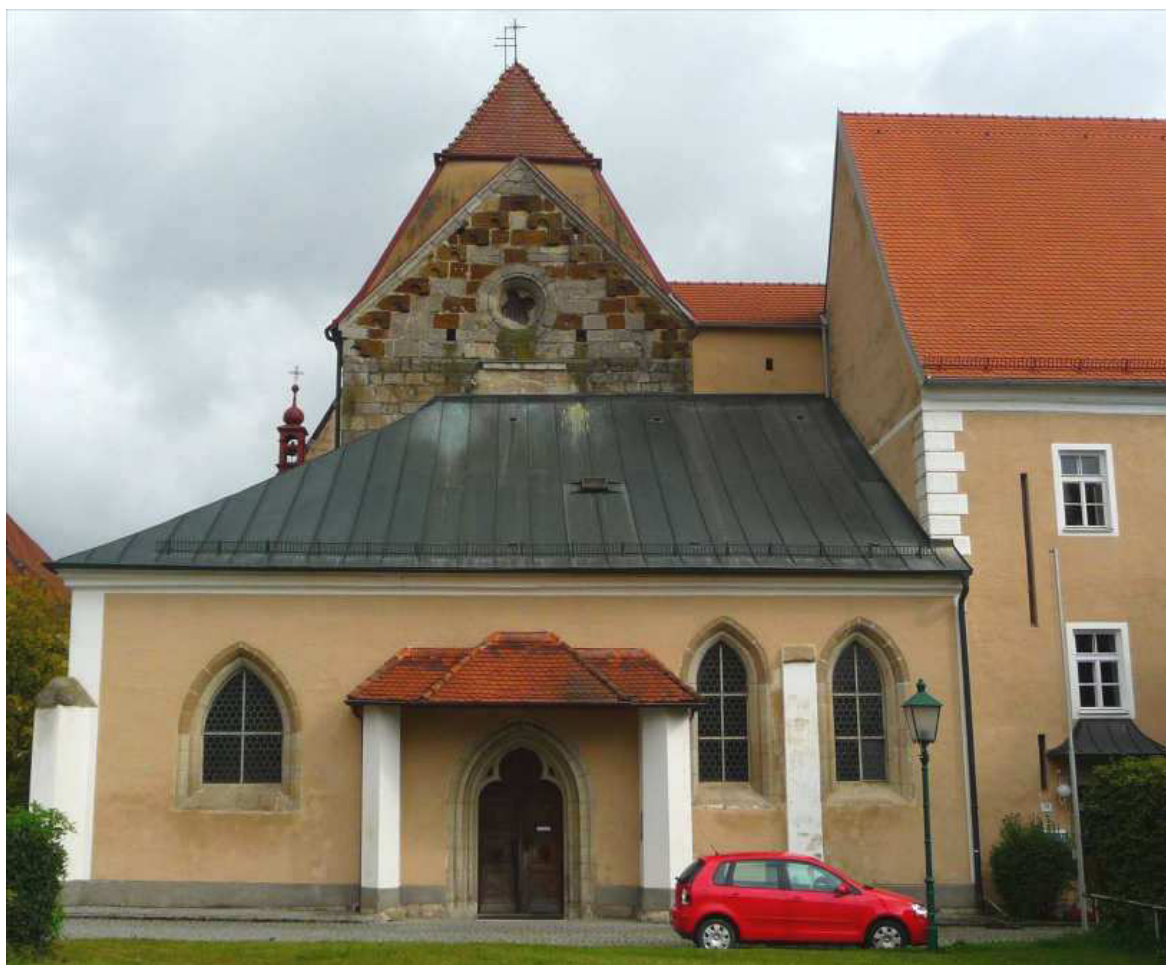
Abb. 14: Baumgartenberg, Stiftskirche, Westfassade.
