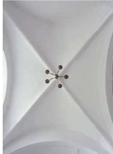
Abb. 43: Südl. Seitenschiff, Kreuzrippengewölbe.
