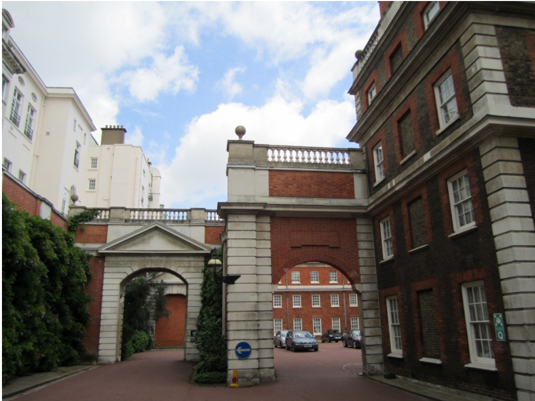
Abb. 28: Marlborough House, Zufahrt zum Vorhof.
