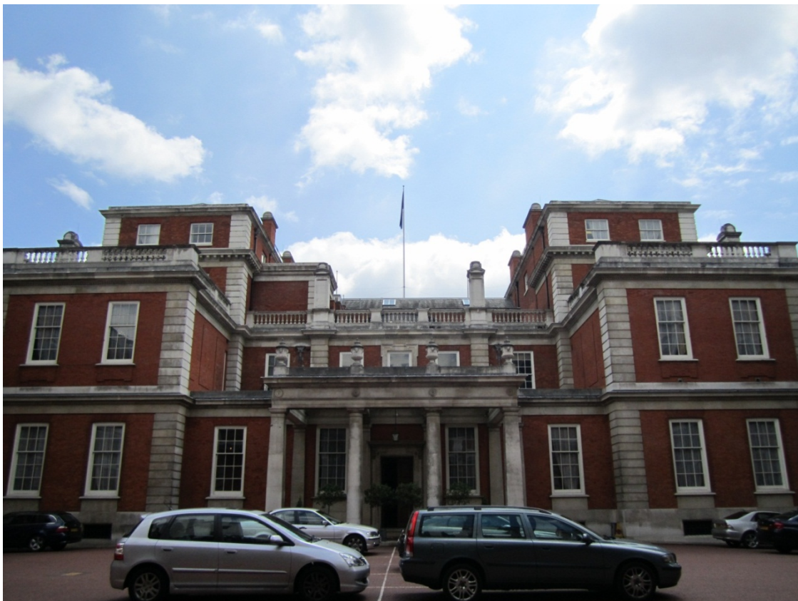
Abb. 29: Marlborough House, Eingangs-(Nord-)Fassade.
