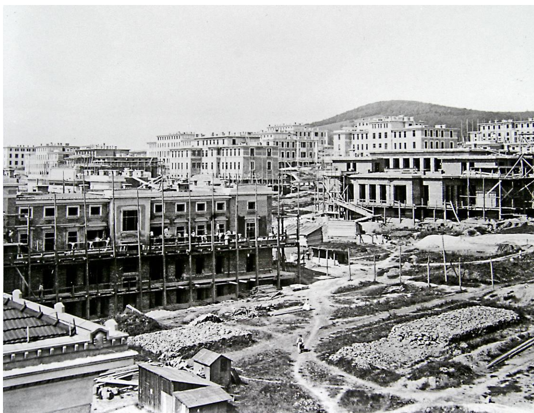
Abb. 25: Steinhof Baustelle Direktionsgebäude (li.), Gesellschaftshaus (re.)
