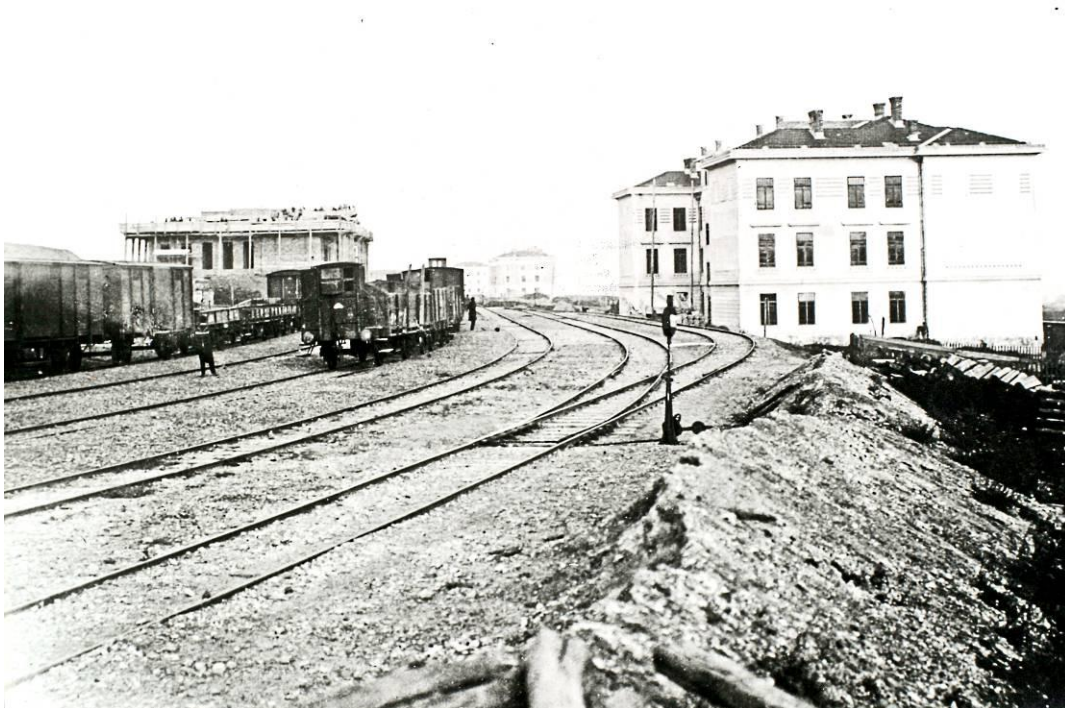
Abb. 23: Steinhof Baustelle Verschiebebahnhof
