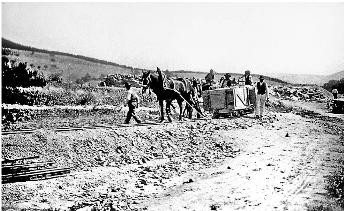
Abb. 21: Steinhof Baustelle: Materialfeldbahn zum Steinbruch
