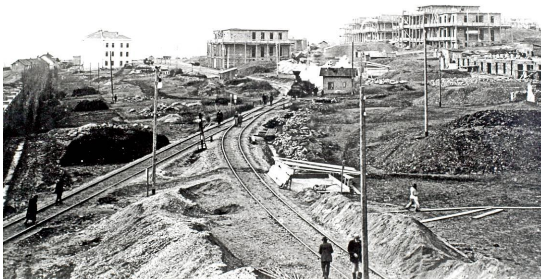
Abb. 24: Steinhof Baustelle Bahntrasse zu den Pavillon-Baustellen
