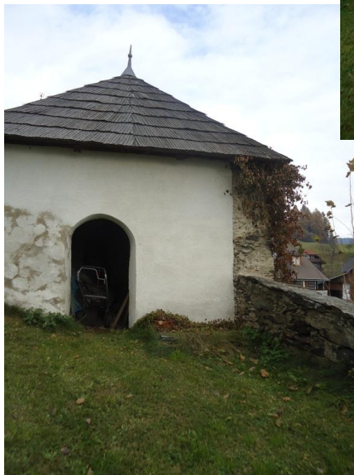
Abb. 80 Kammer in der Wehrmauer
