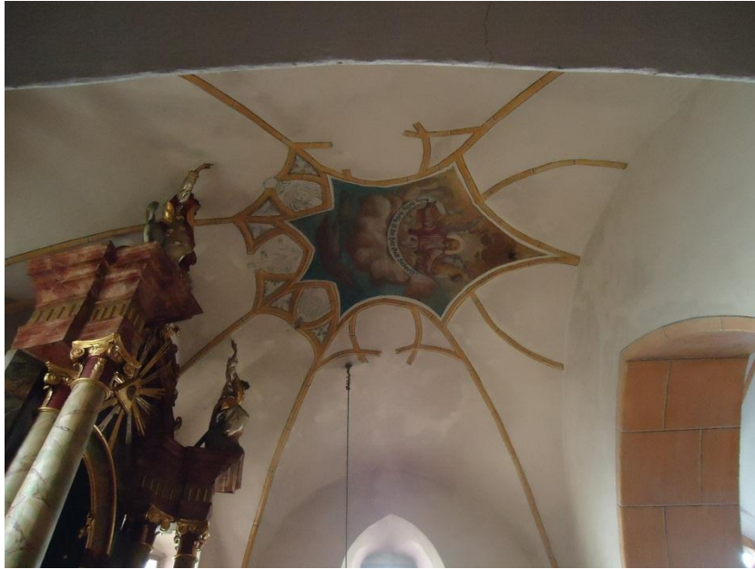
Abb. 88 gratiges Netzgewölbe im Chorraum
