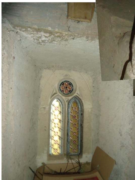
Abb. 62 Innenfenster vom ersten Geschoß im Turm in den Chor
