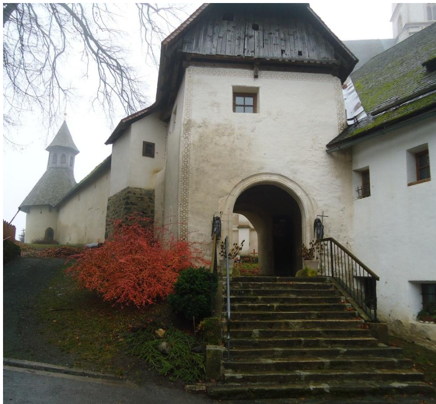
Abb. 97 Torturm im Hintergrund halbrunder Mauerturm
