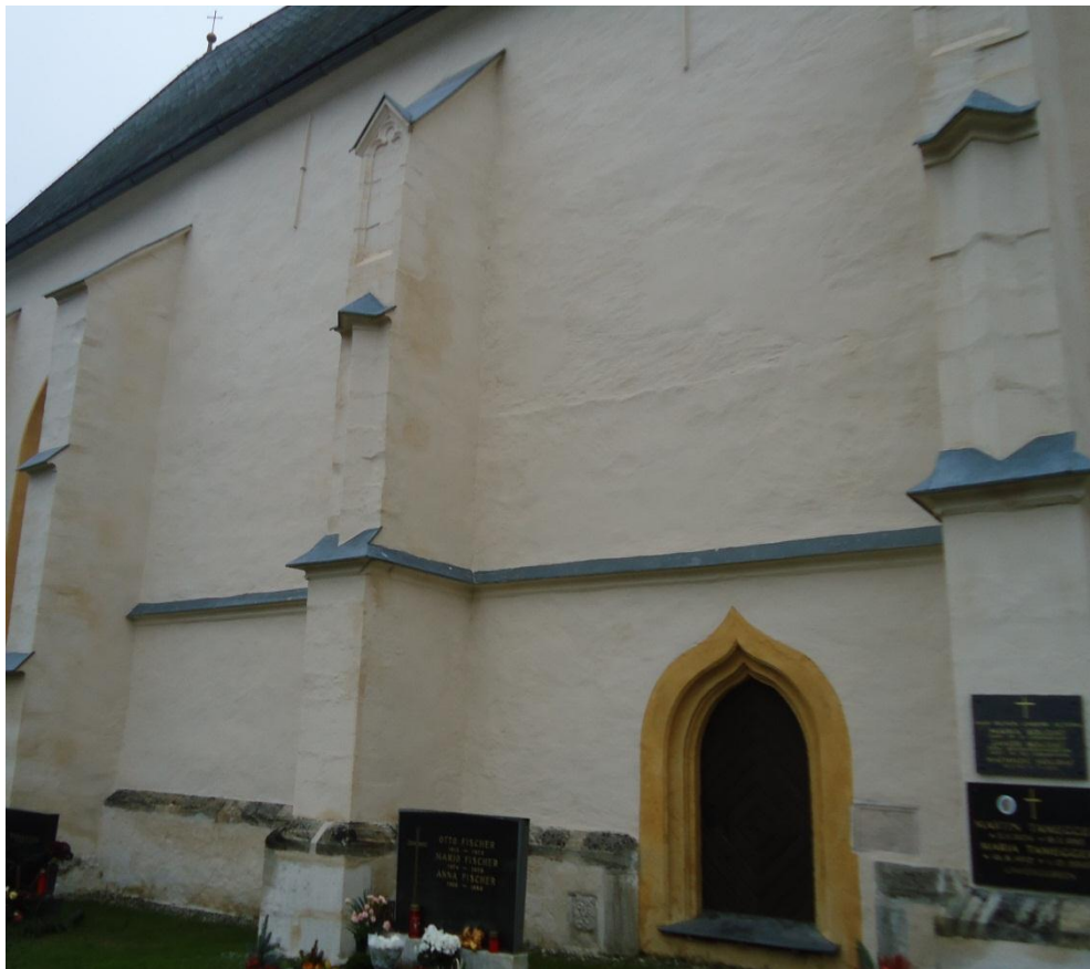
Abb. 55 übereck gestellte Steinblöcke mit Blendfeld im oberen Teil
