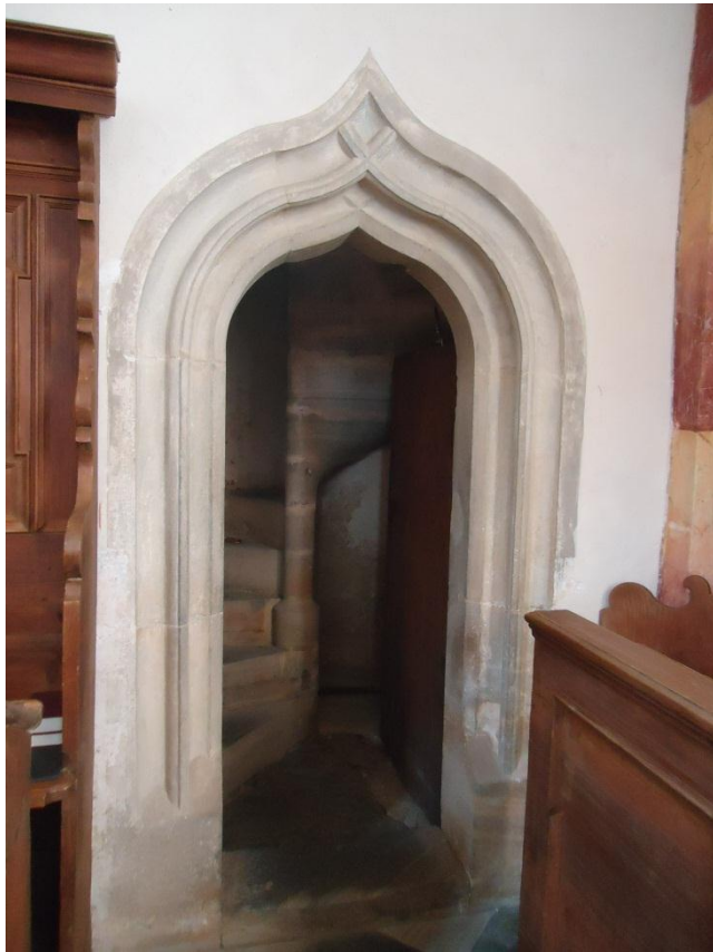
Abb. 29 Kielbogenportal zur Emporentreppe
