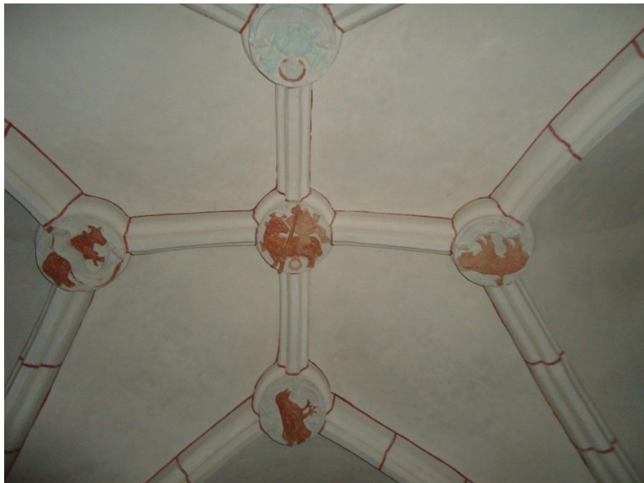
Abb. 114 reliefierte Scheiben an den Rippenschnittpunkten
