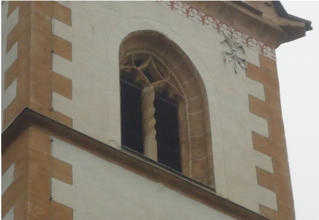
Abb. 52 gedrehte Mittelstützen der Schallfenster
