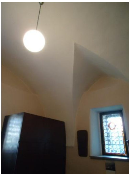
Abb. 4 Teilansicht der Sakristei
