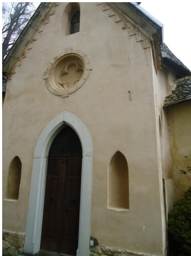
Abb. 109 Wehrturm – zur Kapelle umgestaltet
