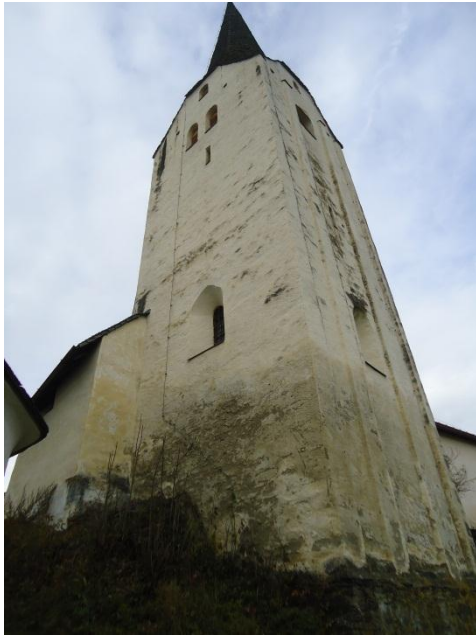
Abb. 93 freistehender Turm der Vorkirche
