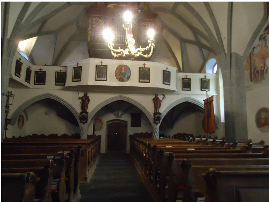
Abb. 71 dreiachsige Westempore auf gedrehten Säulen
