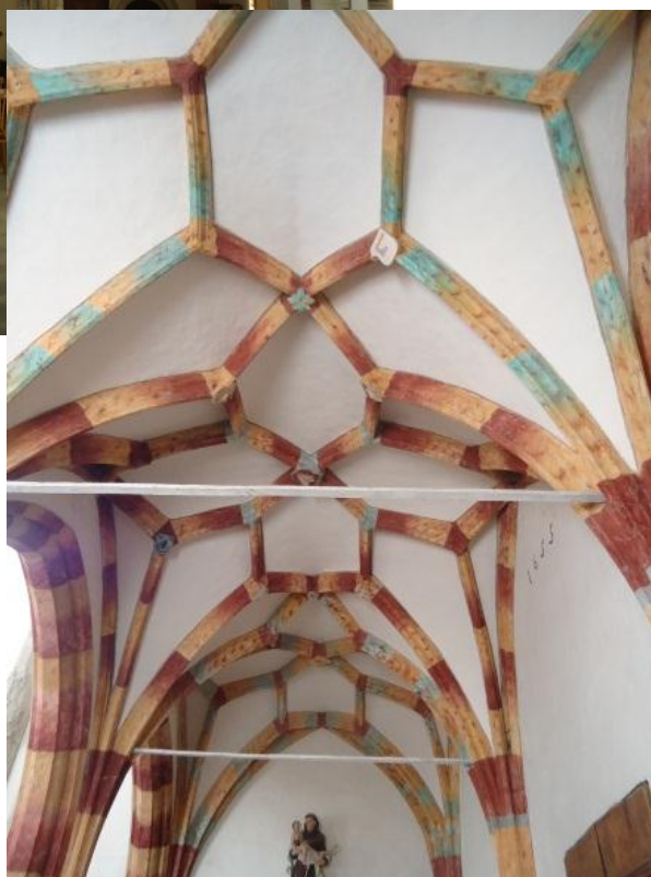
Abb. 28 Sternrippengewölbe auf Konsolen
