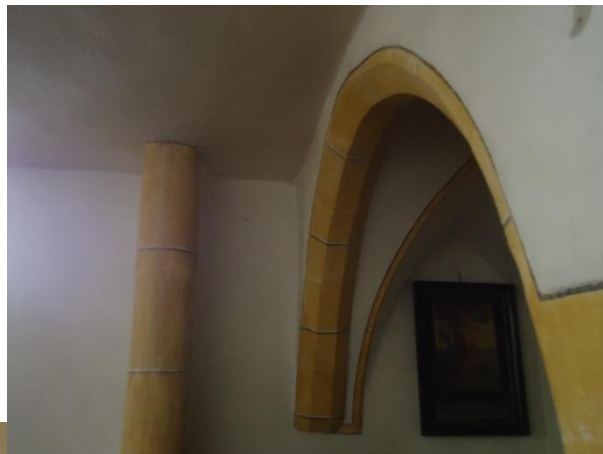
Abb. 91 umbauter Strebepfeiler
