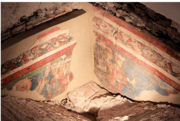
Abb. 11: Gewölbezwickel im Freskensaal
