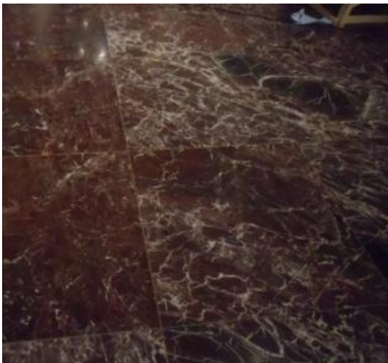
Abb.96: Neuer Fußboden, Saal XXVII, Hochparterre KHM, 2012
