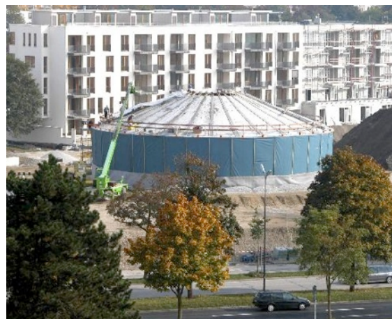
Grafik A.2: LINKS: Aussenansicht des noch unfertigen TANK-Speichers der Münchner Ackermannbögen. Die Konstruktionsphase ist hier noch mäßig fortgeschritten. RECHTS: Endphase des Speichers mit noch fehlender Verkleidung. Quelle: Stadtwerke München GmbH
