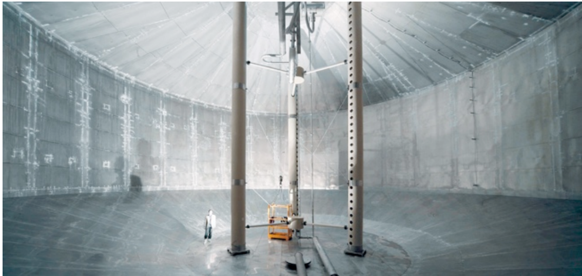
Grafik A.1: Innenansicht des TANK-Speichers der Münchner Ackermannbögen. Der Heißwasserspeicher ist rund 26x16m groß und enthält ein Schichtbeladesystem, welches gut erkennbar an der Mittelkonstruktion angebracht ist. Quelle: Stadtwerke München GmbH
