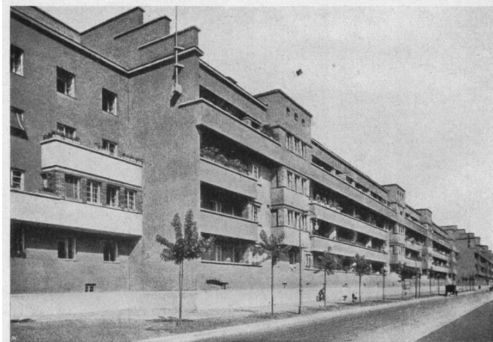
Karl Marxhof. Anderer Teil der Rückenfront. (Man beachte die durchlaufenden Wehrgänge.)
