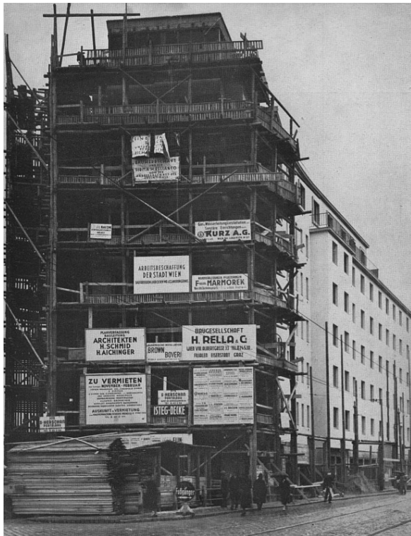
Abb. 14: Das neue Bärenmühlhaus kurz vor der Fertigstellung (Ende 1937)
