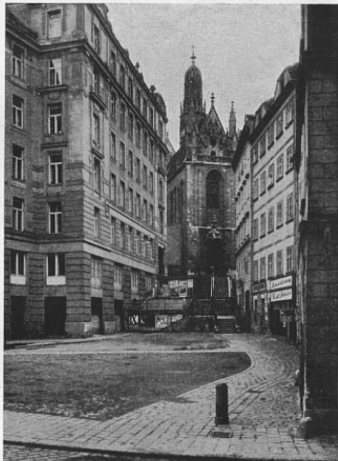
Abb. 17: Wohnraumzerstörung durch den Assanierungsfonds: Freilegung der Kirche Maria am Gestade
