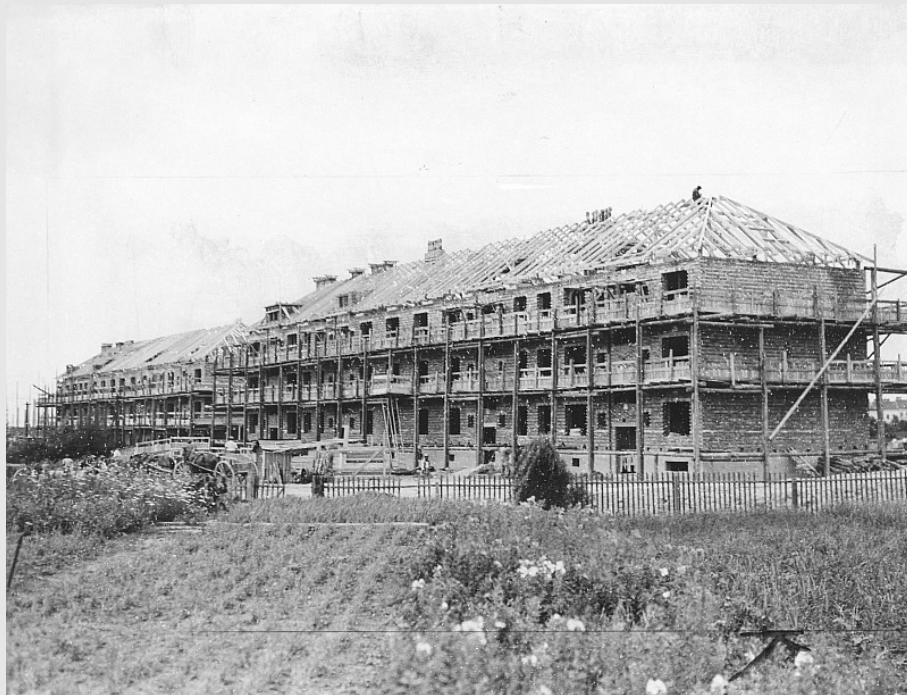
Abb. 25: Rohbauten der ersten beiden Hasenleitener Siedlungsböcke (10.7.1937)
