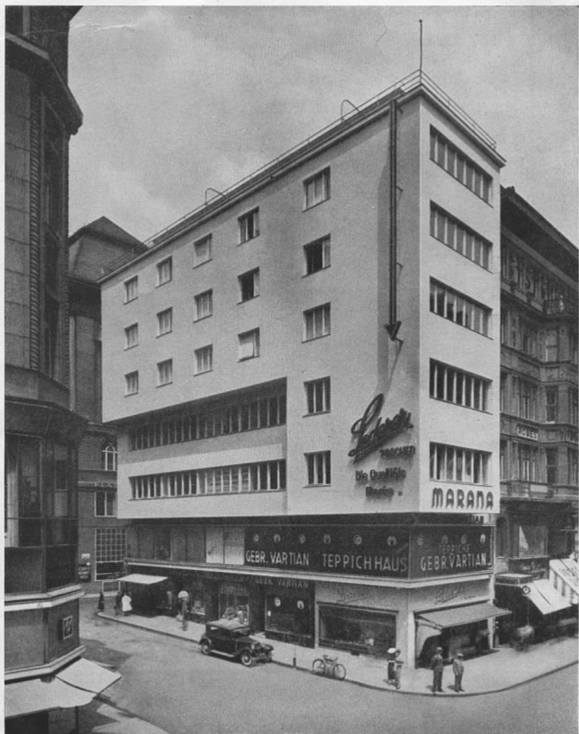
NEUBAU: 7 Geschosse, 12 Wohnungen, 16 Geschäftslokale Entwurf: Ziv.-Arch. Z. V. Heinrich Schmid und Hermann Aichinger Bauausführung: Allgemeine Baugesellschaft A. Porr
