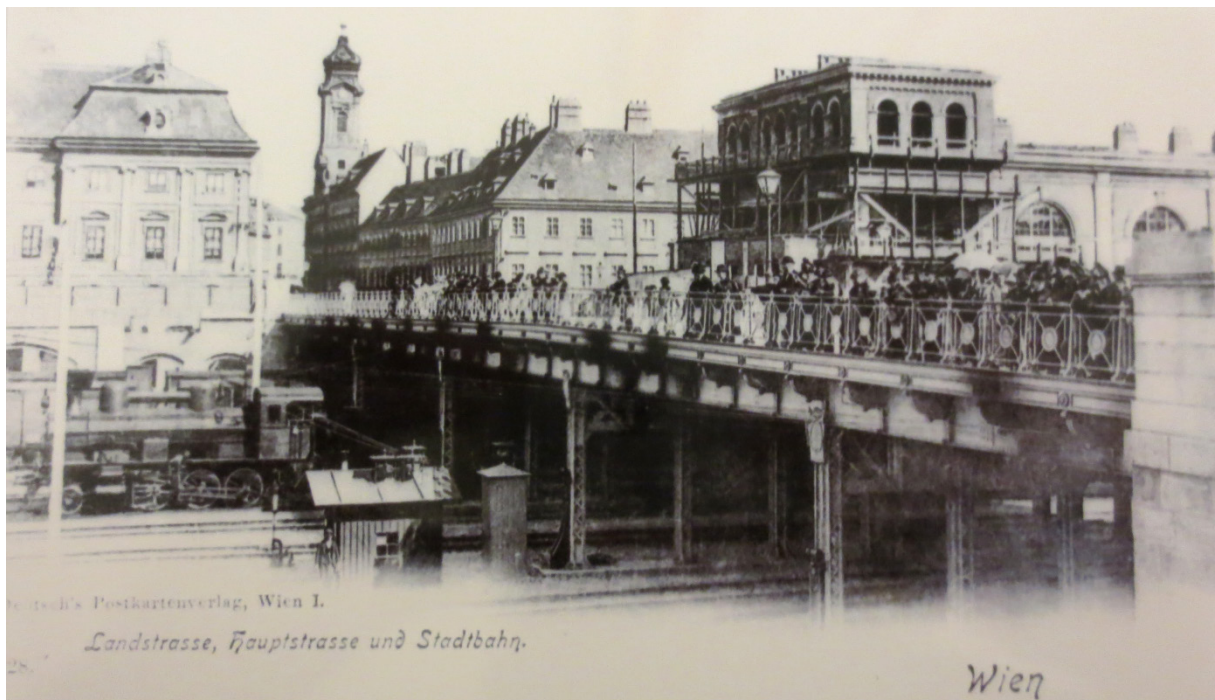
Abbildung 16: Die Erbauung der Fleischhalle 1899. Zudem ist die tiefer gelegte Verbindungsbahn ersichtlich
