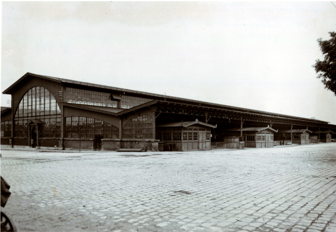
Abbildung 26: Die Rinderhalle bildete einen zentralen Bestandteil des Wiener Zentralviehmarktes. Sie ist neben dem Inlandsschlachthof als einziges Gebäude des Areals noch heute erhalten
