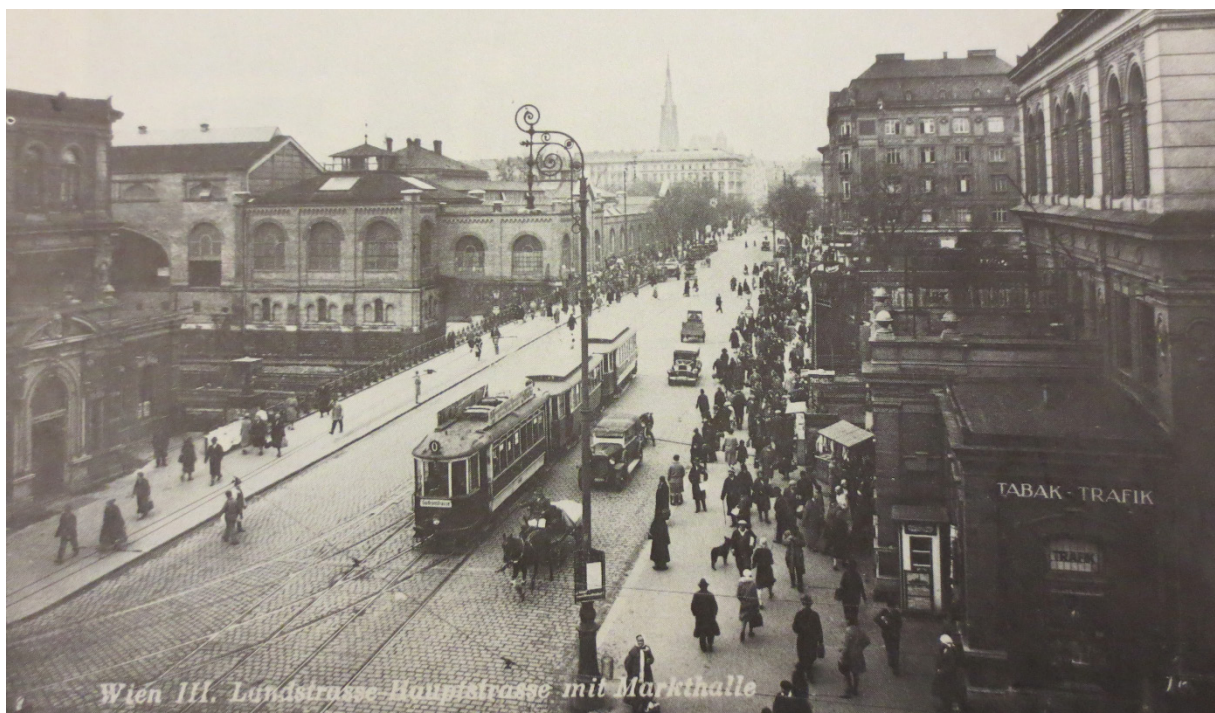
Abbildung 15: Die Großmarkthalle befindet sich im Hintergrund. Vorne rechts liegt die Viktualienhalle, vorne links die Fleischmarkthalle
