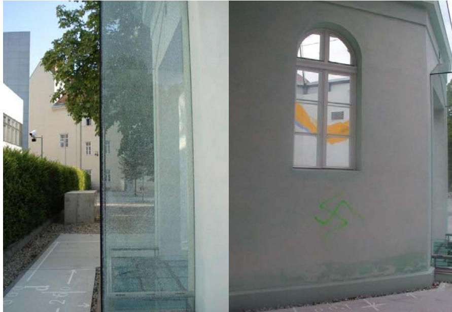
Abbildung 9: Vandalismus am Denk-Mal Marpe Lanefesch 238
