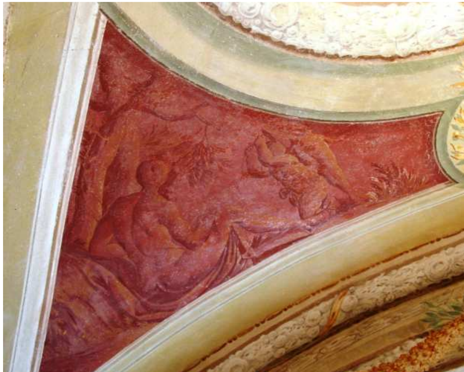
Abb.86: Schloss Vösendorf, Sala terrena, Westwand, nördliche Stichkappe, linkes Zwickelfeld.
