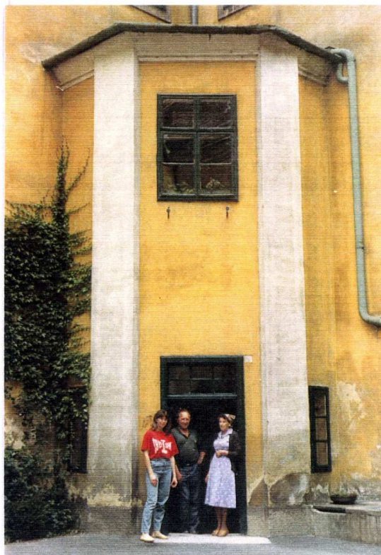
Abb.18: Schloss Vösendorf, Innenhof vor der Revitalisierung.
