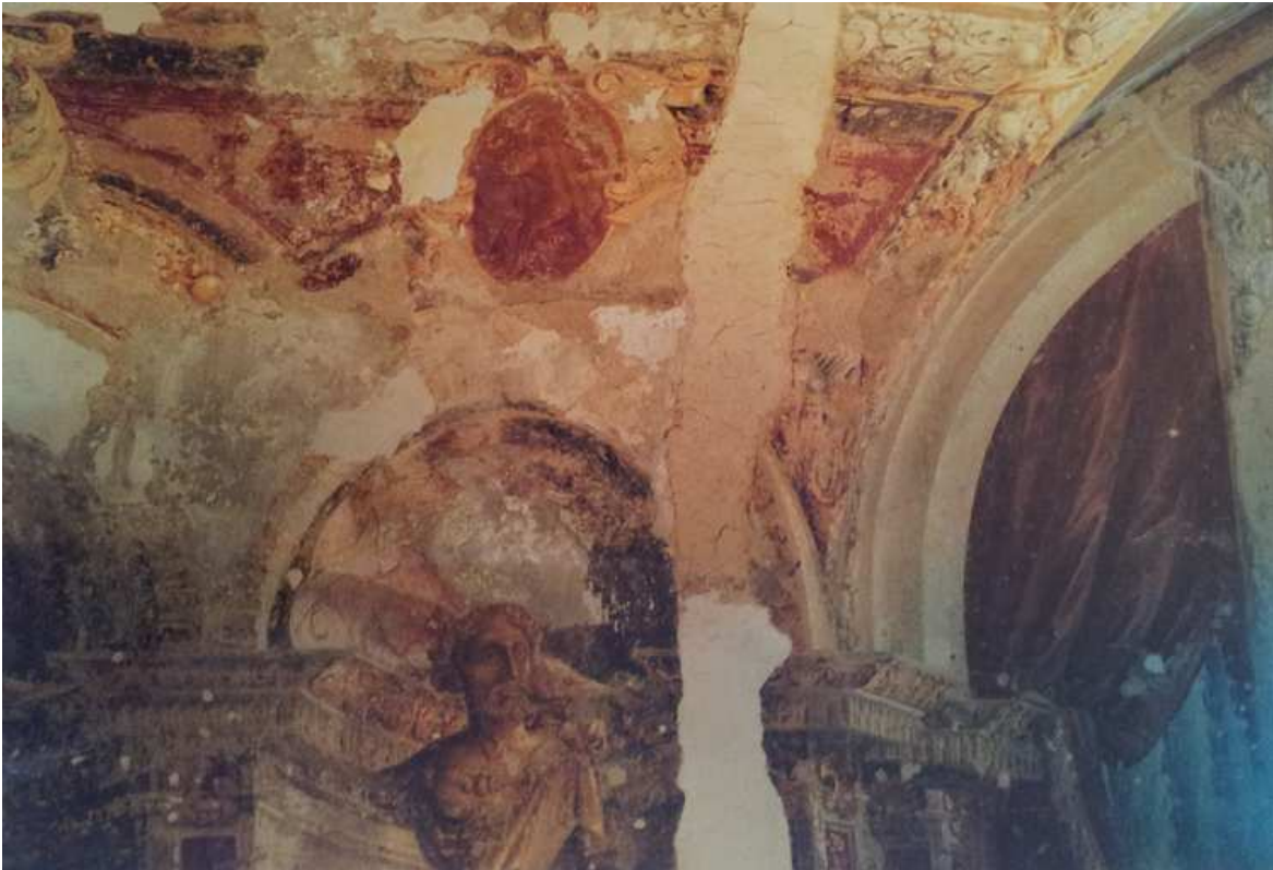
Abb.27: Schloss Vösendorf, Sala terrena, Westwand, Bereich der eingezogenen Wand.
