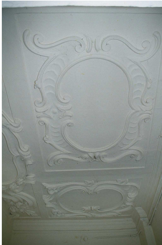
Abb.17: Schloss Vösendorf, Osttrakt, 2. Obergeschoss.
