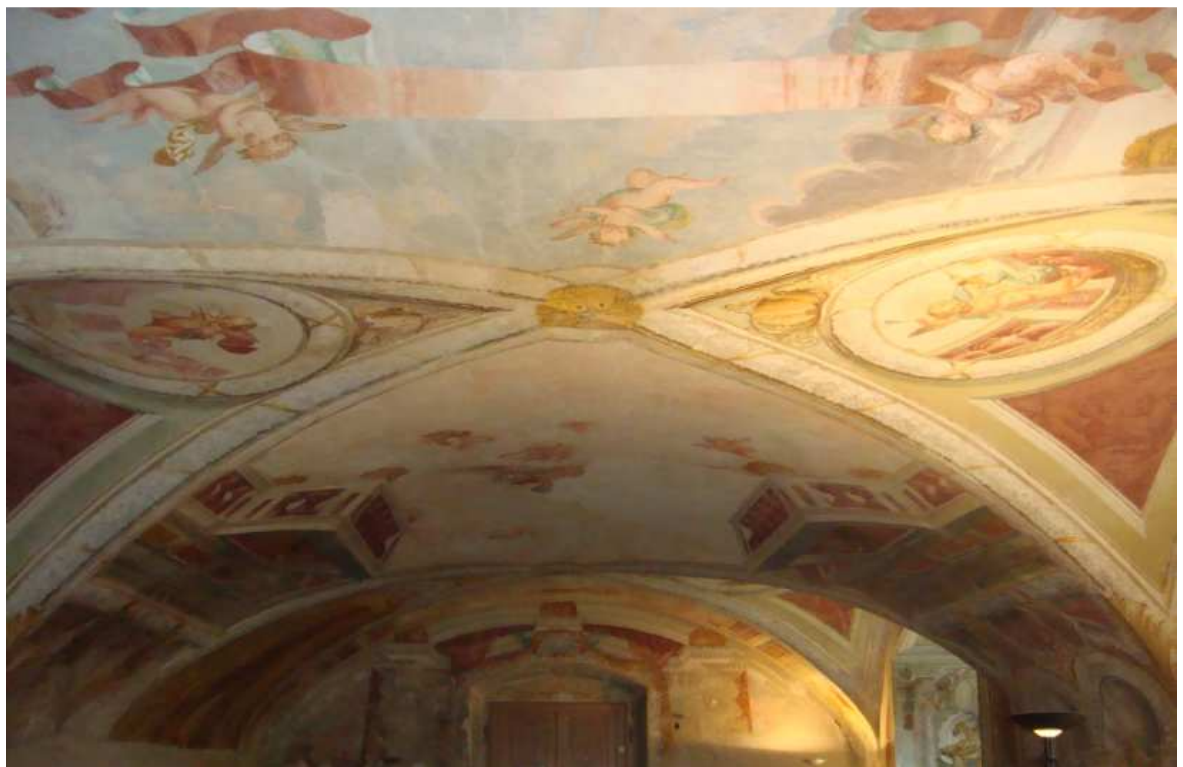
Abb.34: Schloss Vösendorf, Sala terrena. Blick Richtung Süden.
