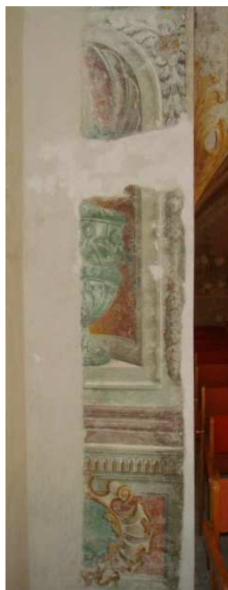
Abb.68: Schloss Vösendorf, Sala terrena, Ostwand, Nische Detail.
