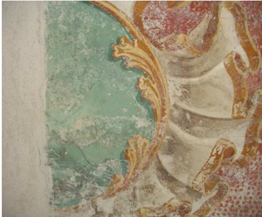
Abb.69: Schloss Vösendorf, Sala terrena, Ostwand, Nische, Detail.
