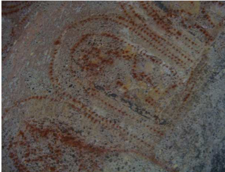
Abb.31: Schloss Vösendorf, Sala terrena, Lochpause, Nische an der Ostwand.
