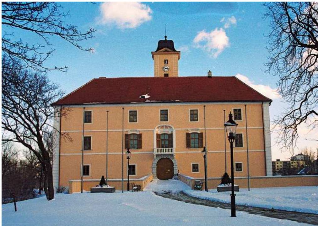
Abb.2: Schloss Vösendorf, Westfassade mit Turm
