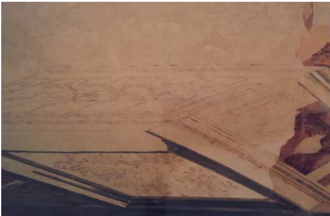
Abb.32: Schloss Vösendorf Sala terrena, Deckenbereich. Ergänzungen.
