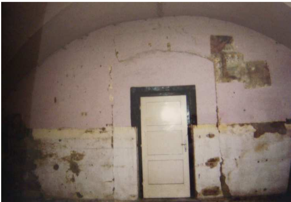
Abb.24: Schloss Vösendorf, Sala terrena, Südwand, Zustand vor der Freilegung.
