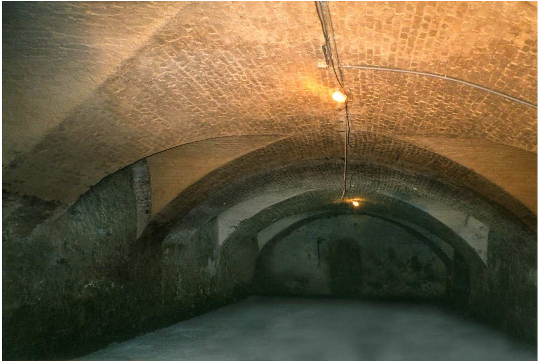
Abb.5: Schloss Vösendorf, Kellergeschoss mit Gewölbe.
