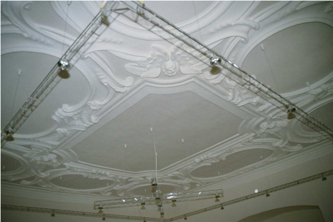
Abb.15: Schloss Vösendorf, Osttrakt, 2. Obergeschoss.
