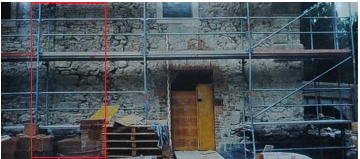
Abb.6: Schloss Vösendorf, abgemauerte Fassade, Südostecke.
