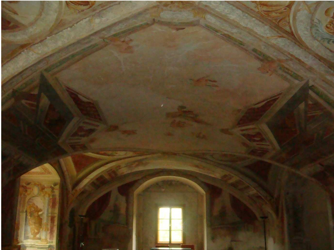
Abb.35: Schloss Vösendorf, Sala terrena, Blick Richtung Norden.
