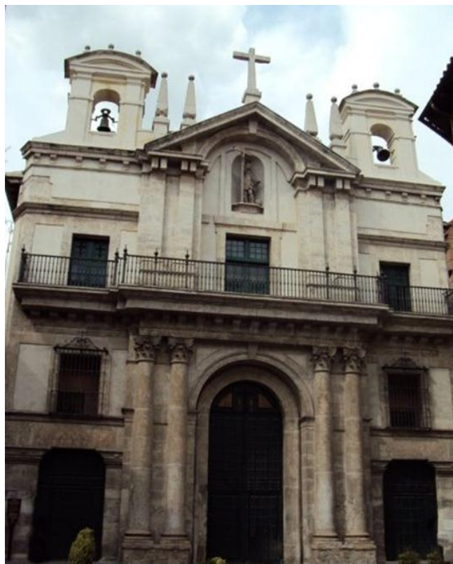
Abb.2: Diego de Praves, Fassade, Ende 16. Jahrhundert, Valladolid, Iglesia de la Santa Vera Cruz
