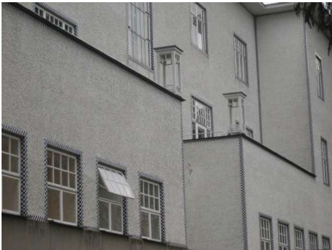
Abb. 92 Josef Hoffmann, Sanatorium Purkersdorf, 1904-1905, Laternen der Westfassade, Zustand 2012.
