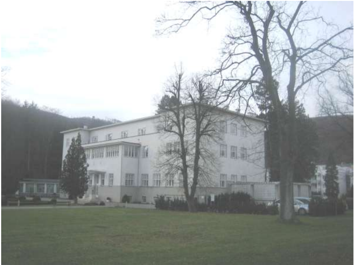
Abb. 72 Josef Hoffmann, Sanatorium Purkersdorf, 1904-1905. Ansicht von der Wiener Straße, Zustand 2012.
