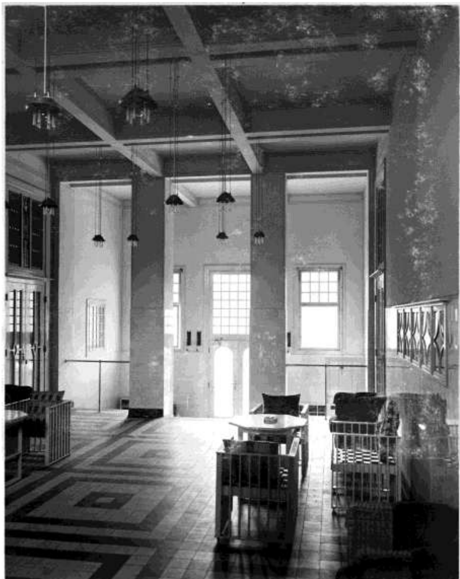
Abb. 121 Josef Hoffmann, Sanatorium Purkersdorf, 1904-1905, Halle, Erdgeschoß, Blick nach Osten, Originalzustand.
