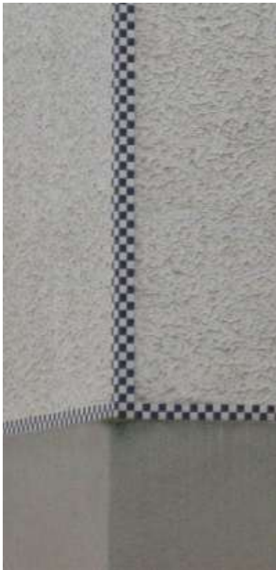
Abb. 103-104 Josef Hoffmann, Sanatorium Purkersdorf, 1904-1905, Ostfassade, Detail der Fliesenbänder an den Gebäudekanten und der Struktur des Putzes, Zustand 2012.
