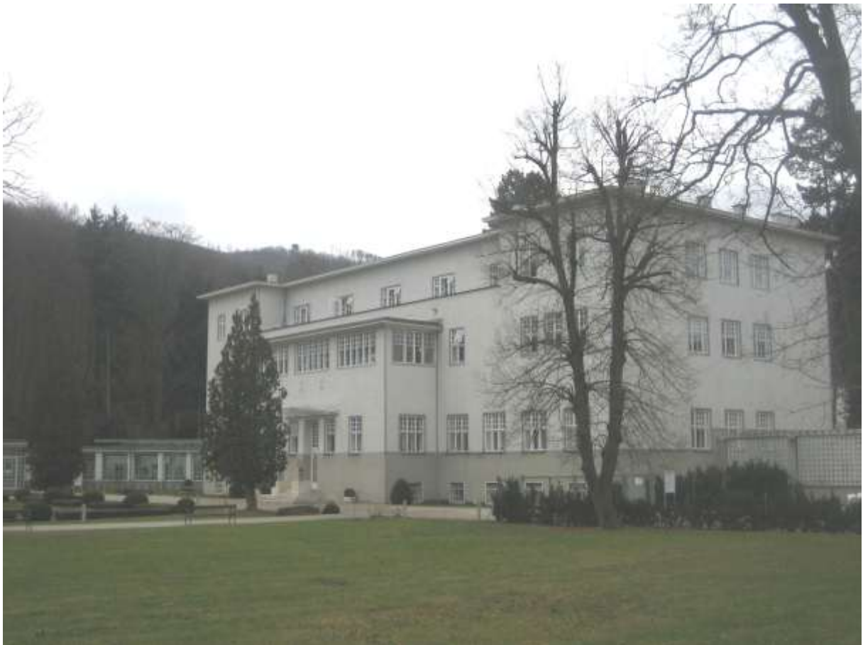
Abb. 11 Josef Hoffmann Sanatorium Purkersdorf (1904-1905), Ansicht von Nordosten, Zustand 2012.
