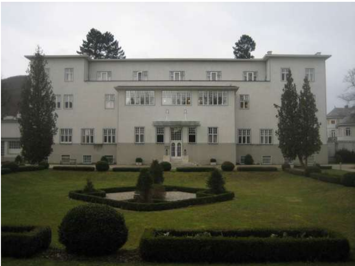
Abb. 105 Josef Hoffmann, Sanatorium Purkersdorf, 1904-1905, Ostfassade, Zustand 2012.
