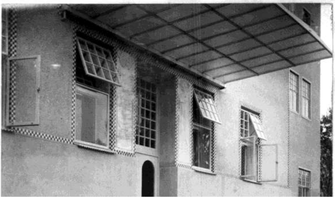
Abb. 100 Josef Hoffmann, Sanatorium Purkersdorf, 1904-1905, Ostfassade, Wellblech an den Sohlbänken der Erdgeschoßfenster, Originalzustand.
