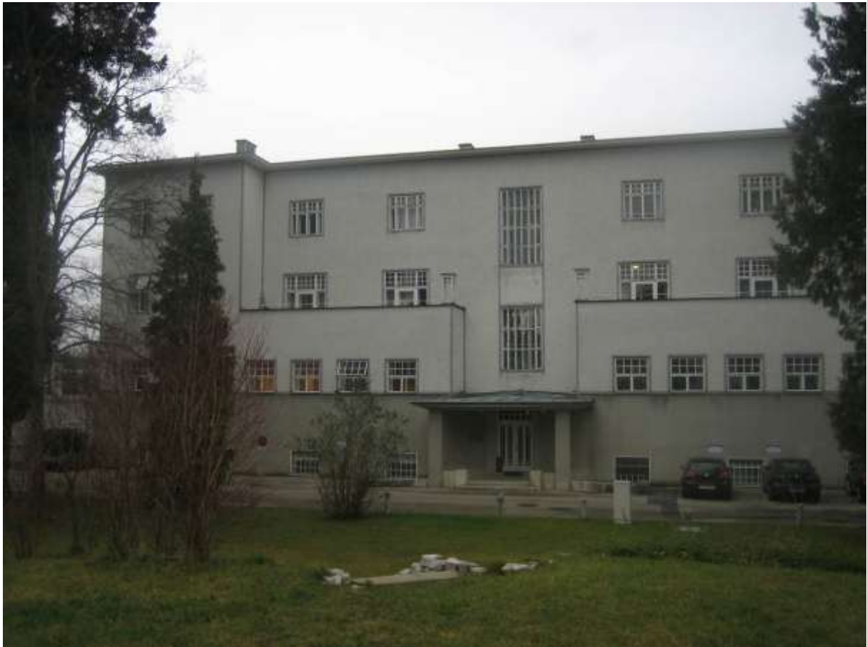
Abb. 91 Josef Hoffmann, Sanatorium Purkersdorf, 1904-1905, Westfassade und Zufahrt, Zustand 2012.
