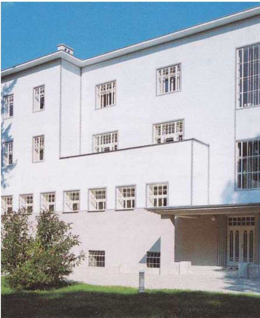
Abb. 214 Josef Hoffmann, Sanatorium Purkersdorf, 1904-1905, Westfassade, Zustand 1995 nach dem Rückbau der Bäderfenster.
