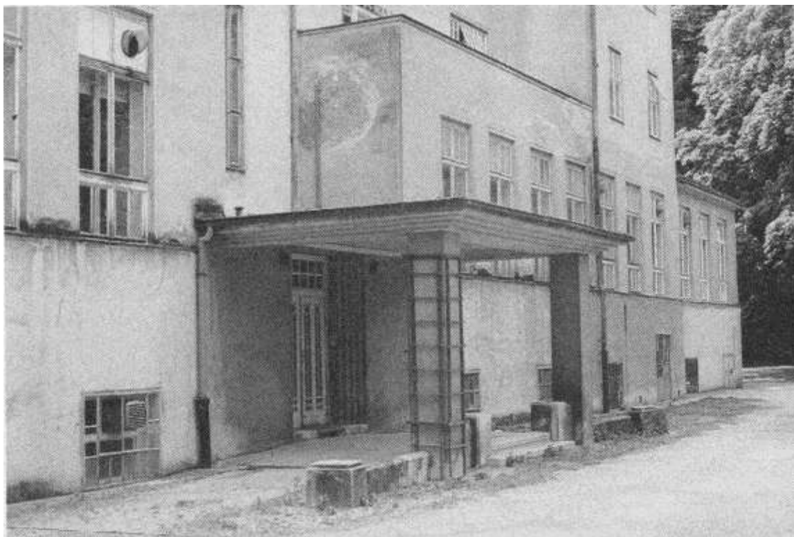
Abb. 78 Josef Hoffmann, Sanatorium Purkersdorf, 1904-1905, westlicher Eingangsbereich, Zustand nach der Vergrößerung der Erdgeschoßfenster ca. 1952, vor dem Rückbau.
