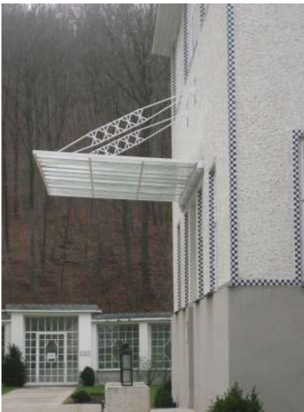
Abb. 98 Josef Hoffmann, Sanatorium Purkersdorf, 1904-1905, gartenseitiger Eingang im Osten mit Vordach und Gitterträgern, Zustand 2012.
