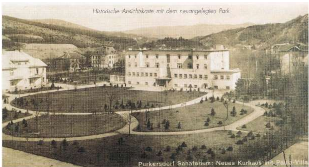
Abb. 115 Josef Hoffmann, Sanatorium Purkersdorf, 1904-1905, Ansicht von Südwesten, Historische Ansichtskarte mit dem neuangelegten Park, Originalzustand nach 1908 (Errichtung der Paula Villa durch Leopold Bauer, im Bild links zu sehen).
