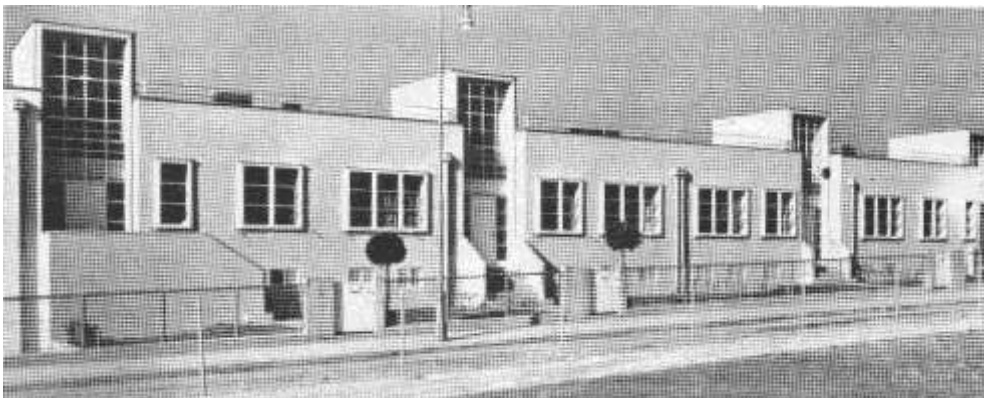
Abb. 291 Josef Hoffmann, Vier Reihenhäuser der Werkbundsiedlung, Wien XIX, Veitingergasse 79-83 (1930-1932). Ansicht von der Veitingergasse.
