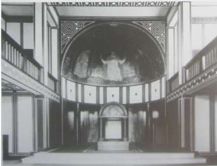
Abb. 316-317 Peter Behrens, Eduard-Müller-Krematorium in Hagen-Delstern, 1906-1907, Ansicht außen und innen.
