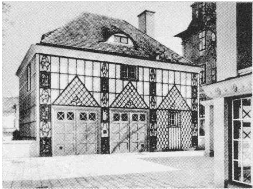
Abb. 282 Josef Hoffmann, Villa Skywa-Primavesi (1913- 1915), Garage und Pförtnerhaus.
