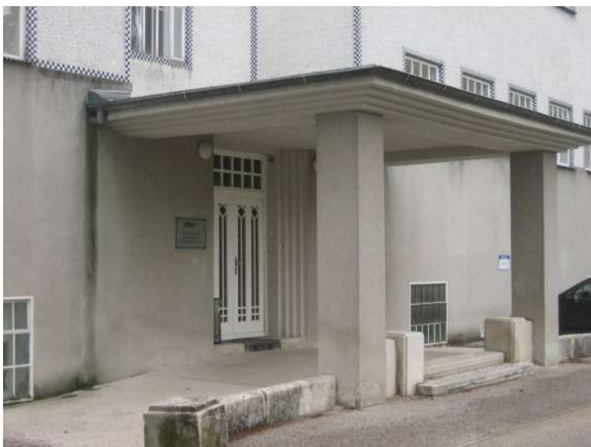
Abb. 79 Josef Hoffmann, Sanatorium Purkersdorf, 1904-1905, westlicher Eingangsbereich, Zustand 2012.
