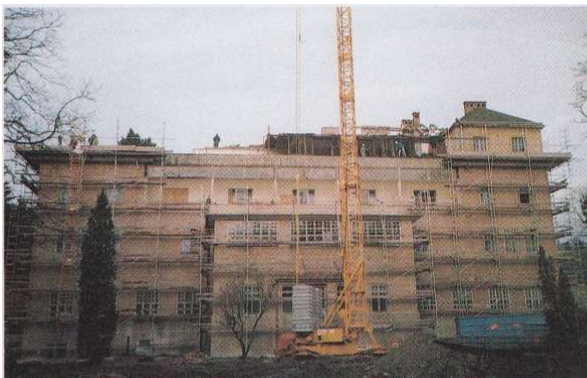
Abb. 218 Josef Hoffmann, Sanatorium Purkersdorf, 1904-1905, Ostfassade, Zustand während der Abstockung im März 1995.
