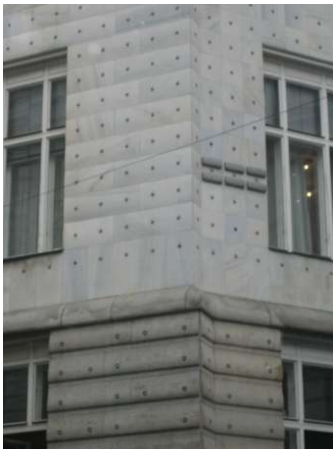
Abb. 328-329 Otto Wagner, Postsparkasse, Hauptfassade und Detail der oberen Stockwerke mit den vermeintlich durch Aluminiumnieten befestigten Marmorplatten, 1904-1906.
