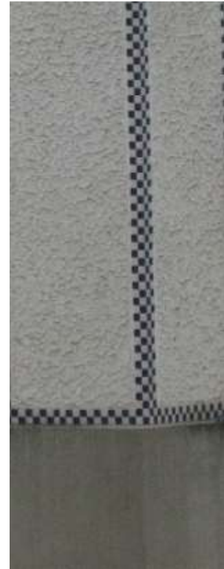
Abb. 103-104 Josef Hoffmann, Sanatorium Purkersdorf, 1904-1905, Ostfassade, Detail der Fliesenbänder an den Gebäudekanten und der Struktur des Putzes, Zustand 2012.
