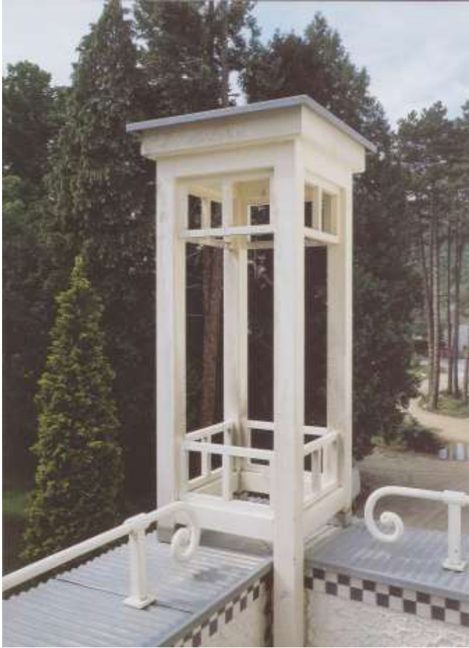
Abb. 89 Josef Hoffmann, Sanatorium Purkersdorf, 1904-1905. Holzlaternen über dem Westeingang und Brüstungsabdeckungen aus Wellblech, Zustand nach der Restaurierung von 1994-1996.
