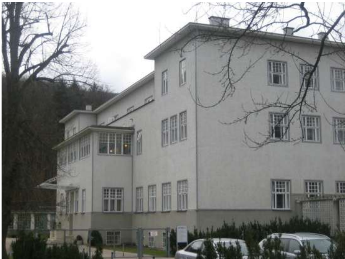
Abb. 107 Josef Hoffmann, Sanatorium Purkersdorf, 1904-1905, Ansicht von Nord-Osten, Zustand 2012.
