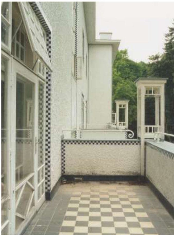
Abb. 90 Josef Hoffmann, Sanatorium Purkersdorf, 1904-1905. Holzlaternen und Balkone über dem Westeingang, Zustand nach der Restaurierung von 1994-1996.
