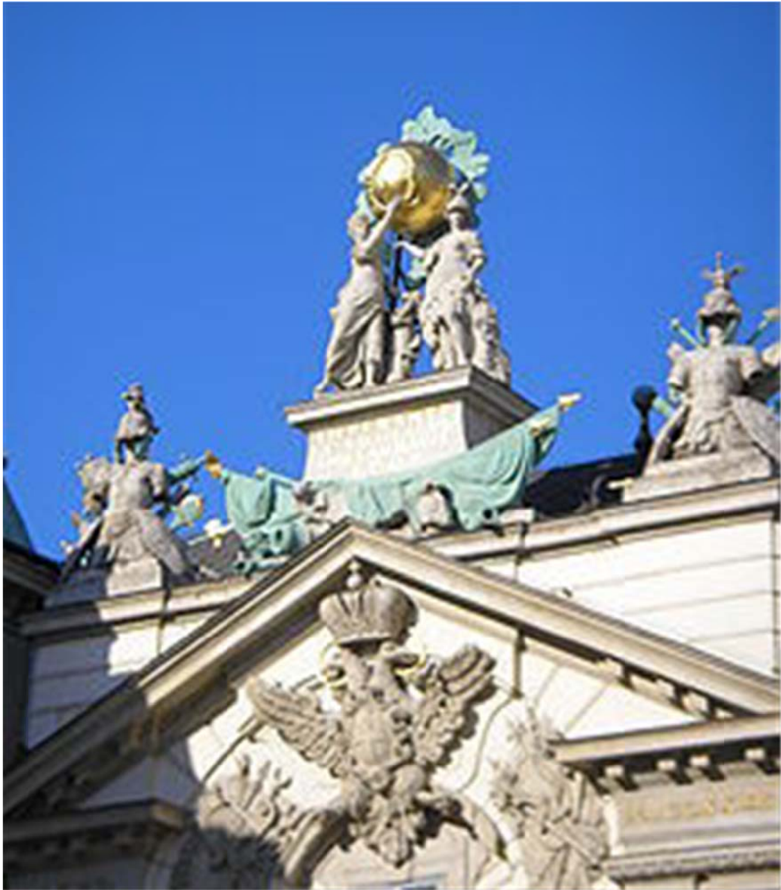
Abb. 57. Fassade des Bürgerlichen Zeughauses, 1731-32 [Am Hof, Wien]
