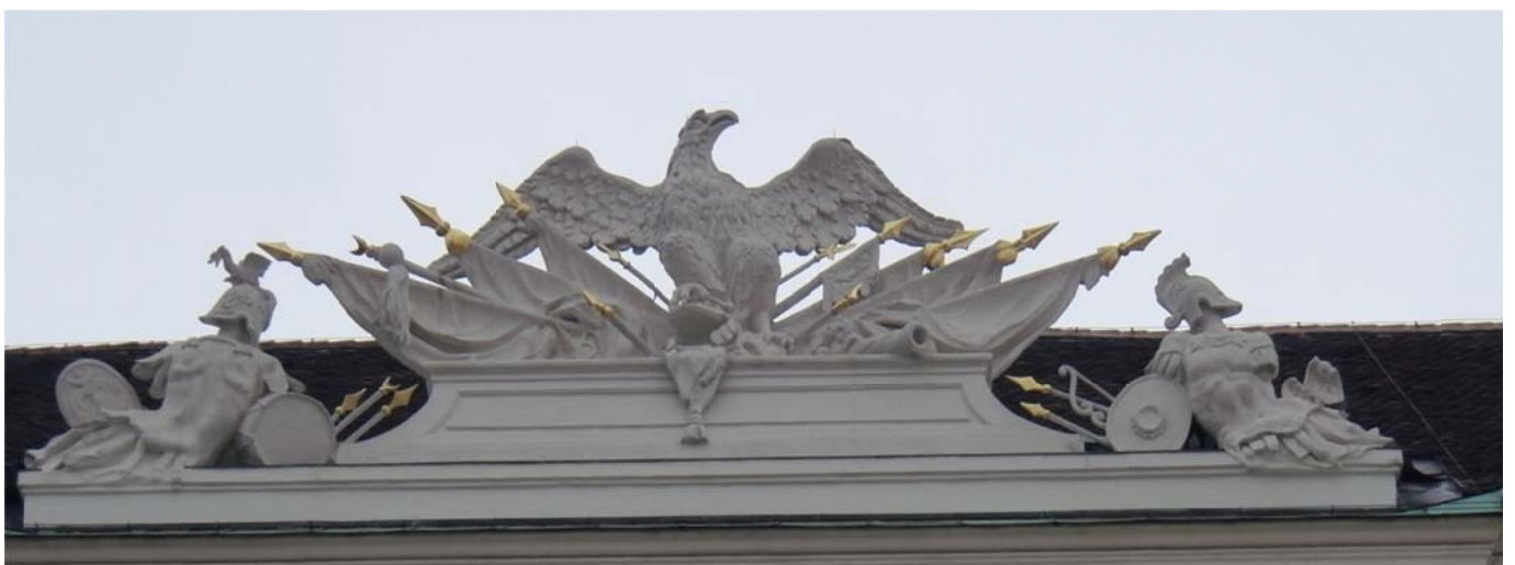
Abb. 58. Attika Trophäe mit römischem Adler über der rechten Risalit der Reichskanzlei [Wien]
