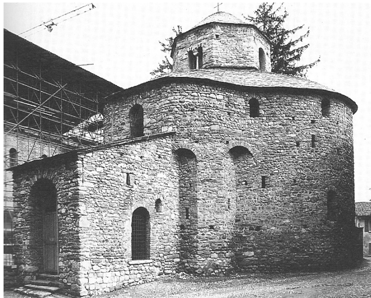
Abb. 71: Galliano in Cantu, Baptisterium, Ansicht von Süd-Westen (Manuel Kling)
