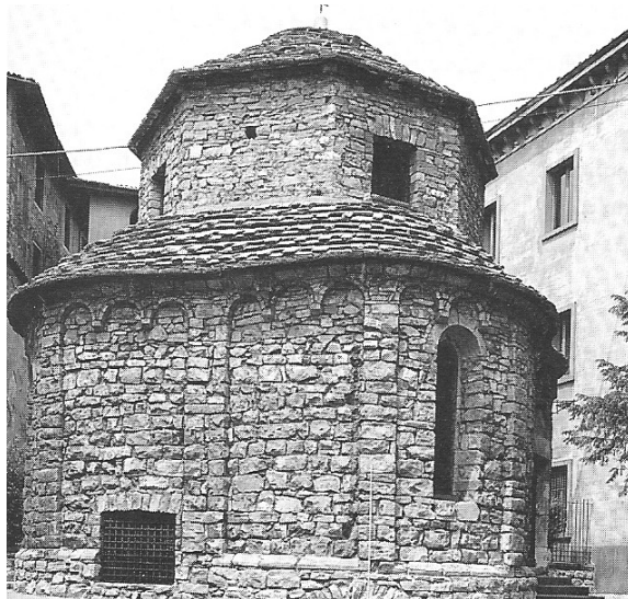
Abb. 67: Bergamo, Capella di Santa Croce, Ansicht von Süd-Ost (Manuel Kling)
