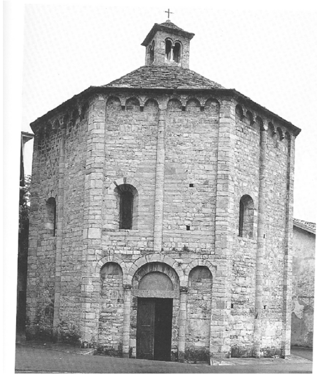
Abb. 63: Lenno, Baptisterium, Ansicht von Westen (Manuel Kling)
