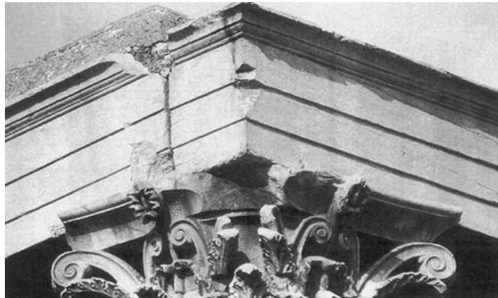
1. Athen, Olympieion, SO-Ecke des Architravs
