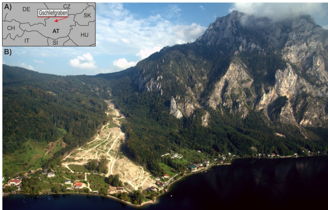
Abbildung 20: Gschliefgraben: Lage in Österreich, Gesamtüberblick des instabilen Hanges
