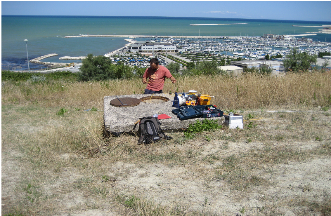
Abbildung 46 : Installation der Piezometer in den Bohrlöchern
