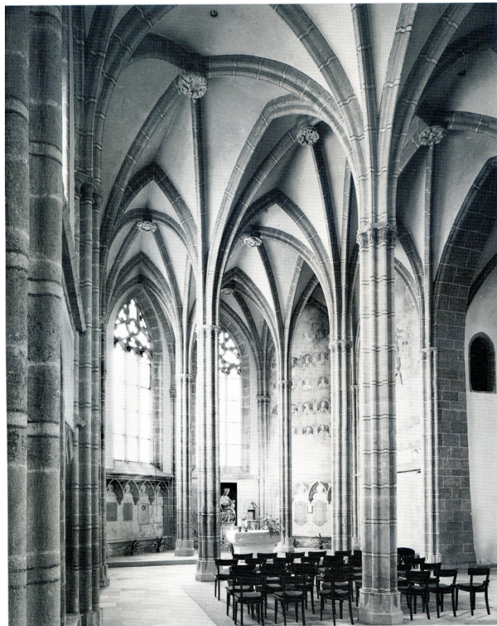
Abb.53 Innenansicht der Wallseerkapelle
