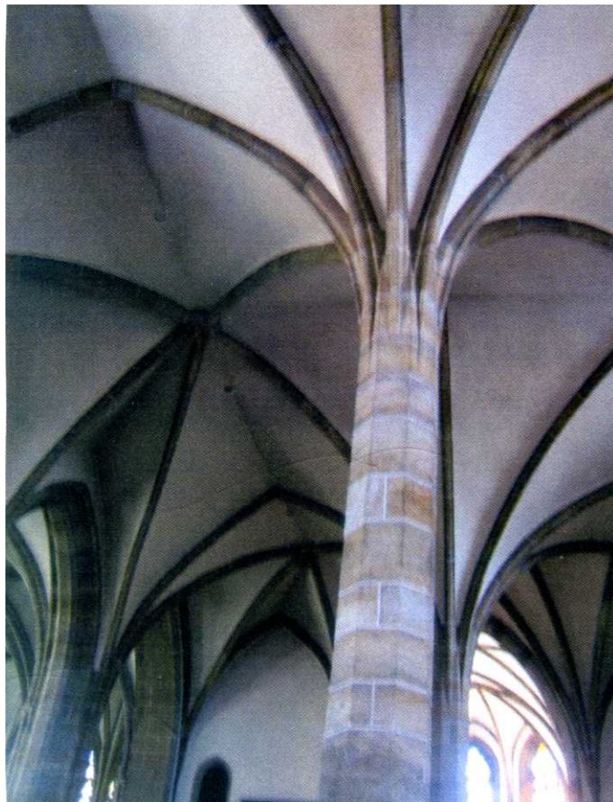
Abb.41 Achteckpfeiler der ehemaligen Minoritenkirche in Enns
