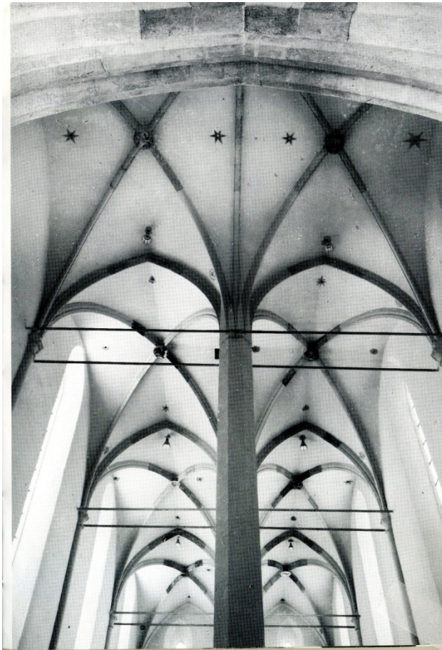
Abb.34 Gewölbe der ehemaligen Dominikanerkirche in Imbach
