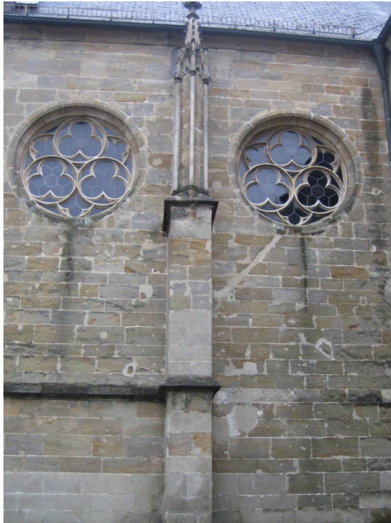
Abb.14 Zwei Rundfenster in der Westwand der Wallseerkapelle
