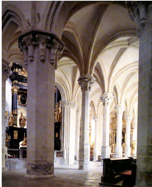
Abb.36 Innenansicht des Hallenchors der Zisterzienser-Stiftskirche in Lilienfeld
