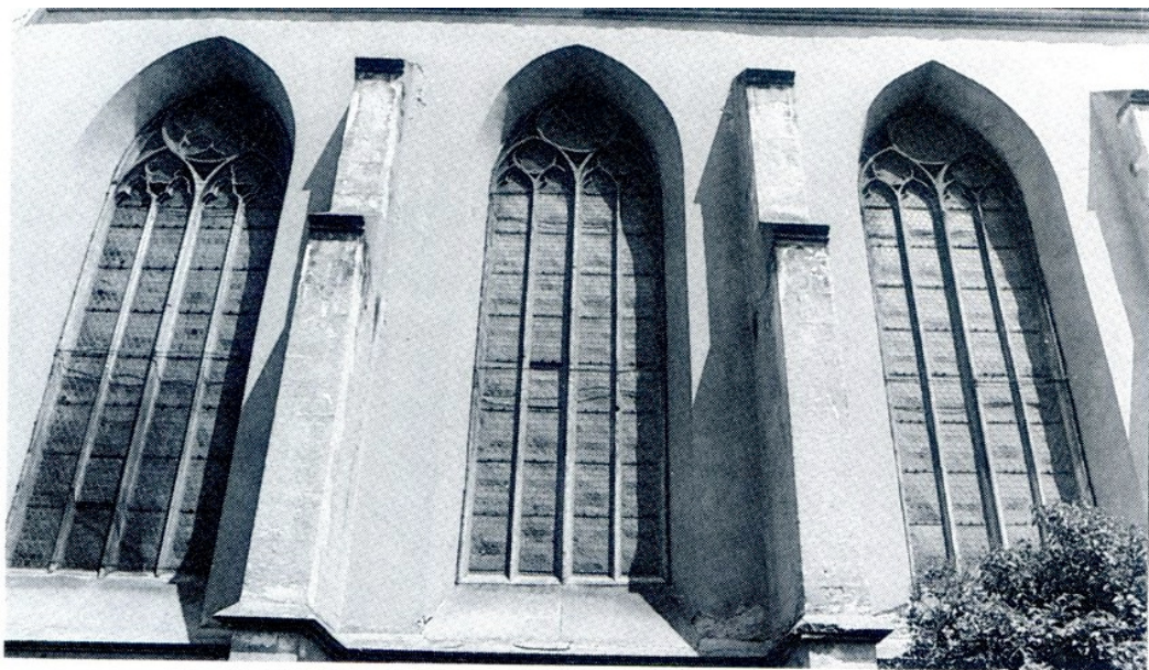
Abb.45 Außenansicht Südwand der Leechkirche in Graz
