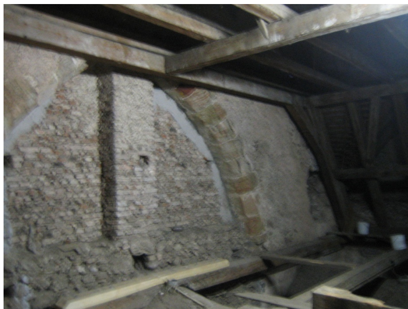
Abb.7 Teil des Dachbodens der Minoritenkirche in Enns
