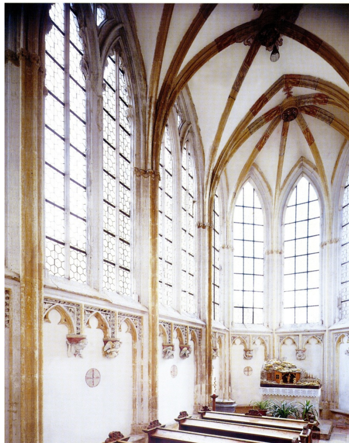
Abb.47 Innenansicht der Katharinenkapelle nach Osten in Imbach
